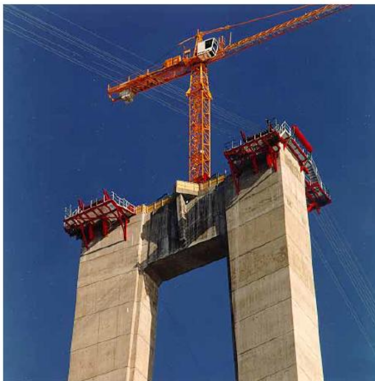
Σχήμα 1.5: Ανέγερση πυλώνα μορφής A
