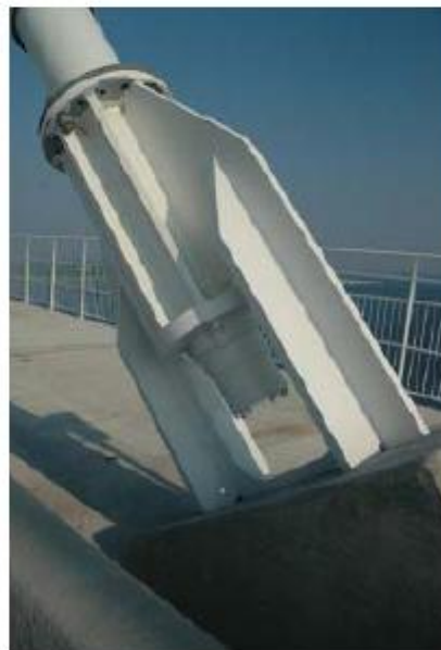
Σχήμα 1.8: Αγκυρώσεις καλωδίων επί του καταστρώματος
