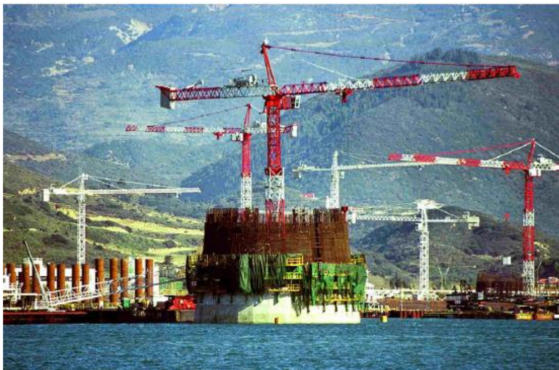
Φωτογραφίες από την κατασκευή των βάσεων των πυλώνων
