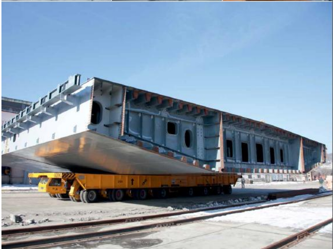
Τα πάνελ του καταστρώματος
