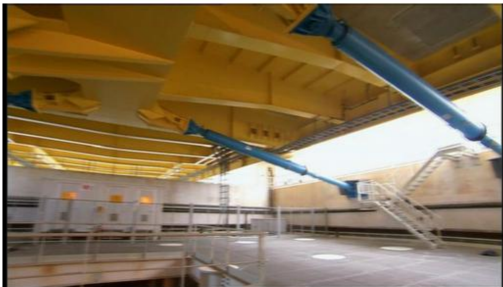
Σχήμα 1.13 : Σύνδεση καταστράματος-πυλώνων στη γέφυρα Ρίου-Αντιρρίου
