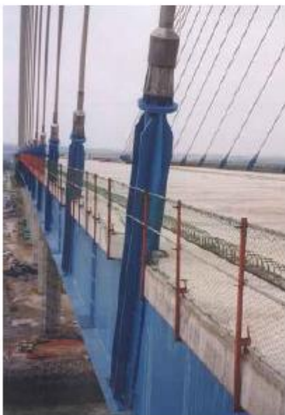
Σχήμα 1.8: Αγκυρώσεις καλωδίων επί του καταστρώματος
