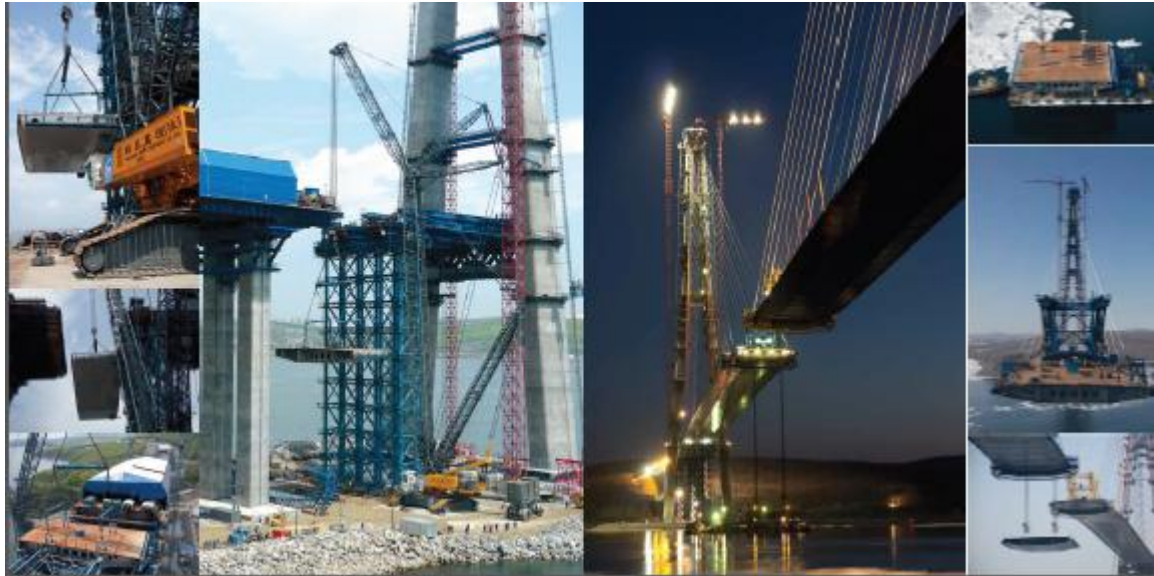
Εργασίες ανέγερσης καταστρώματος
