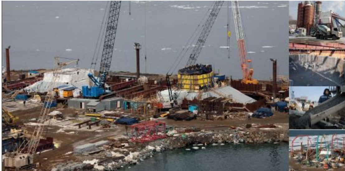
Κατασκευή βάσεων πυλώνων
