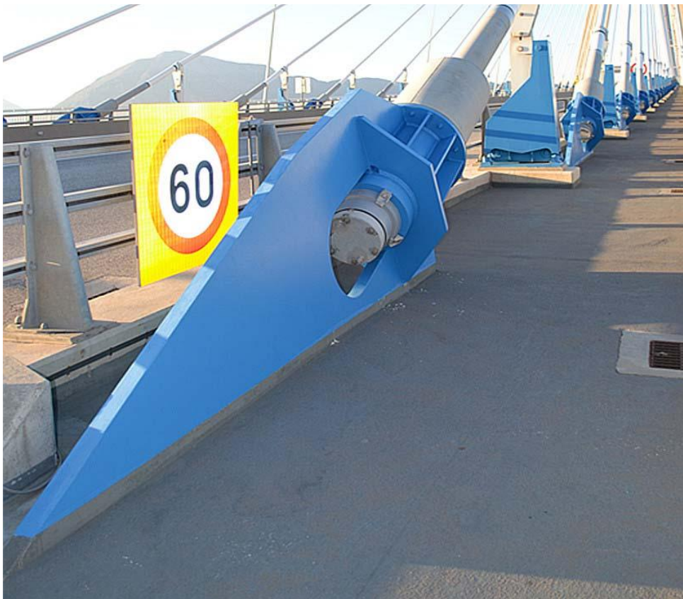
Φωτ. 5.6 : Αγκυρώσεις καλωδίων επί του καταστρώματος.
