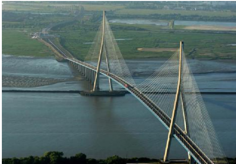
Σχήμα 2.2.2 : Normandy Bridge [30, Ηλεκτρονικές Πηγές Φωτ.: (7)]
