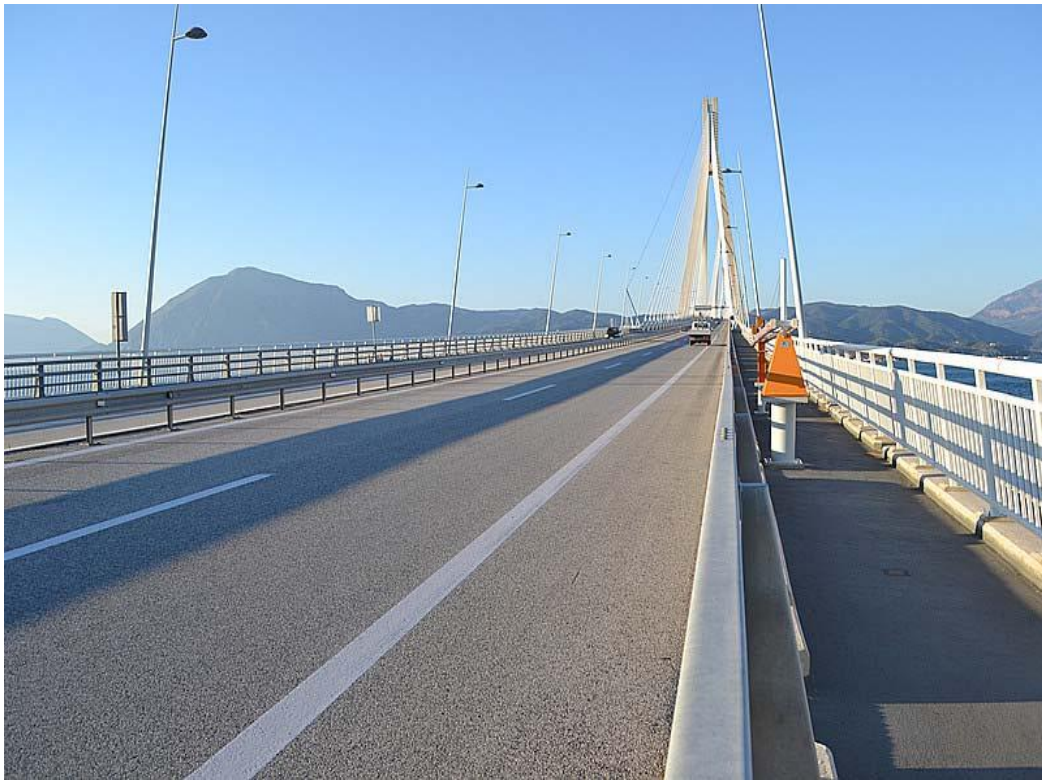
Φωτ. 5.3 : Το κατάστρωμα της γέφυρας.
