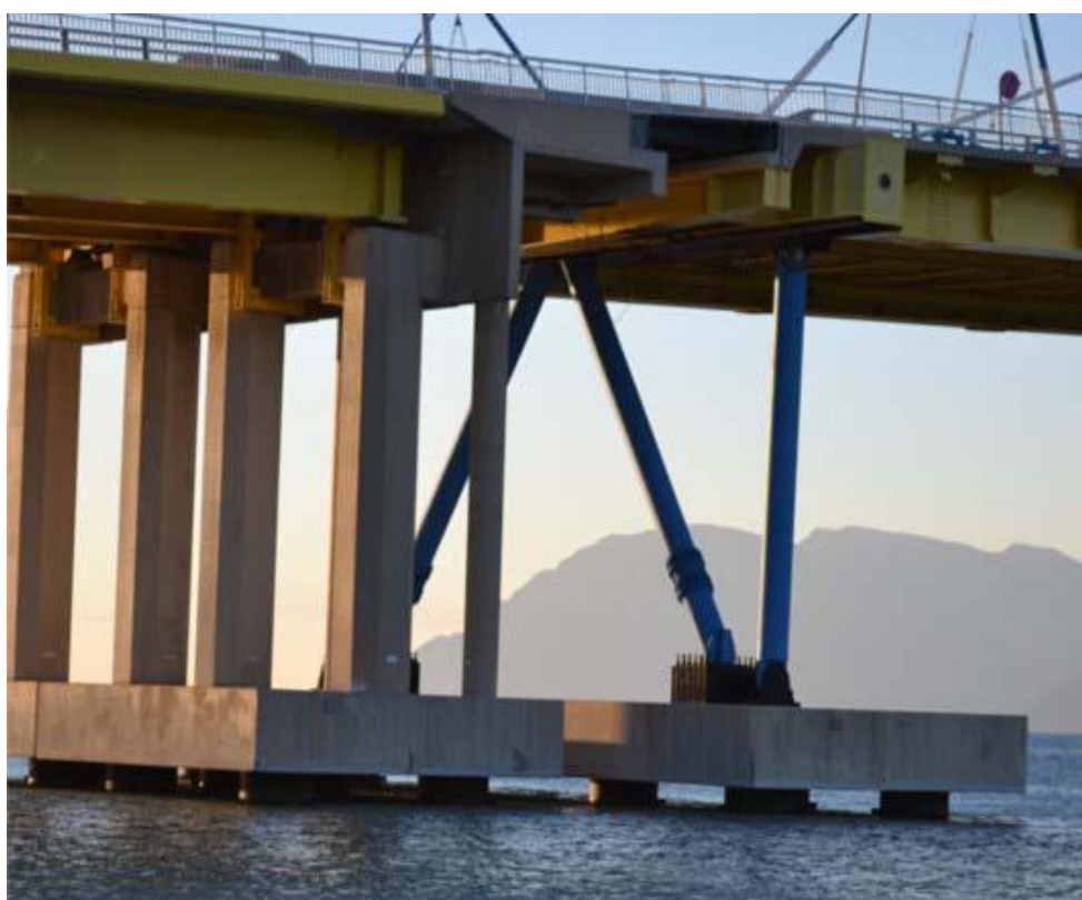
Φωτ. 5.9 : Μεταβατικό βάθρο - Μεταλλικό αρθρωτό πλαίσιο.
