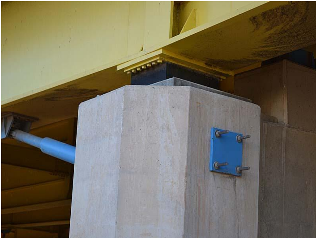
Φωτ. 5.8 : Αποψη εφεδράνου στην κεφαλή βάθρου της γέφυρας πρόσβασης.
