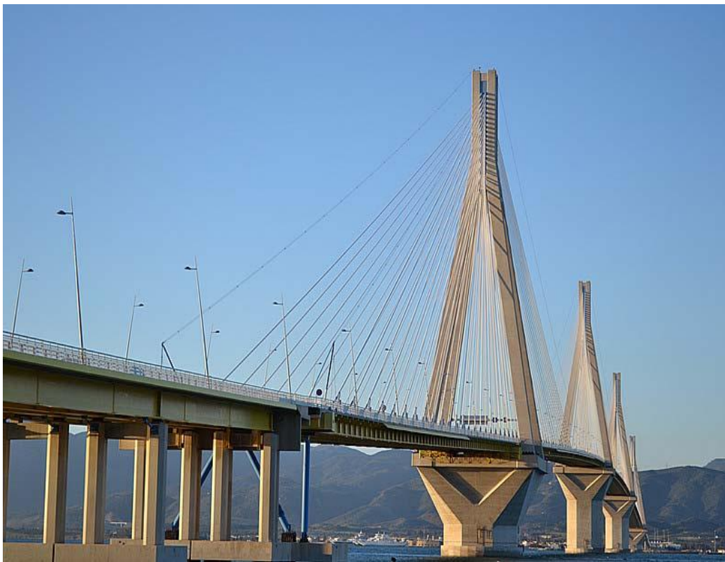
Φωτ. 5.1 : Η γέφυρα Ρίου - Αντιρρίου (από Ρίο).
