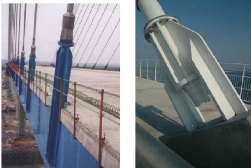
Σχήμα 2.2.9: Αγκυρώσεις καλωδίων επί του καταστρώματος [Ι. Μαργάρας, 2008]
