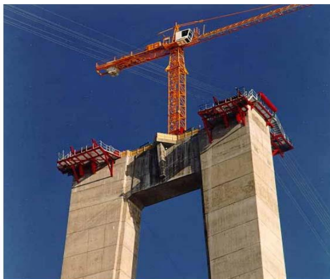
Σχήμα 2.2.11 : Ανέγερση πυλώνα μορφής Α [Ι. Μαργάρας, 2008]
