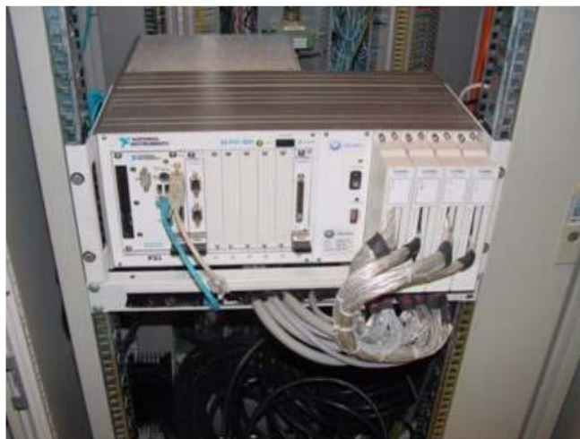
Σχήμα 4.3.5 : Μονάδα ψηφιοποίησης και καταγραφής δεδομένων [Π. Παναϊκόλας κ.α., 2009]
