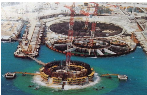
Σχήμα 4.1.2: Άποψη της ξηράς δεξαμενής στην πλευρά του Αντιρρίου [Χ. Τζαναβάρα, 2009]
