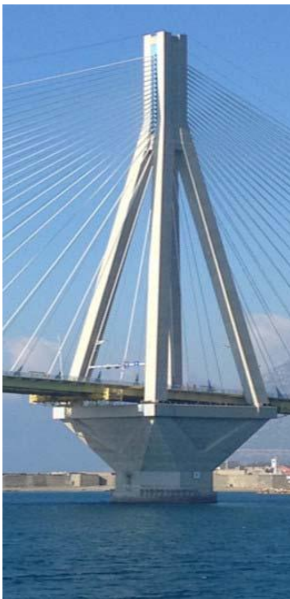
Φωτ. 5.4 : Ο πυλώνας της γέφυρας Ρίου – Αντιρρίου.
