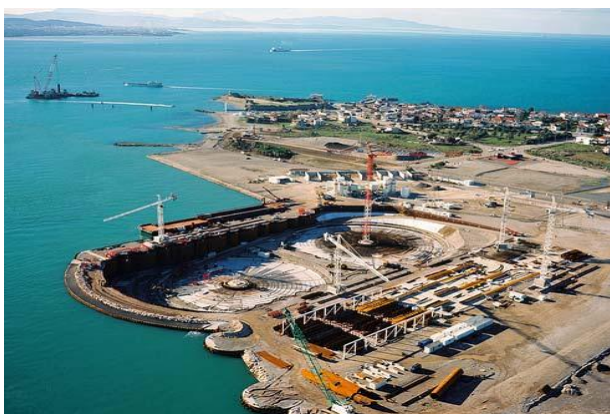
Σχήμα 4.1.1 : Ξηρά δεξαμενή [30, Ηλεκτρονικές Πηγές Φωτ.: (9)]
