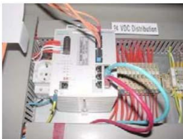
Σχήμα 4.3.6 : Δίκτυο διπλών οπτικών ινών [Π. Παναϊκόλας κ.α., 2009]
