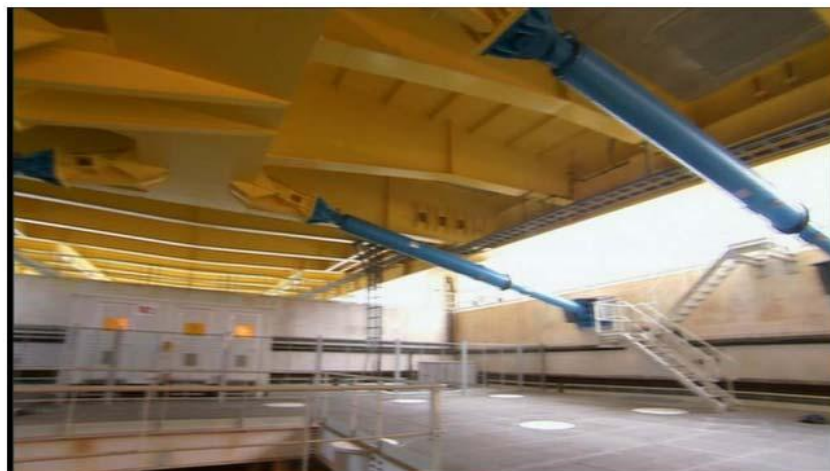
Σχήμα 2.2.16 : Σύνδεση καταστρώματος-πυλώνων στη γέφυρα Ρίου-Αντιρρίου [Ι. Μαργάρας, 2008]
