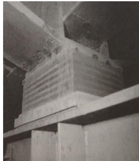
Σχήμα 1.3.12 : Ελαστομεταλλικά εφέδρανα : (i) σχηματική τομή, (ii) εφέδρανο σε στήριξη γέφυρας [Δ. Θεοδωρακόπουλος, κλπ., 2003]
