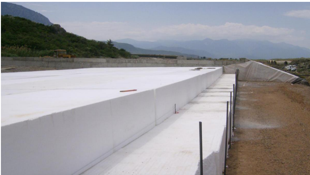
Σχήμα 5.12 Αποφυγή κατακόρυφων αρμών
