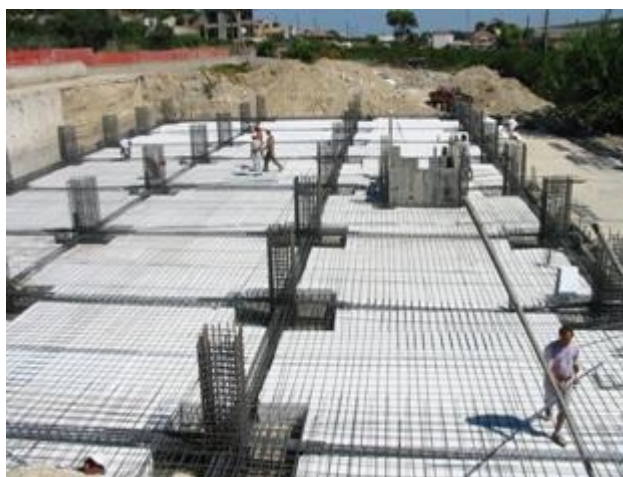
Σχήμα 3.5 Οπλισμός δαπέδου πάνω από EPS
