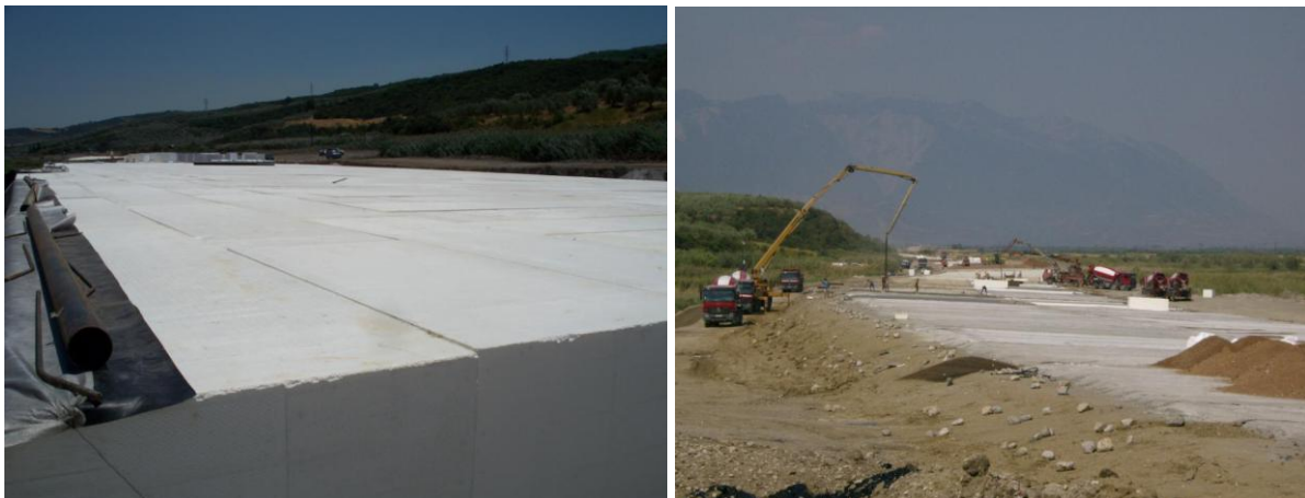
Σχήμα 5.14 Κατασκευή ελαφρού επιχώματος
