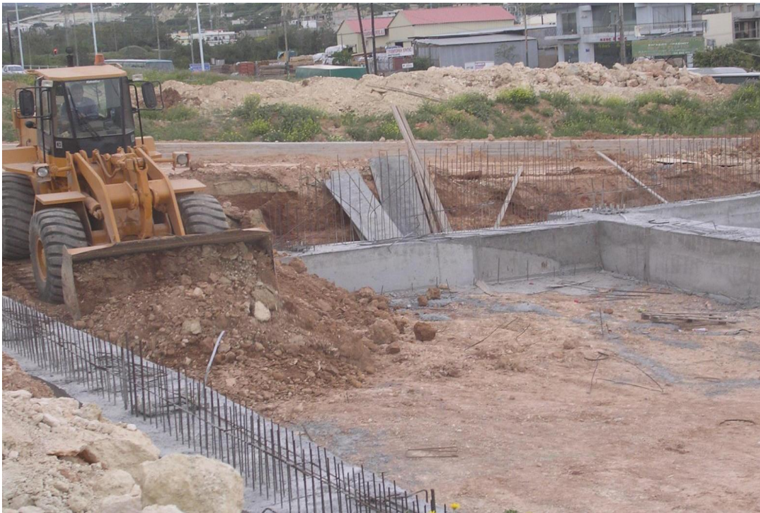
Σχήμα 3.12 Μπάζωμα θεμελίων με μηχανικά μέσα
