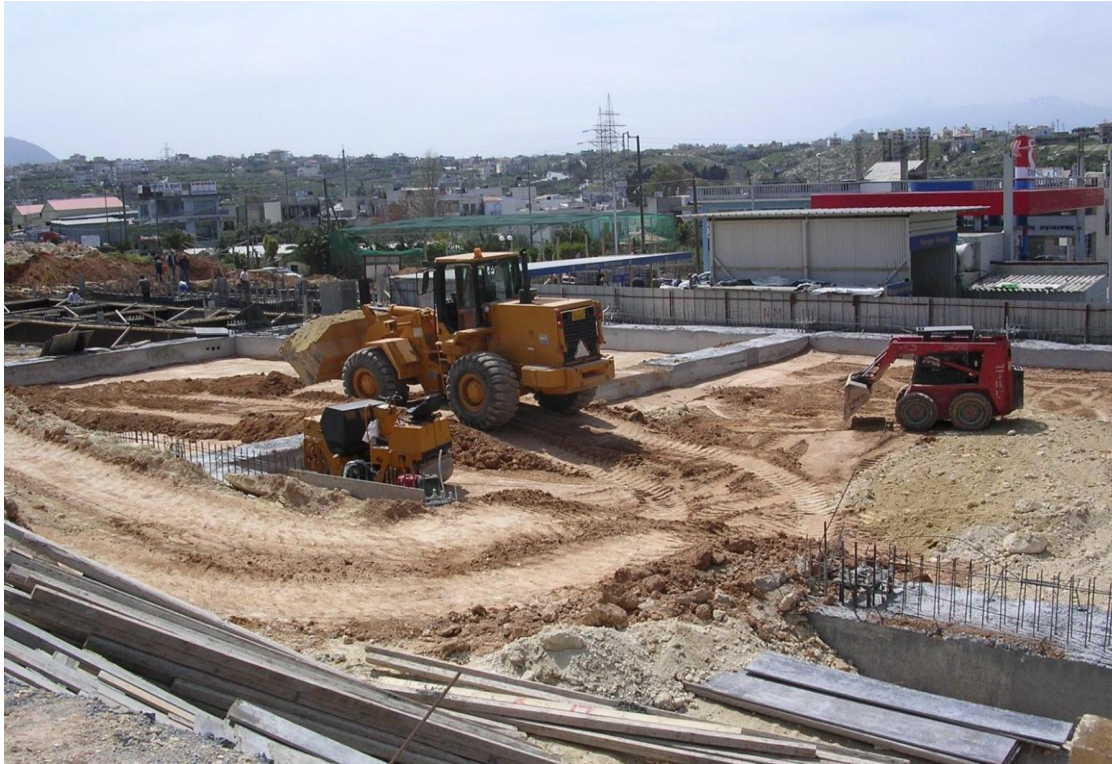
Σχήμα 3.14 Επιχωματώσεις σε στρώσεις ανά 30cm με διάβροξη συμπίκνωση
