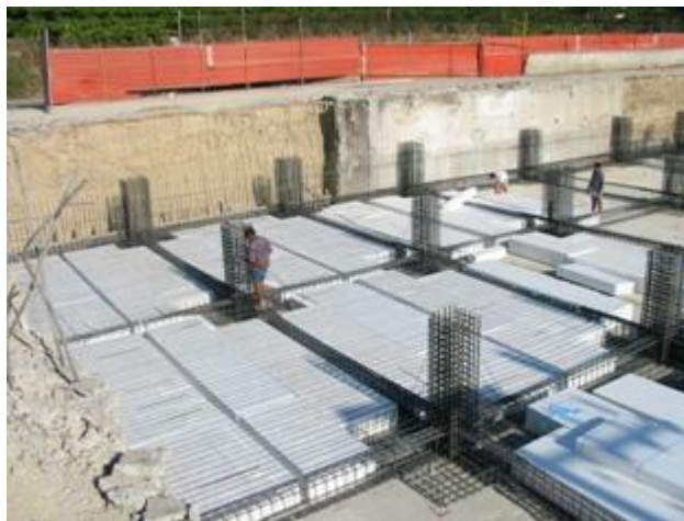
Σχήμα 3.4 Πλήρωση κενών θεμελίων με EPS
