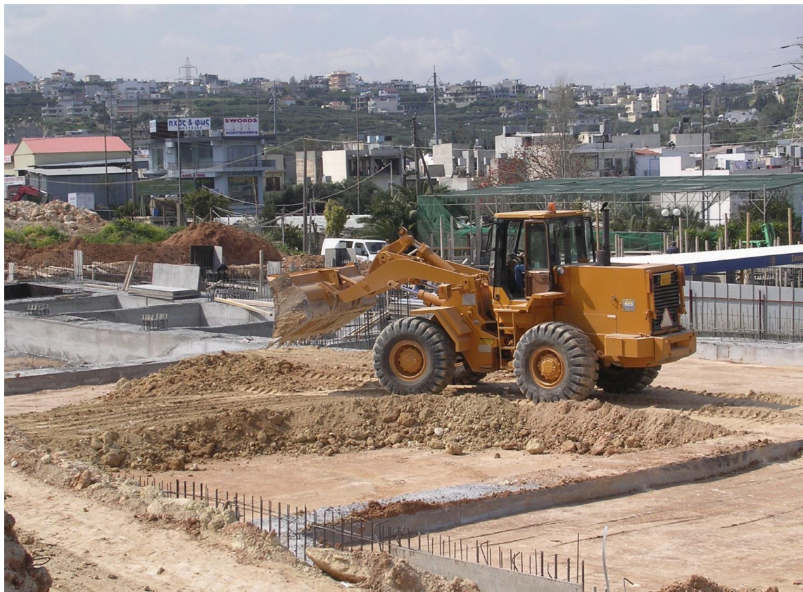
Σχήμα 3.14 Επιχωματώσεις σε στρώσεις ανά 30cm με διάβροξη συμπίκνωση
