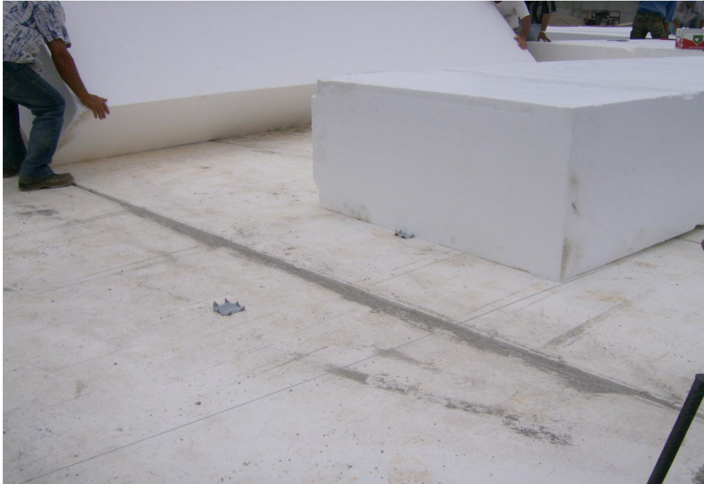
Σχήμα 5.13 Σύνδεση με μεταλλικά στοιχεία
