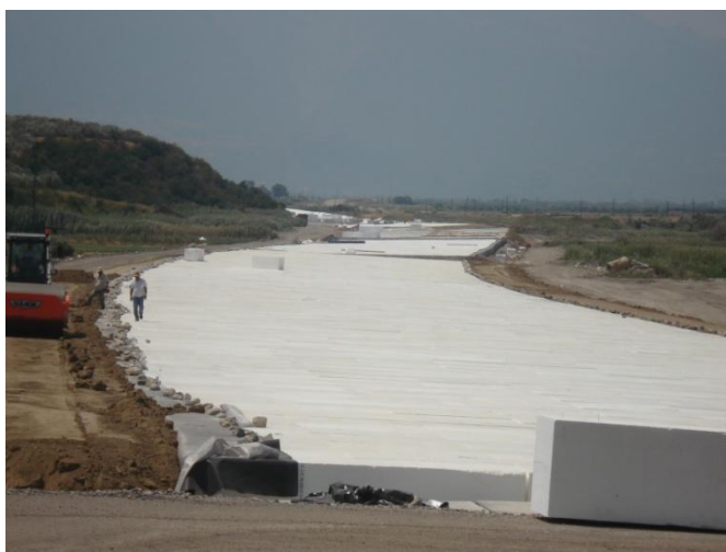
Σχήμα 2.6 Εγκιβωτισμός «επίχωματος» EPS με λωρίδες συμπιεσμένου εδάφους
