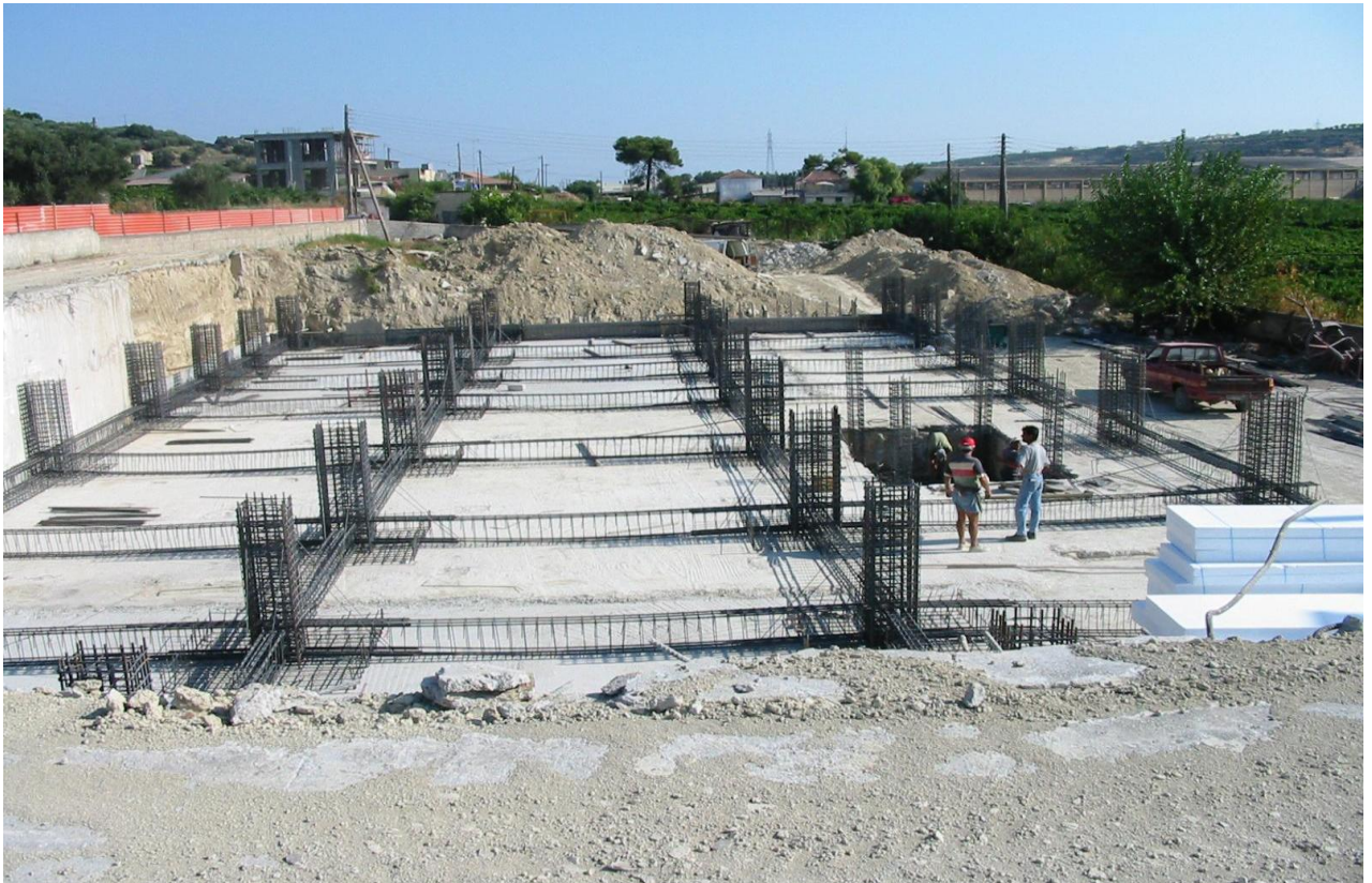
Σχήμα 3.18 Θεμελίωση με νέα μέθοδο ( με χρήση γεωαφρού) - Τοποθέτηση οπλισμών
