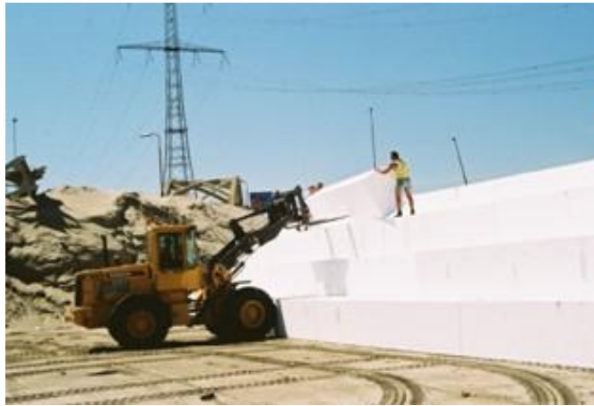
Σχήμα 2.4 Μεταφορά γεωαφρού
