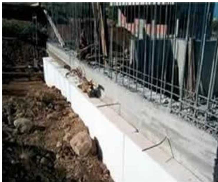
Σχήμα 4.1 Θεμελίωση με EPS
