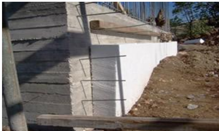
Σχήμα 4.2 Τοποθέτηση γεωαφρού σε τοίχείο υπογείου
