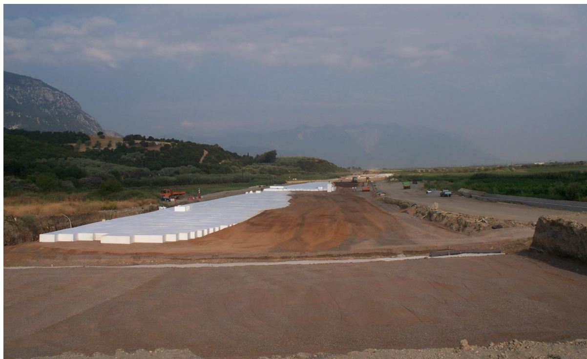
Σχήμα 5.10 Στρώσεις στράγγισης
