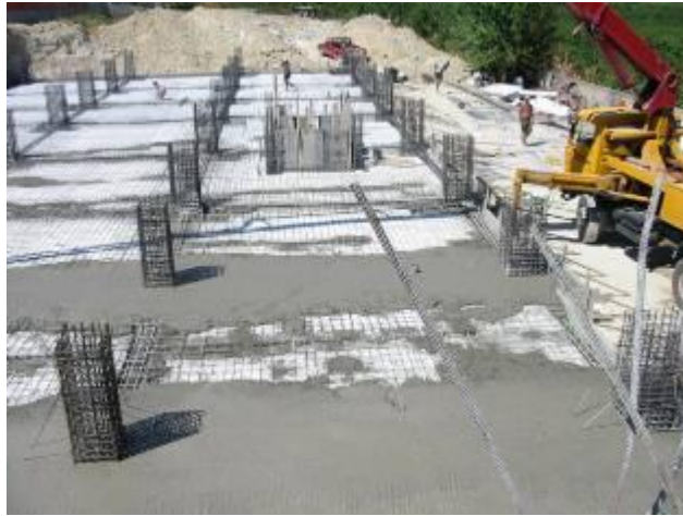
Σχήμα 3.7 Σκυροδέτηση δαπέδου πάνω από EPS
