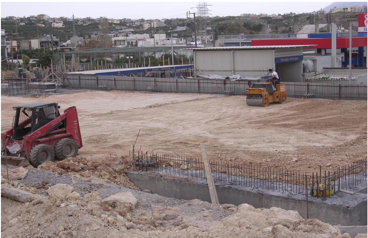
Σχήμα 3.17 Συμπύεση επιχωμάτων
