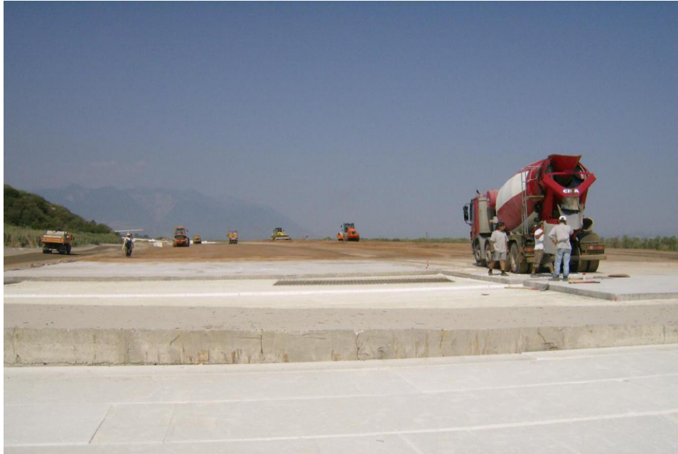
Σχήμα 5.16 Στρώση στράγγισης
