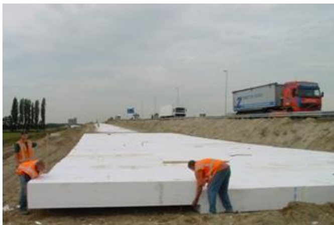
Σχήμα 2.2 Τοποθέτηση πρισμάτων EPS
