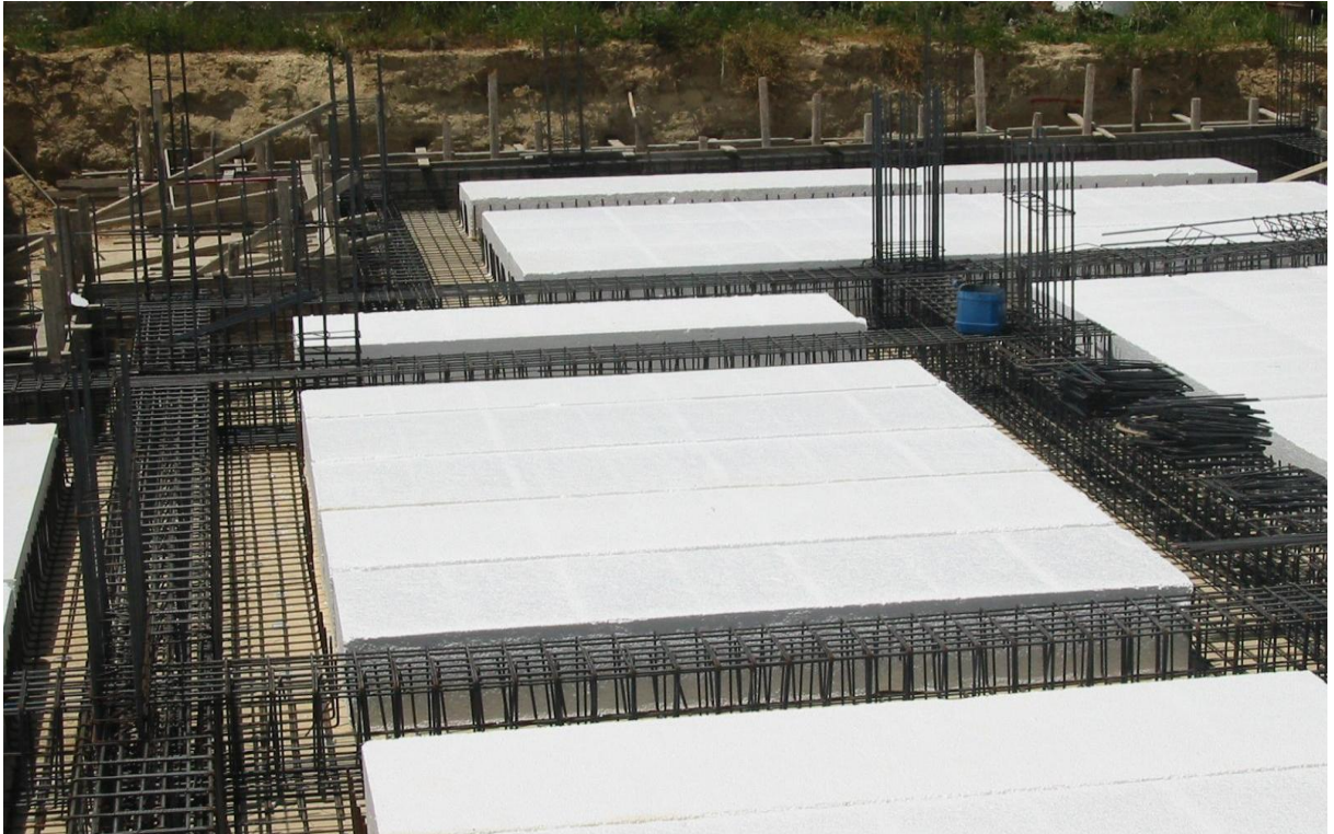
Σχήμα 3.21 Θεμελίωση με νέα μέθοδο τοποθέτηση οπλισμού πλάκας
