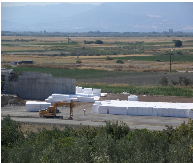
Σχήμα 2.5 Στρώσεις πρισμάτων EPS σε υπό κατασκευή «επίχωμα»
