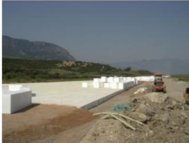
Σχήμα 2.1 Κατασκευή «επιχώματος» με πρίσματα γεωαφρού
