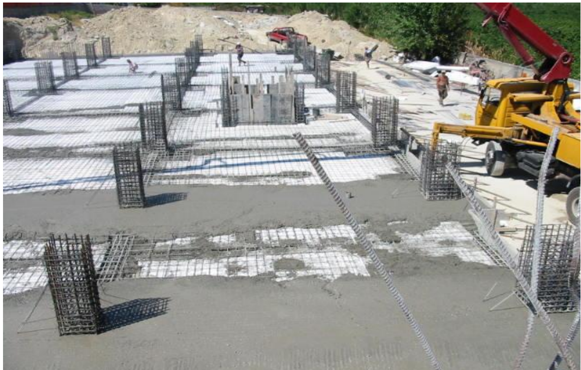
Σχήμα 3.22 Σκυροδέτηση κουστύμι
