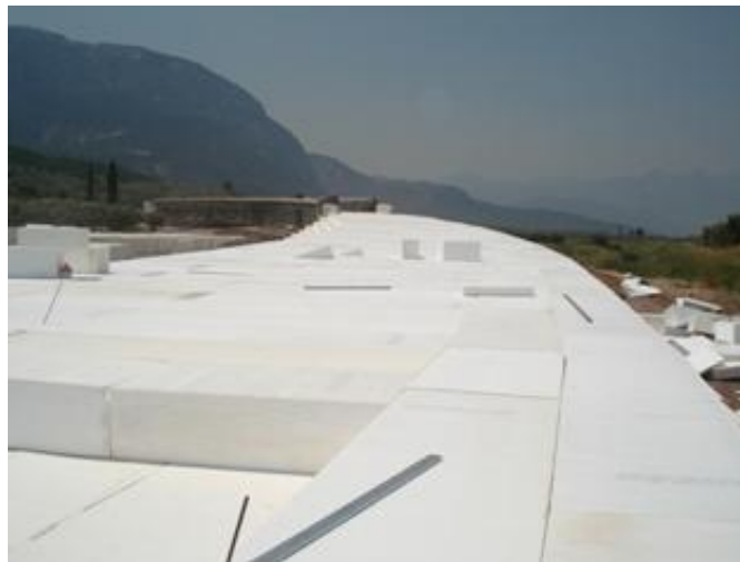
Σχήμα 2.3 Κατασκευή διπλής στρώσης πρισμάτων EPS σε «επίχωμα»
