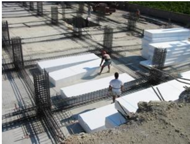
Σχήμα 3.3 Τοποθέτηση πλακών EPS σε γενική κοιτόστρωση
