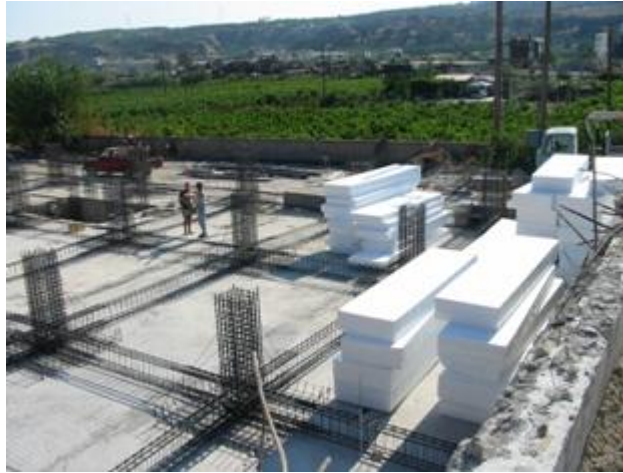
Σχήμα 3.2 Θεμελίωση τύπου γενικής κοιτόστρωσης
