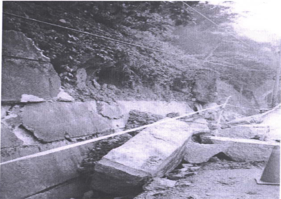
Σχήμα 4.4 Αστοχία τοίχου βαρύτητας (ολίσθηση μεταξύ κατασκευαστικών αρμών) κατά το σεισμό Chi-Chi της Ταϊβάν (1999) (Fang et al. 2003)
