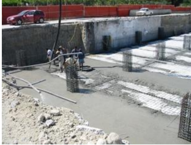
Σχήμα 3.6 Σκυροδέτηση δαπέδου πάνω από EPS
