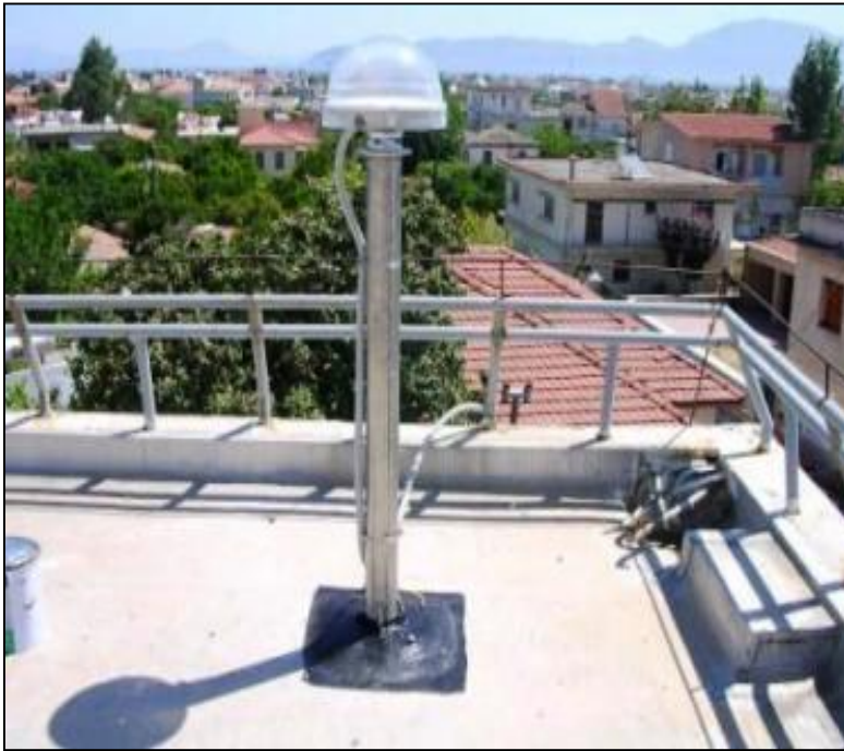
Εικόνα 3.3: Στήριξη ΣΑ σε οροφή
