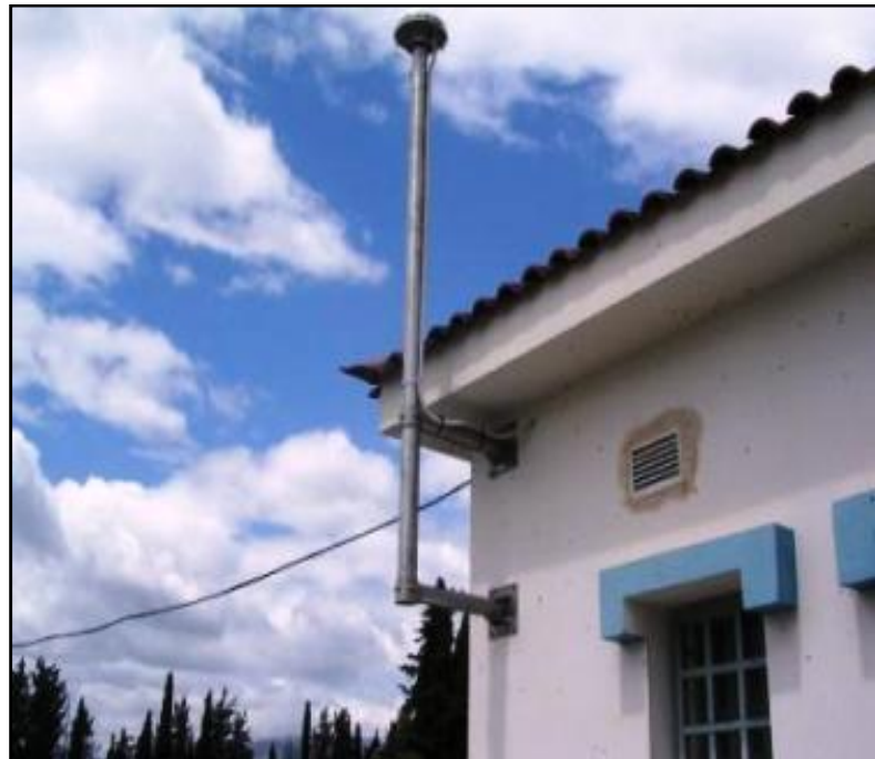
Εικόνα 3.4: Στήριξη ΣΑ σε τοίχο
