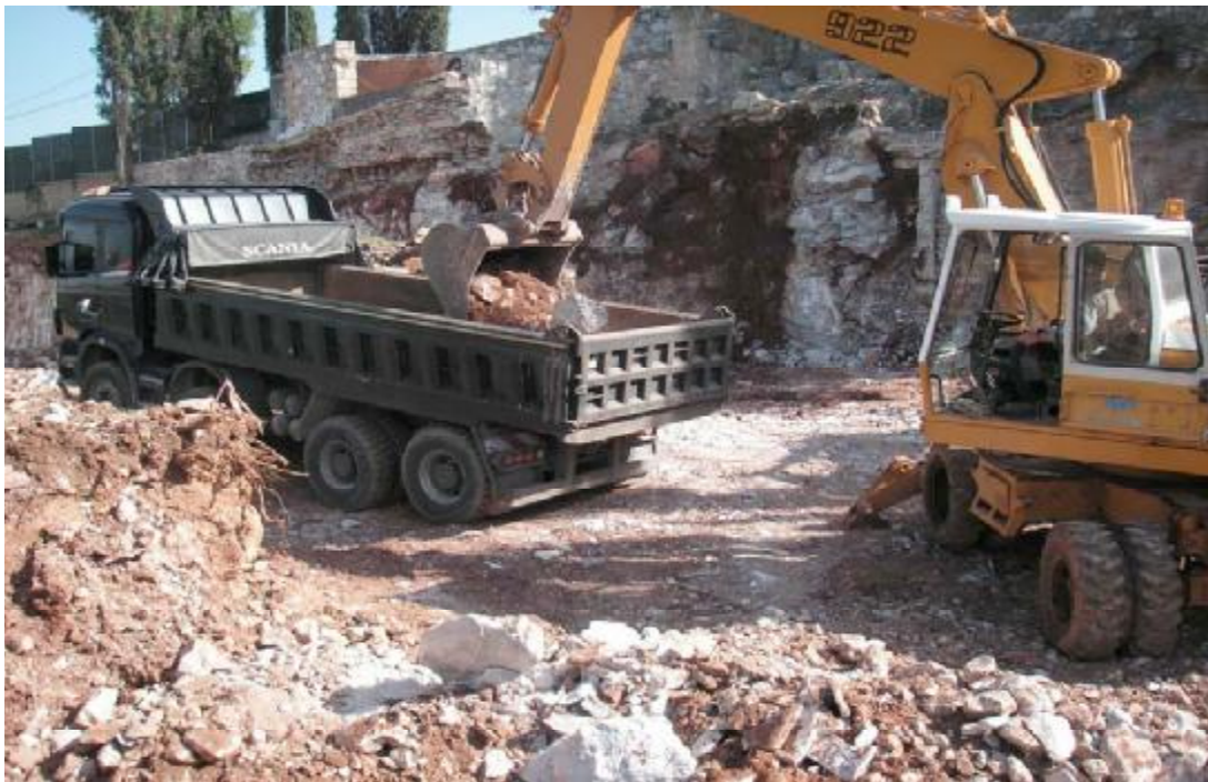
Φόρτωση Προϊόντων Εκσκαφής
