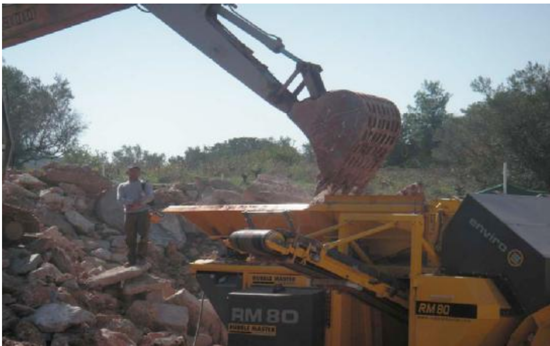
Τροφοδότηση Σπαστήρα με Τσάπα
