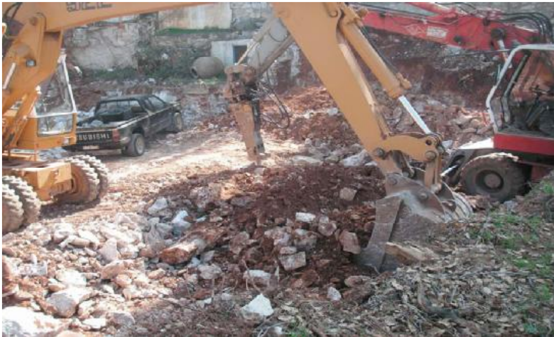
Εκσκαφή Υλικού με Τσάπα και Σφυρί
