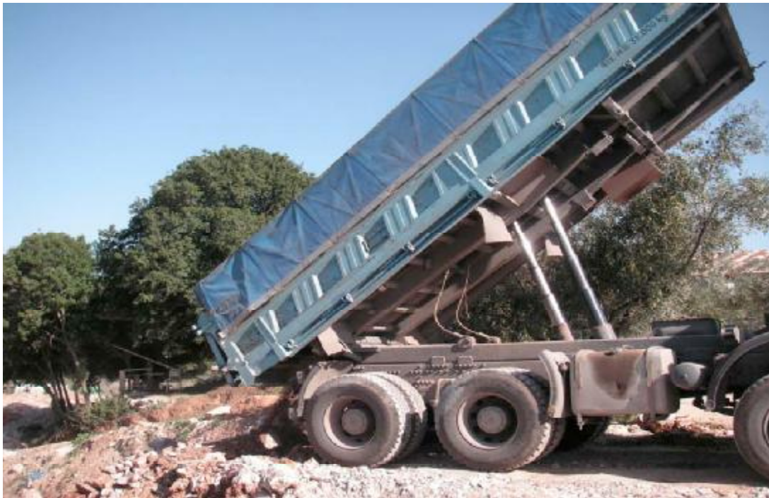
Άδειασμα Υλικού στο Λατομείο 2
