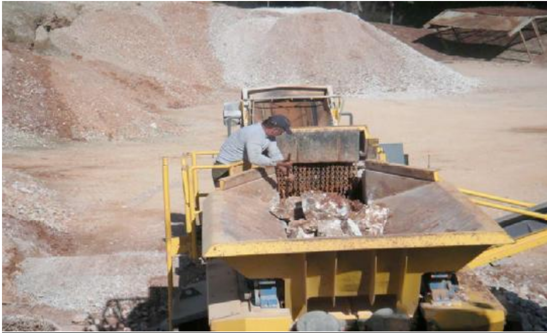
Πρόβλημα στο ρότορα 1 (overload)
