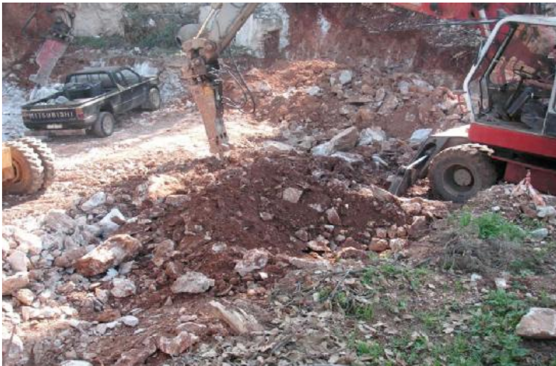
Εκσκαφή Υλικού με Σφυρί
