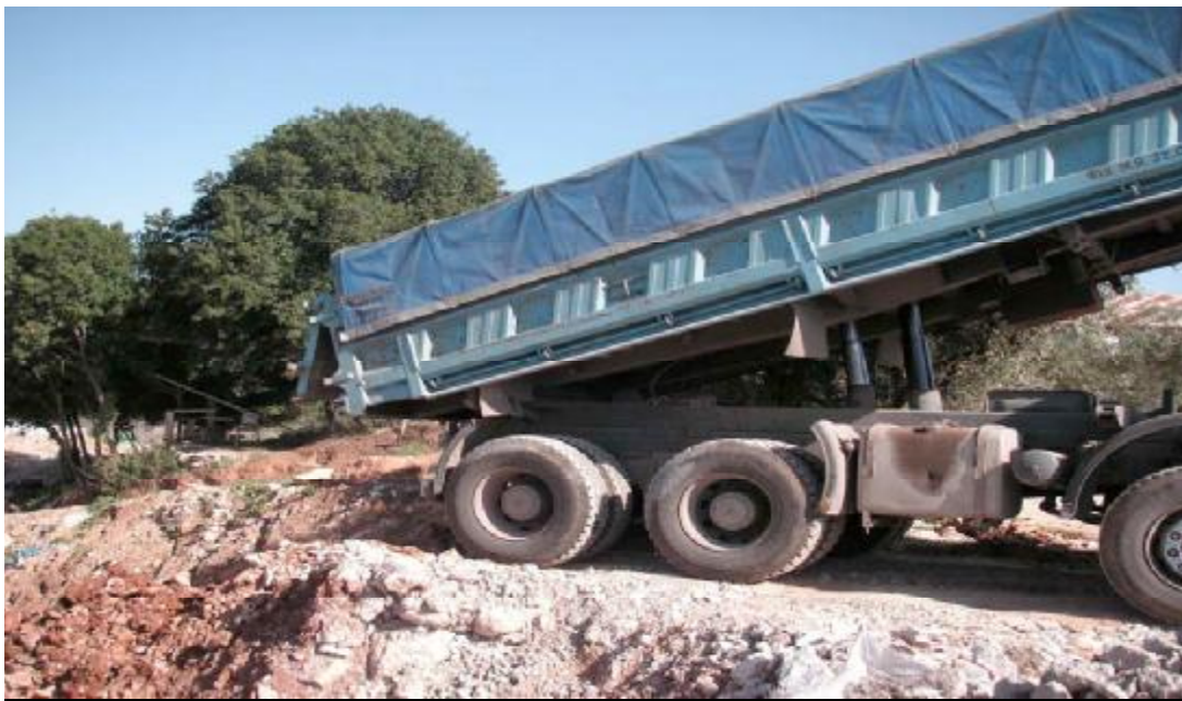
Άδειασμα Υλικού στο Λατομείο 1
