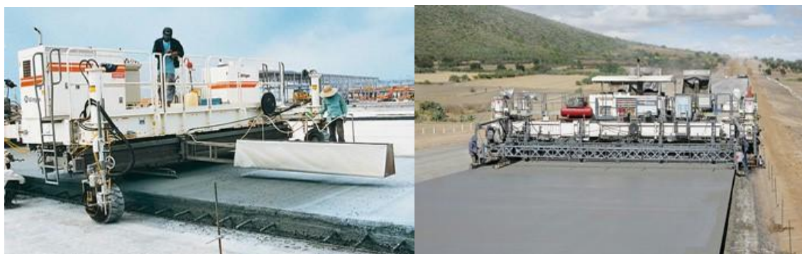
Εικ:12 Επίστρωση οδοστρώματος από σκυρόδεμα
