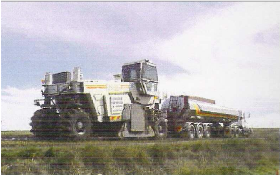
Εικ13:Επιτόπου σταθεροποίηση με αφρώδη άσφαλτο χρησιμοποιώντας Wirtgen WR2500
