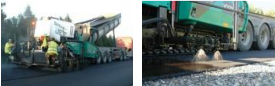
Εικ.8 : Εφαρμογή της εν θερμώ ανακύκλωσης
