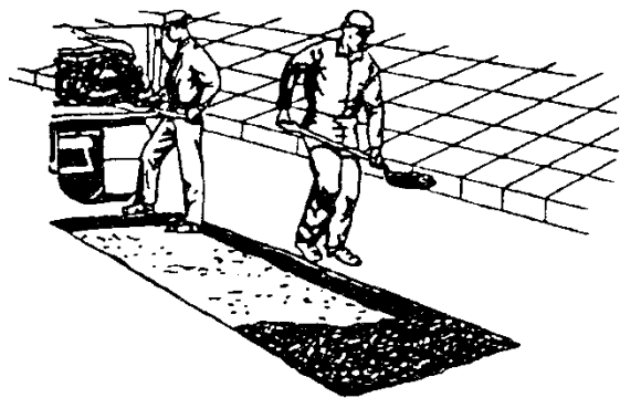
Σχ.5) Πλήρωση σκάμματος
