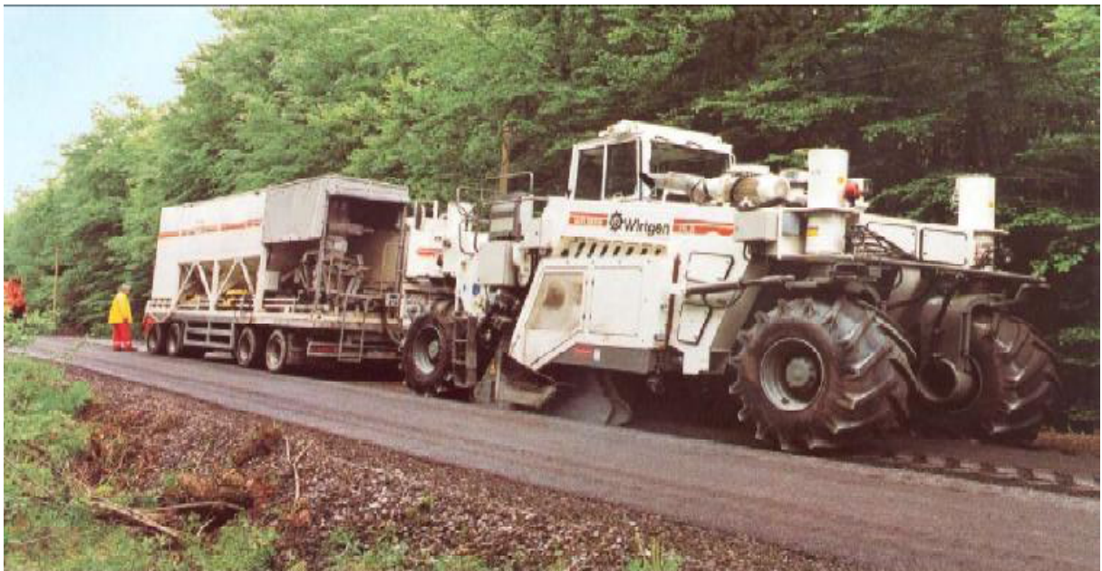
Εικ. : 9 Διαδικασία φραζαρίσματος, ανάμιξης, διάστρωσης με τσιμέντο σε μορφή αιωρήματος
