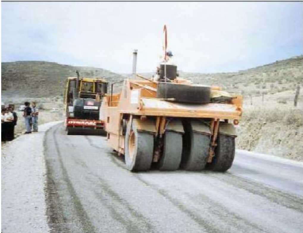
Εικ:10 Συμπύκνωση ανακυκλωμένης στρώσης
