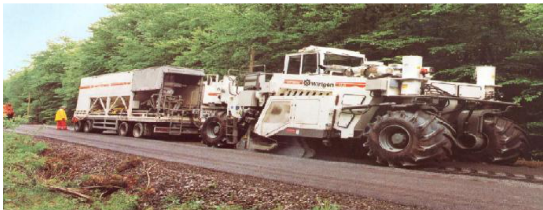
Εικ. 17: Διαδικασία φρεζαρίσματος, ανάμιξης, διάστρωσης με τσιμέντο σε μορφή αιωρήματος.
