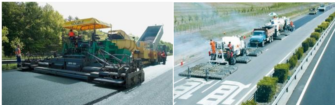
Εικ:11 Επίστρωση ασφαλτικού οδοστρώματος
