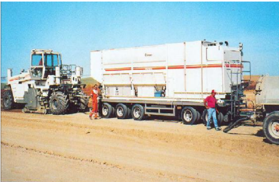
Εικ:19 Τροφοδοσία νερού και τσιμέντου
