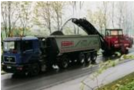
Εικ.6 : Διαδικασία περισυλλογής υλικών απόξεσης
