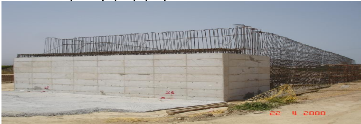
εικόνα 56 συνέχιση εργασιών ακροβάθρου
