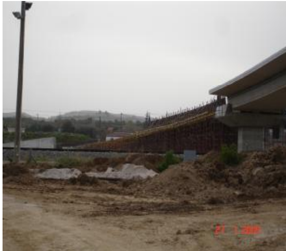
εικόνα 79 και 80 συνέχιση ένωσης καταστρώματος από βάθρο σε βάθρο
