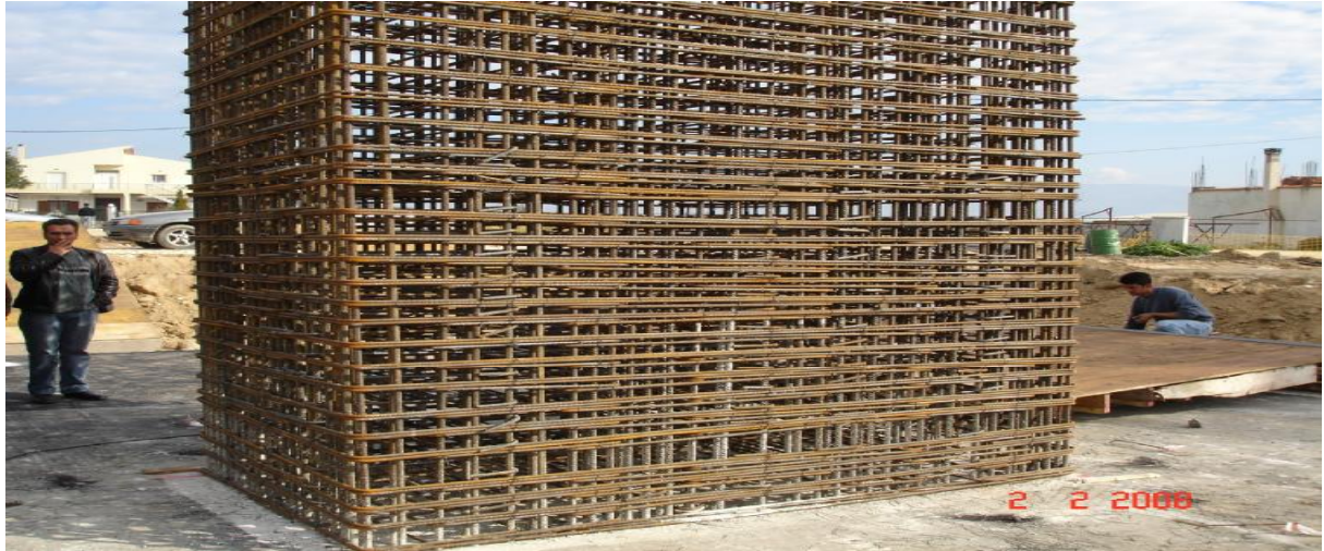
εικόνα 46 συνέχιση οπλισμού υποστυλώματος βάθρου
