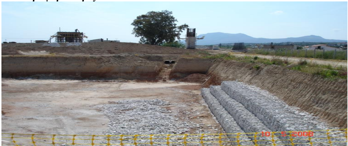
εικόνα 87 συνέχιση εργασιών για κατασκευή δεξαμενής εμπλουτισμού του υδροφόρου ορίζοντα
