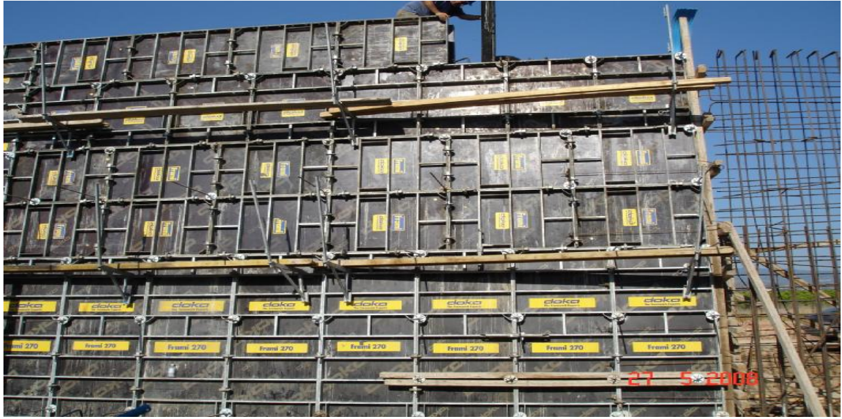
εικόνα 58 καλούπωμα τοιγίων ακροβάθρου
