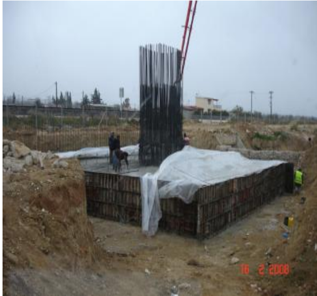
εικόνα 42 και 43 προστασία σκυροδέτησης και ξεκαλούπωμα βάρου
