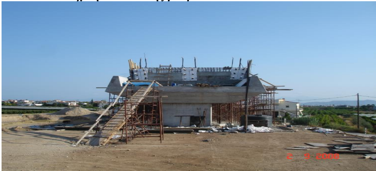
εικόνα 68 συνέχιση κατασκευή βάθρων M3 και M6
