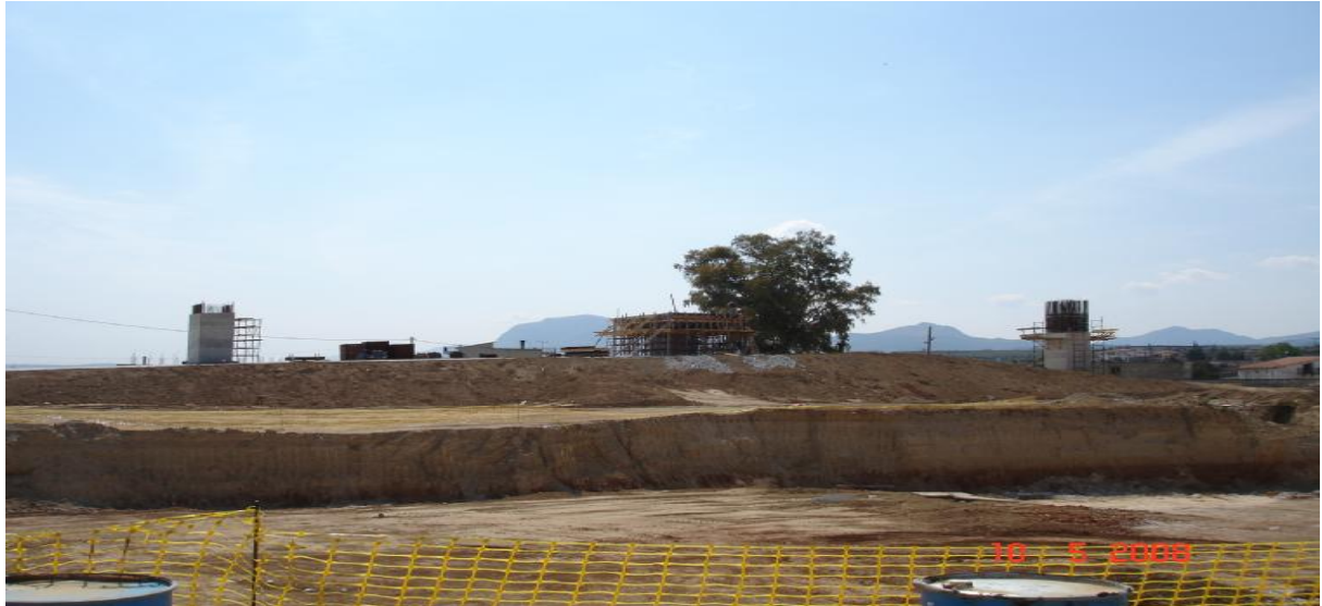
εικόνα 85 χωματουργικές εργασίες για κατασκευή δεξαμενής εμπλουτισμού του υδροφόρου ορίζοντα
