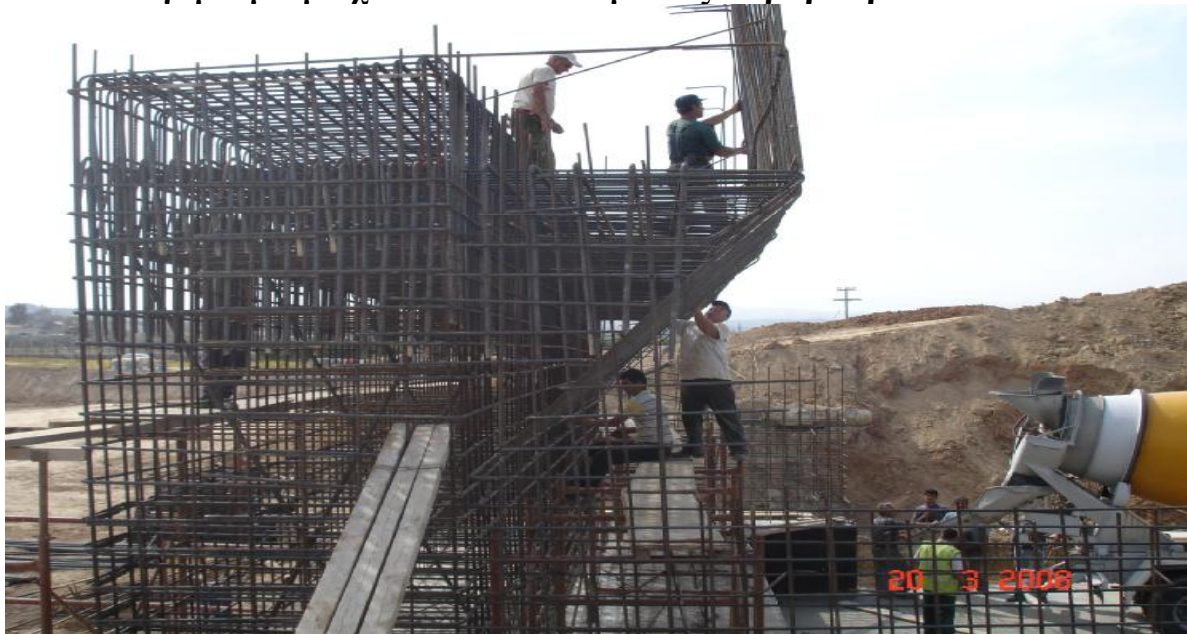
εικόνα 53 οπλισμός ακροβάθρου
