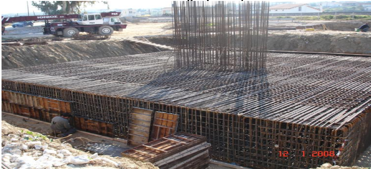
εικόνα 40 καλούπωμα βάρου
