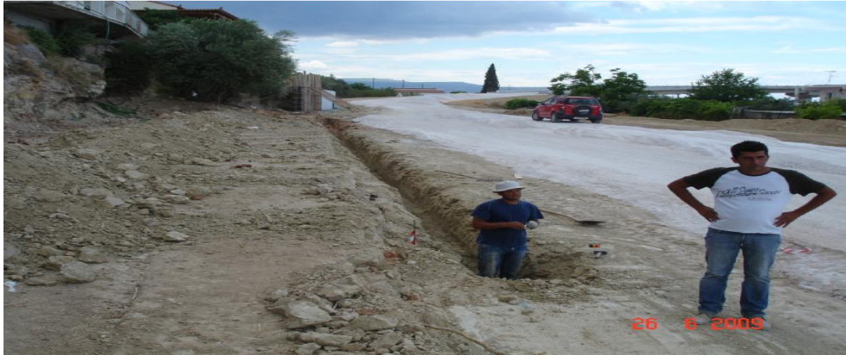
εικόνα 82 διάνοιξη για τοποθέτηση αγωγών αποστράγγισης
