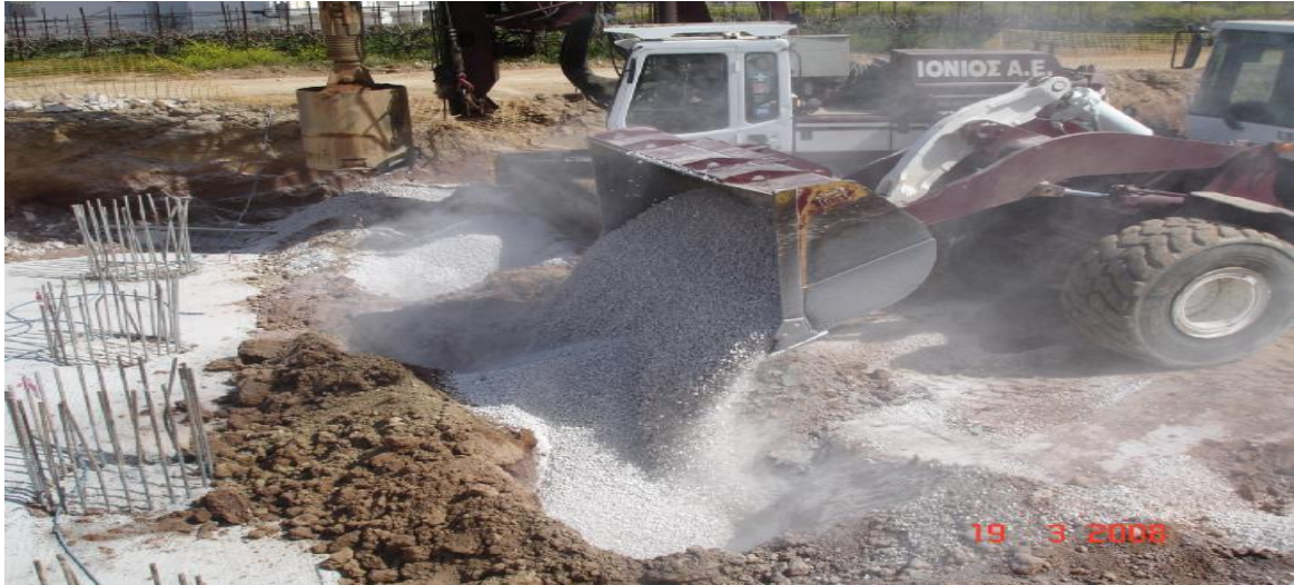
εικόνα 52 γέμισμα με χαλίκι πασσαλομάδας ακροβάθρου
