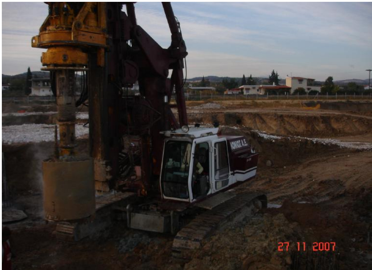
εικόνα 25 φωτογραφία από το Γεωτρύπανο
