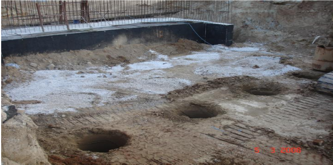
εικόνα 49 διάνοιξη για πασσάλους ακροβάθρου
