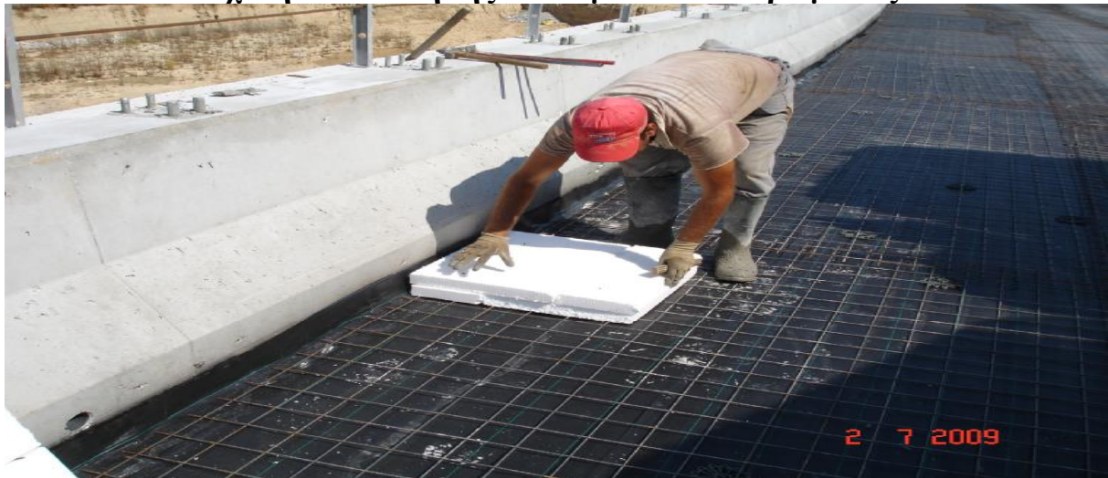
εικόνα 77 συνέχιση τοποθέτησης οπλισμού καταστρώματος
