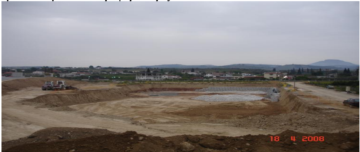
εικόνα 86 συνέχιση εργασιών για κατασκευή δεξαμενής εμπλουτισμού του υδροφόρου ορίζοντα
