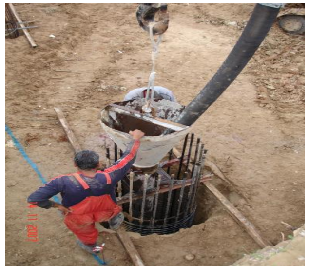
εικόνα30 άνοιγμα για πάσσαλο
