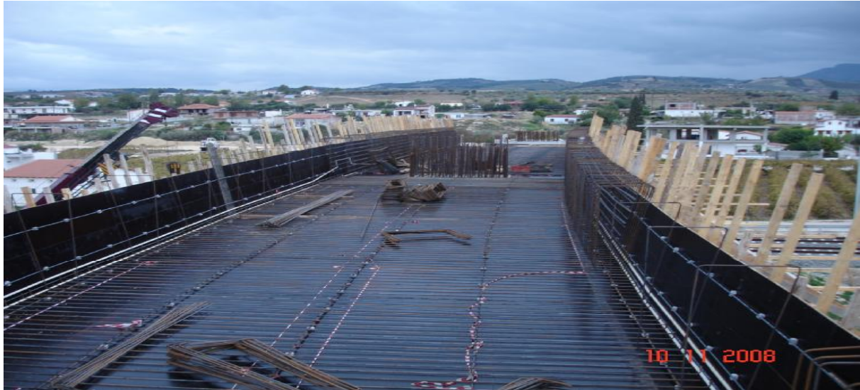
εικόνα 76 συνέχιση τοποθέτησης οπλισμού καταστρώματος
