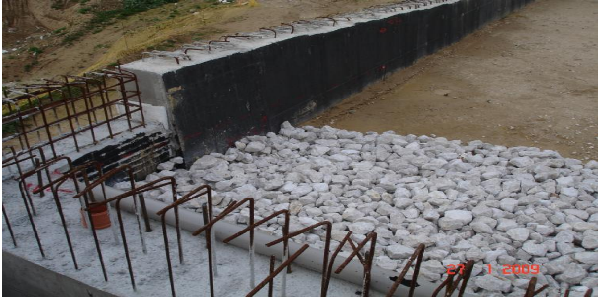
εικόνα 61 γέμισμα με κροκάλες ακροβάθρου
