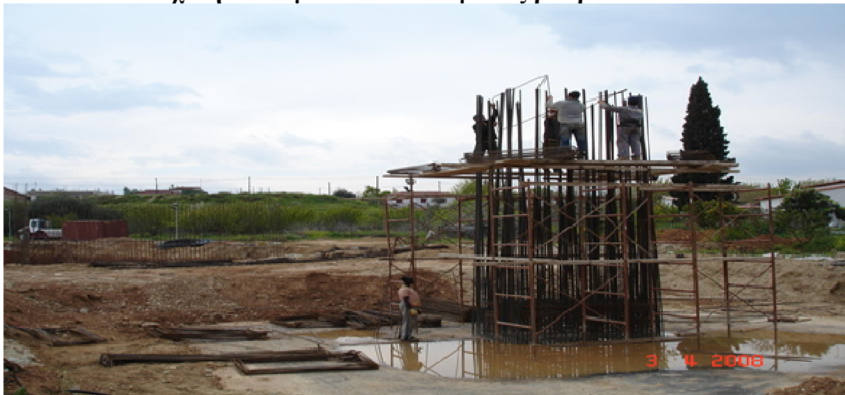
εικόνα 47 συνέχιση οπλισμού υποστυλώματος βάθρου
