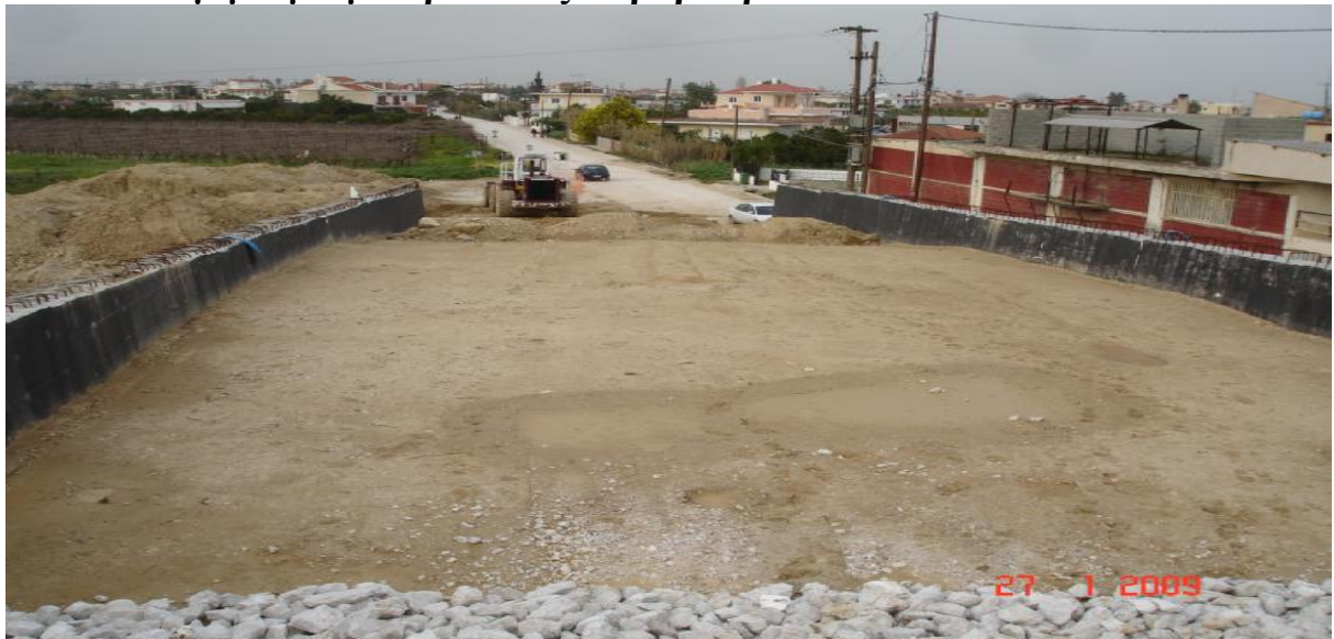
εικόνα 62 γέμισμα με κροκάλες και εδάφικο υλικό ακροβάθρου
