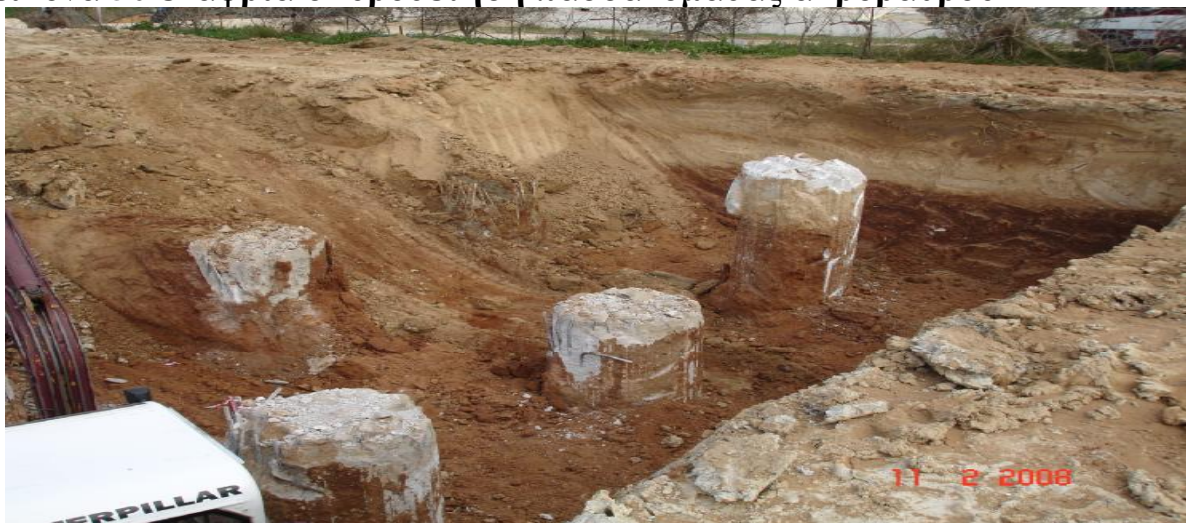
εικόνα 51 καθαρισμός ακροβάθρου
