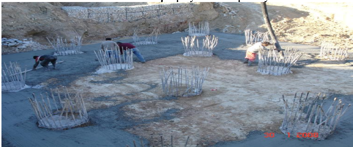
εικόνα 35 τοποθέτηση τσιμεντοκονιάματος στη πασσαλομάδα
