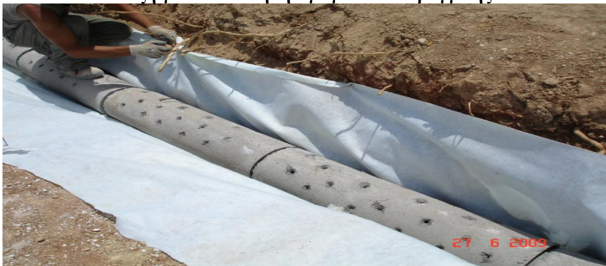
εικόνα 83 τοποθέτηση γεωφάσματος και αγωγών
