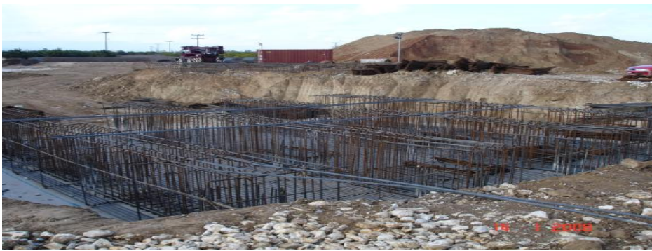
εικόνα 37 τοποθέτηση οπλισμού για τη δημιουργία βάρου
