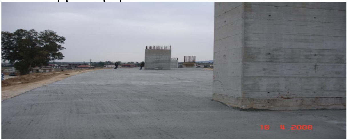
εικόνα 65 όψη βάθρων και υποστηλωμάτων
