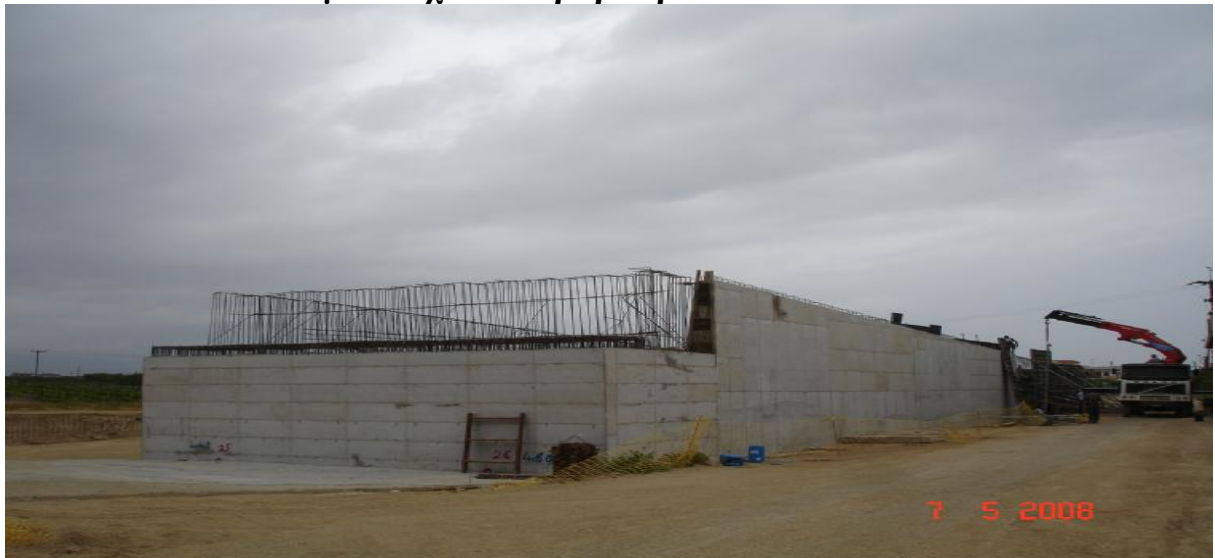
εικόνα 59 σκυροδέτηση τοιγίου ακροβάθρου
