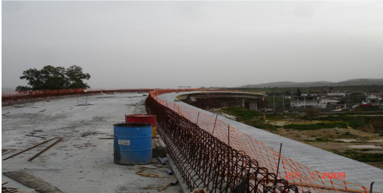
εικόνα 79 όψη καταστρώματος μετά τη σκυροδέτηση
