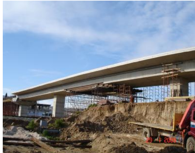
εικόνα 79 όψη καταστρώματος μετά τη σκυροδέτηση
