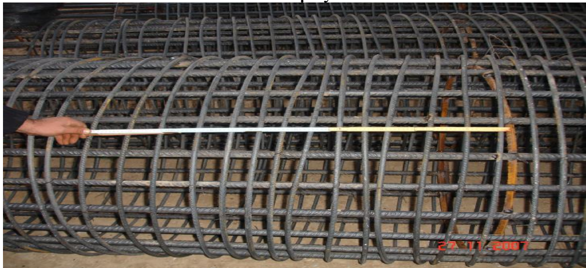
εικόνα 27 οπλισμός πασσάλων
