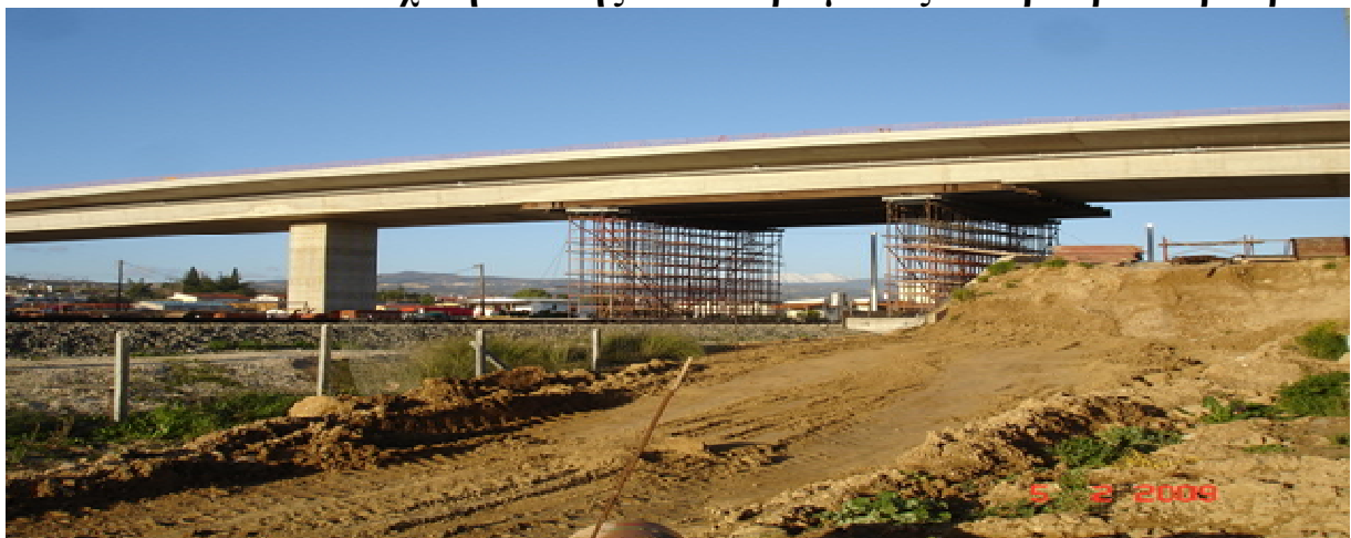
εικόνα 81 όψη γέφυρας μετά τη φάση της σκυροδέτησης
