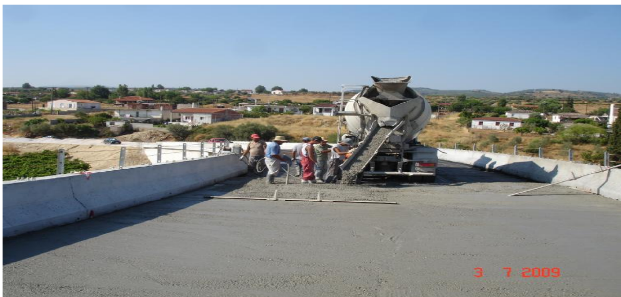
εικόνα 78 διαδικασία σκυροδέτησης καταστρώματος
