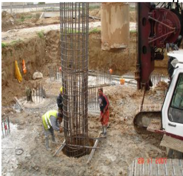
εικόνα 30 και 31 τοποθέτηση οπλισμού του πασσάλου και γέμισμα αυτού
