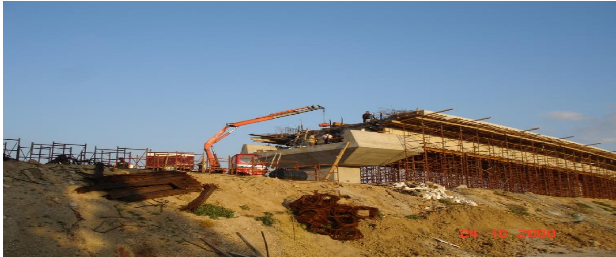
εικόνα 70 συνέχιση ένωσης των βάθρων
