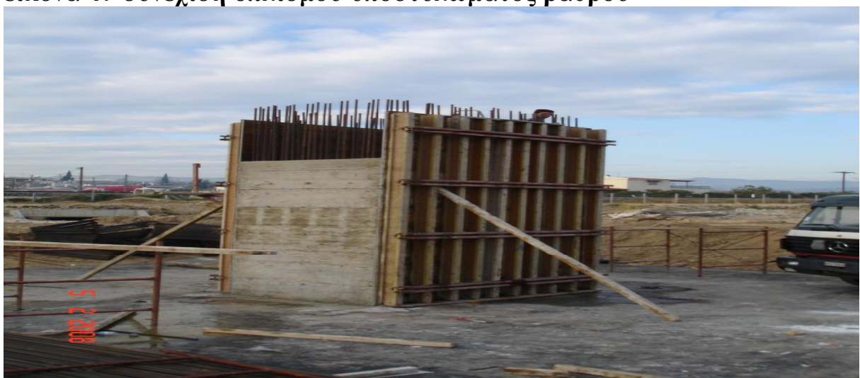
εικόνα 48 καλούπωμα υποστυλώματος
