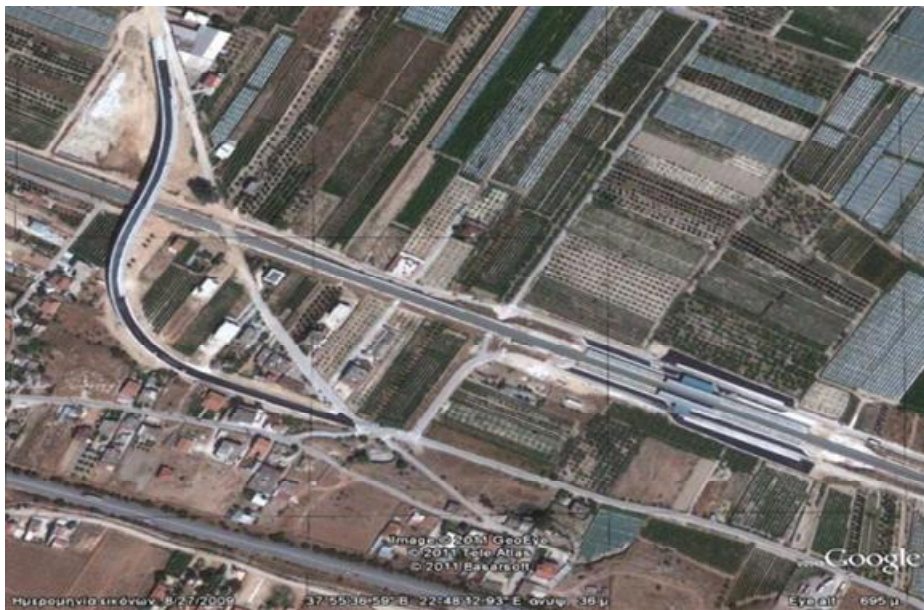
Εικόνα 11 αεροφωτογραφία που δείχνει την γέφυρα με τον σταθμό του προαστιακού Google earth
