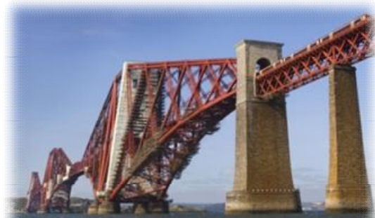
Εικόνα 4 Forth rail bridge
