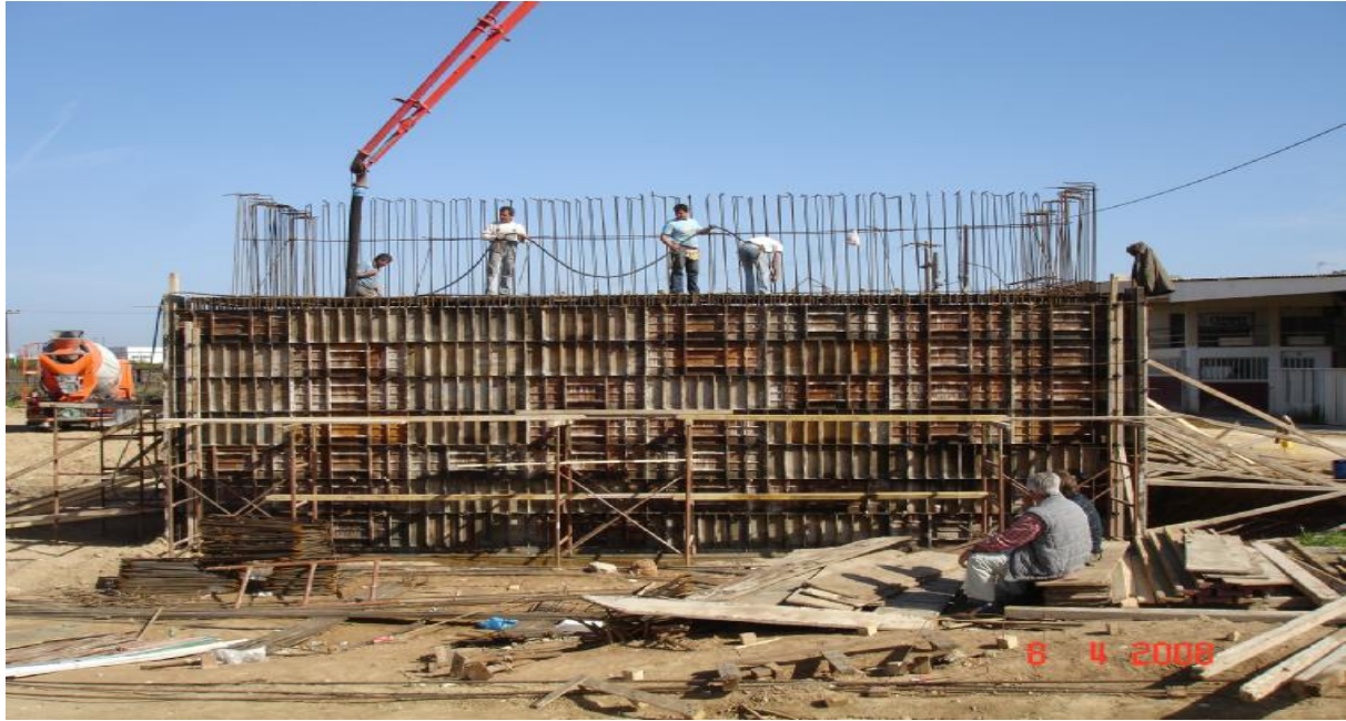
εικόνα 55 σκυροδέτηση ακροβάθρου
