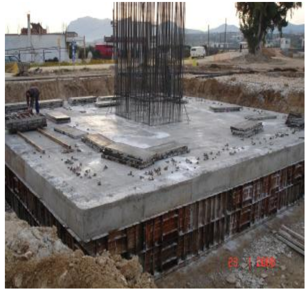
εικόνα 42 και 43 προστασία σκυροδέτησης και ξεκαλούπωμα βάρου
