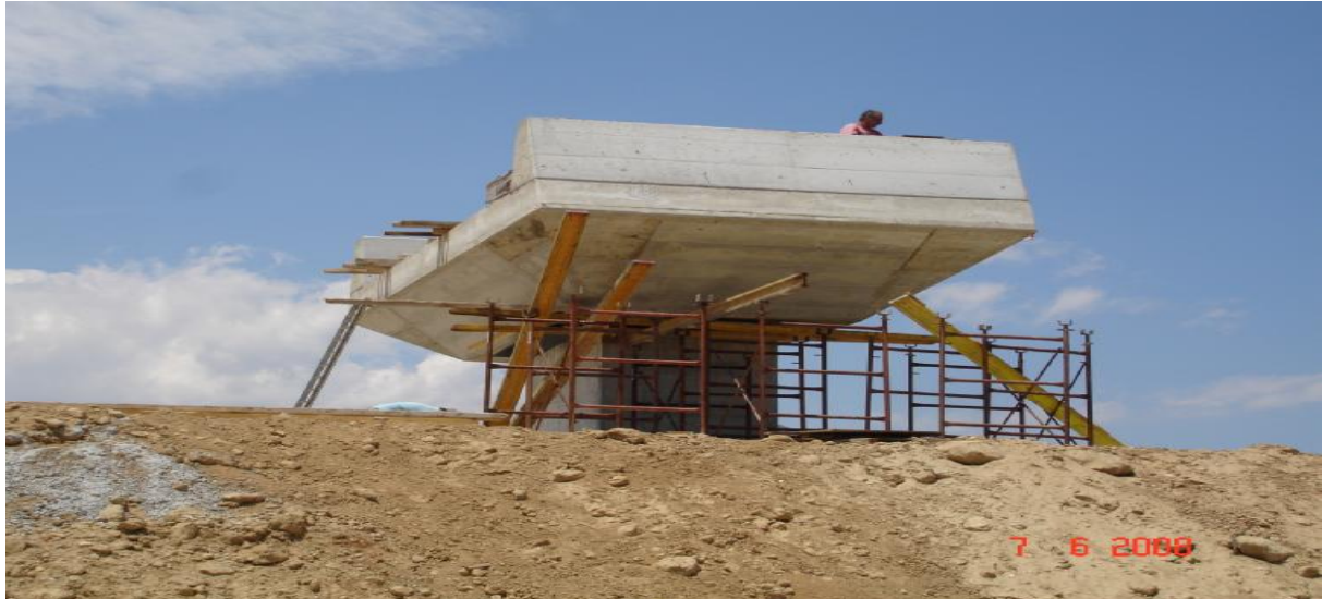
εικόνα 67 συνέχιση κατασκευής βάθρων M3 και M6
