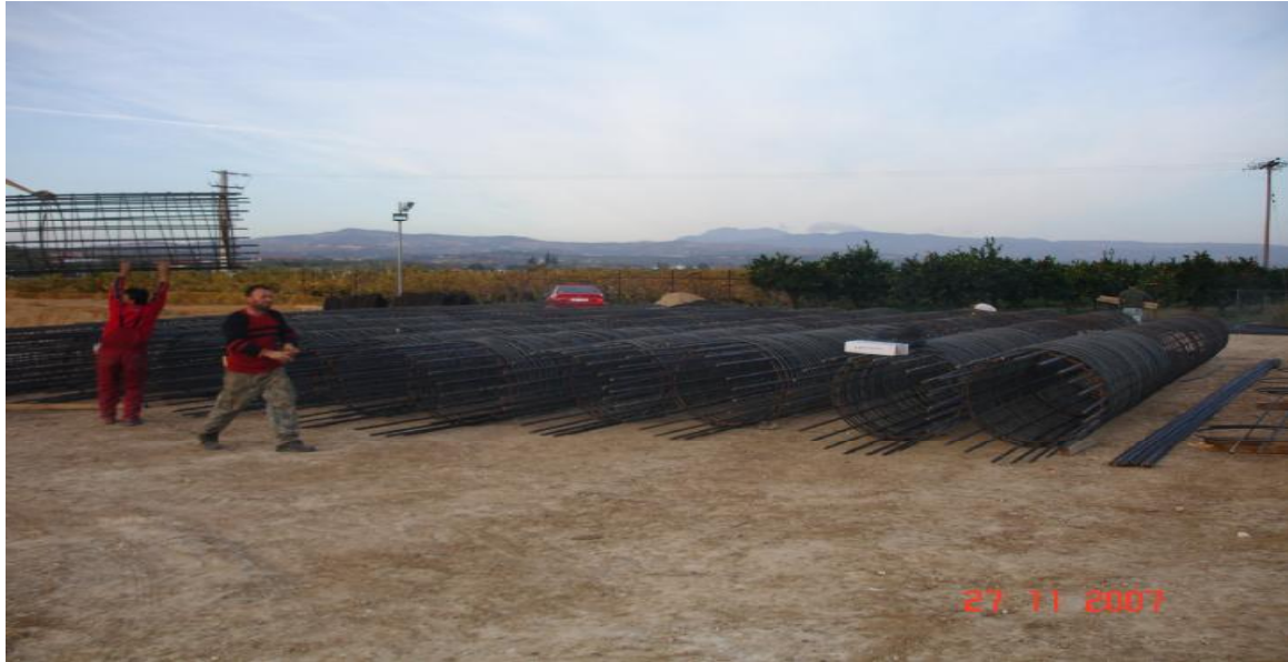
εικόνα 26 οπλισμός πασσάλων
