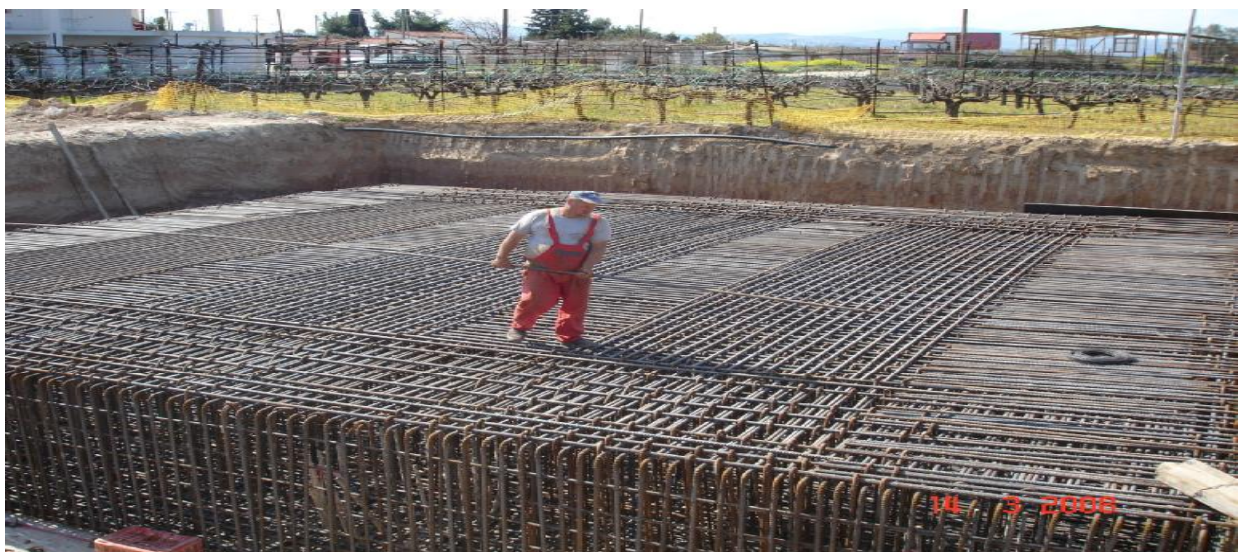
εικόνα 38 οπλισμός βάρου
