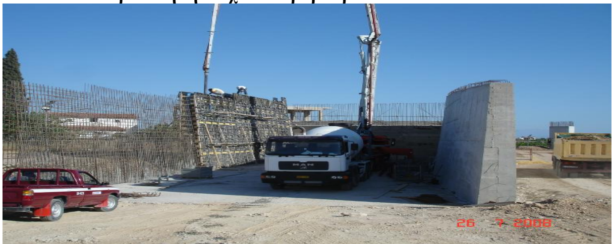
εικόνα 60 σκυροδέτηση τοιγίου ακροβάθρου
