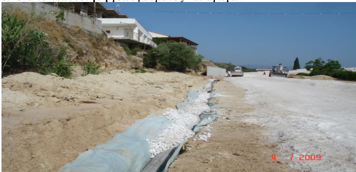
εικόνα 84 ρήξη κροκάλων στους αγωγούς
