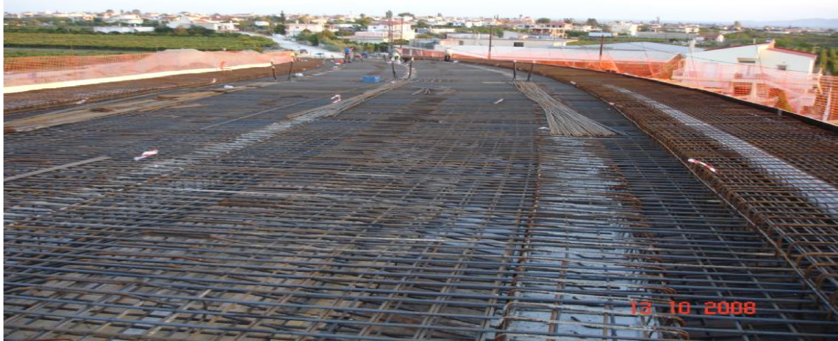
εικόνα 73 τοποθέτηση οπλισμού καταστρώματος
