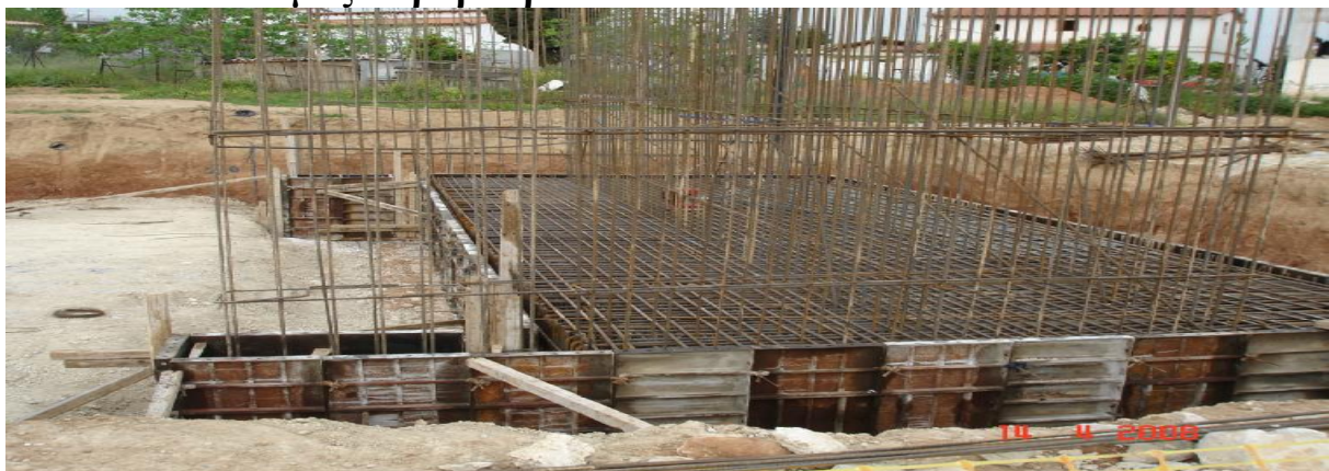
εικόνα 53 οπλισμός ακροβάθρου
