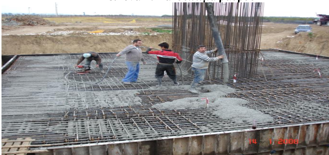
εικόνα 41 σκυροδέτηση βάρου
