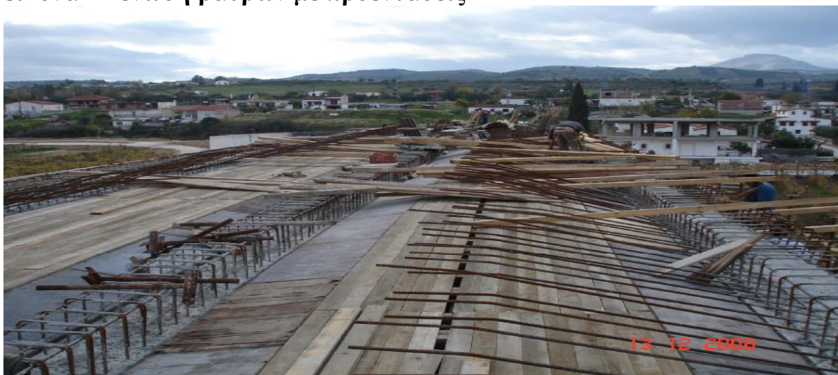
εικόνα 71 ένωση βάθρων με προεντάσεις
