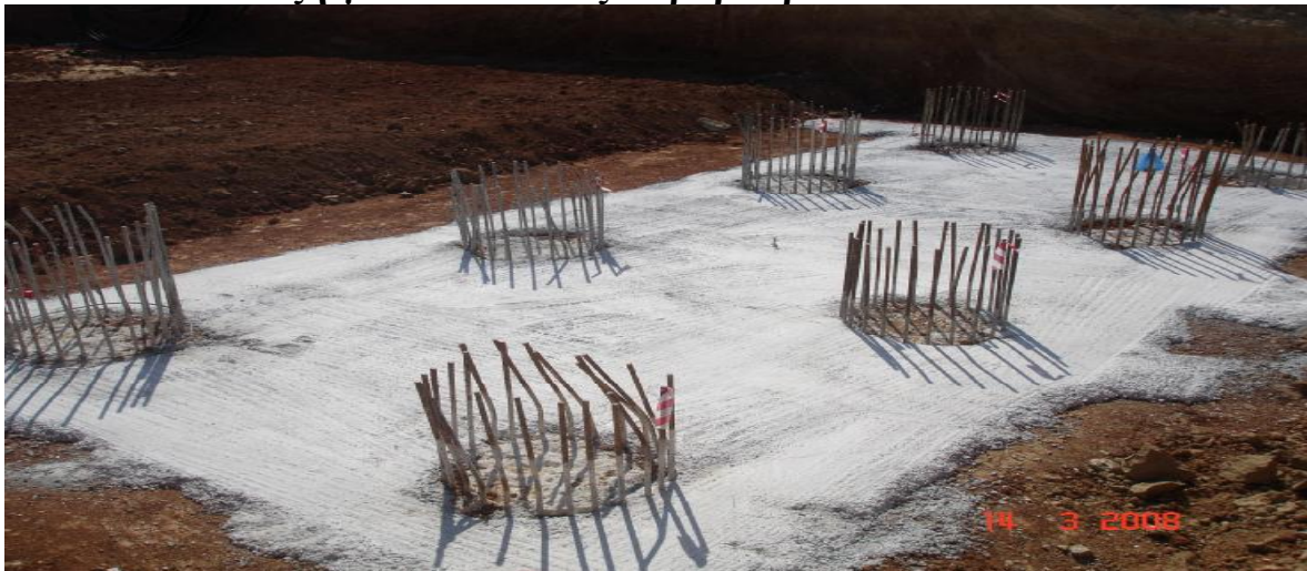
εικόνα 50 ελαφριά σκυροδέτηση πασσαλομάδας ακροβάθρου
