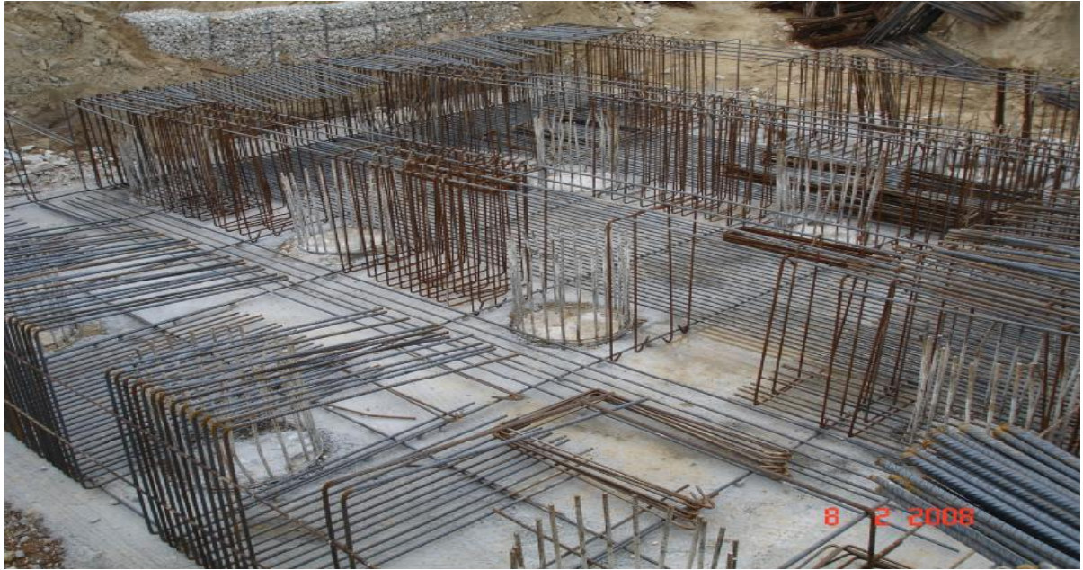
εικόνα 36 τοποθέτηση οπλισμού για δημιουργία του βάρου
