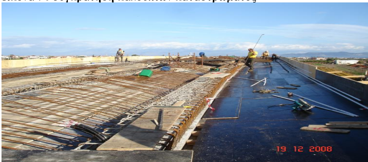
εικόνα 75 συνέχιση καλουπώματος καταστρώματος
