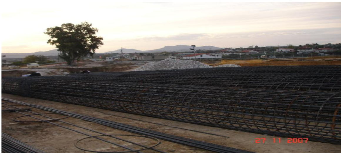
εικόνα 28 οπλισμός πασσάλων
