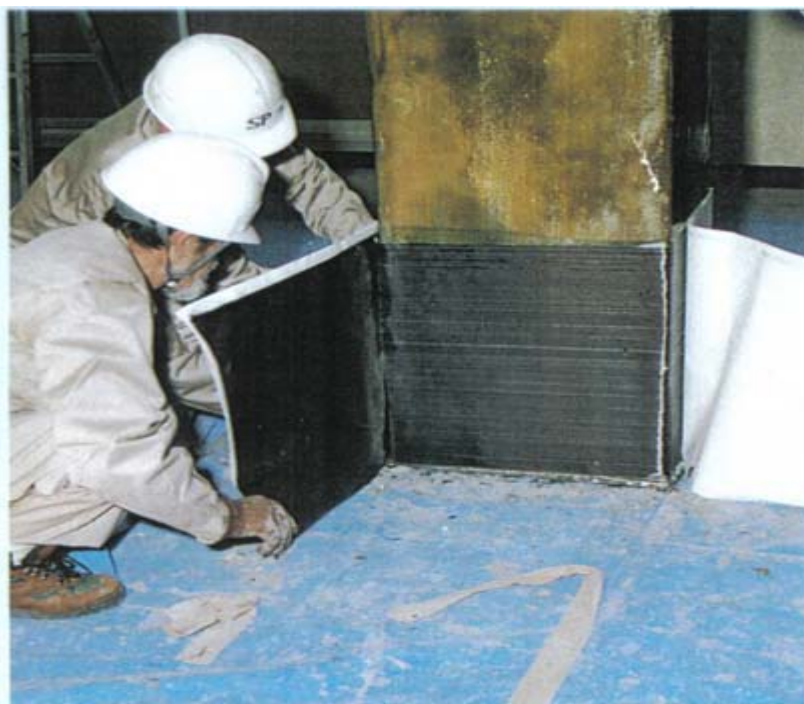
Τοποθέτηση υφασμάτων ινοπλισμένων πολυμερών σε υποστρώματα
