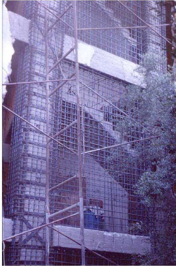
Ενίσχυση υποστυλώματος - Προσθήκη τοιχώματος (Αίγιο, 1995)
