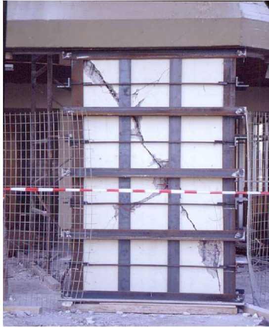
Μεταλλικός μανδύας ως τεχνική προσωρινής υποστήλωσης (Πύργος, 1993)
