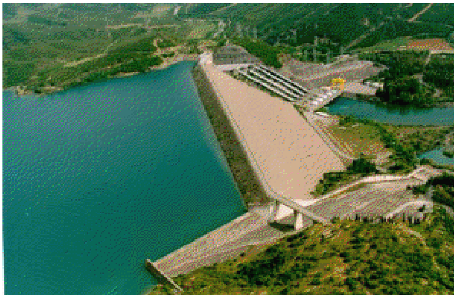
Εικόνα 3. Γενική άποψη του φορέα του φράγματος Καστρακίου (ΔΕΗ, 2010).
