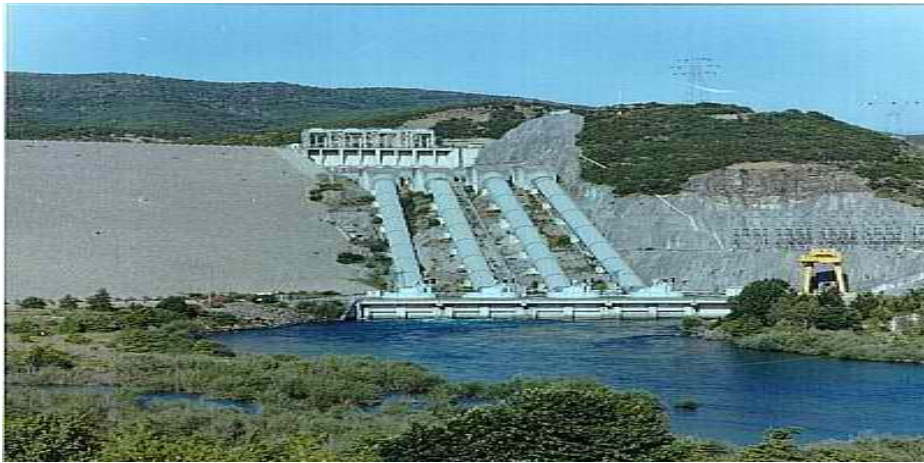
Εικόνα 4. Εκχειλιστής του υδροηλεκτρικού φράγματος Καστρακίου (ΔΕΗ, 2010)
