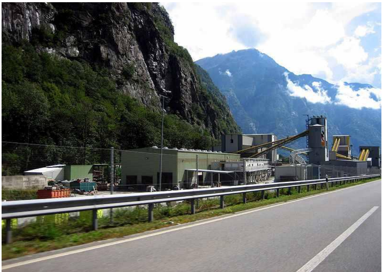
Εργοτάξιο στο Bodio
