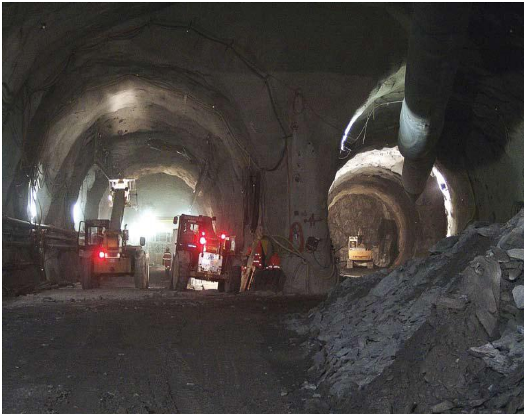
Εκσκαφή διάβασης στο Sedrun
