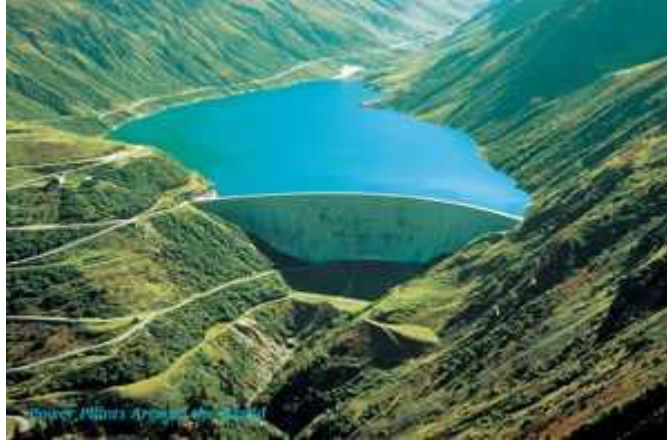
Το φράγμα 127 μέτρων στη περιοχή (Sedrun-Napls)
