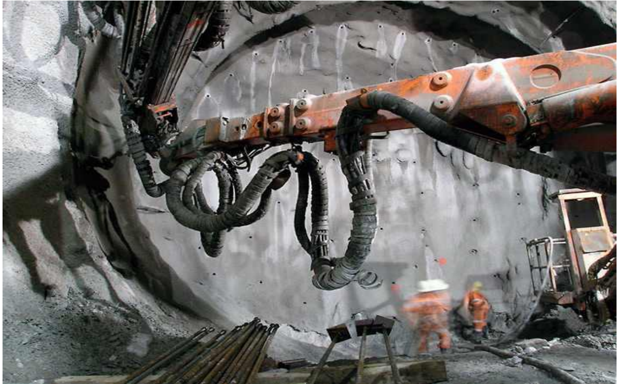
Εργασίες αγκύρωσης πετρώματος
