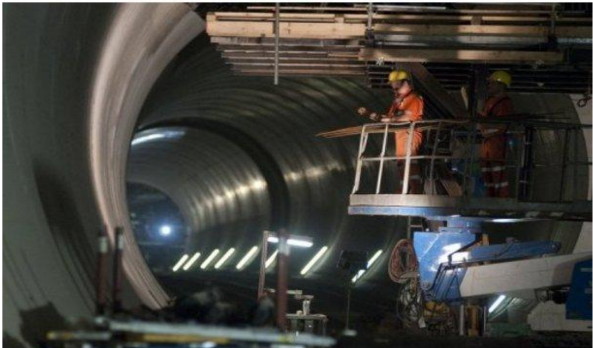
Εργασίες υποστήριξης στη σήραγγα
