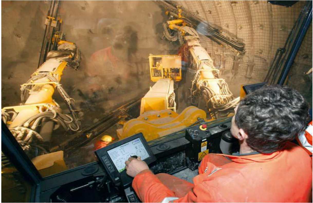
Εργασίες με drilling Jumbo στο Faido
