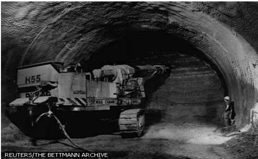
Road header κατά τη διάρκεια εργασιών
