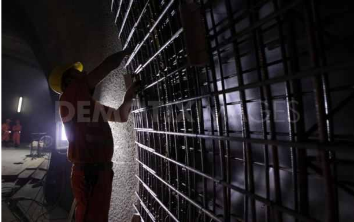
Τοποθέτηση μεταλλικών πλεγμάτων στο Bodio
