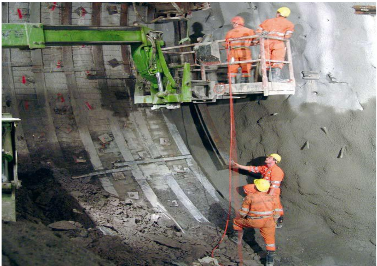
Εισαγωγή χαλύβδινων πλεγμάτων στο Faido
