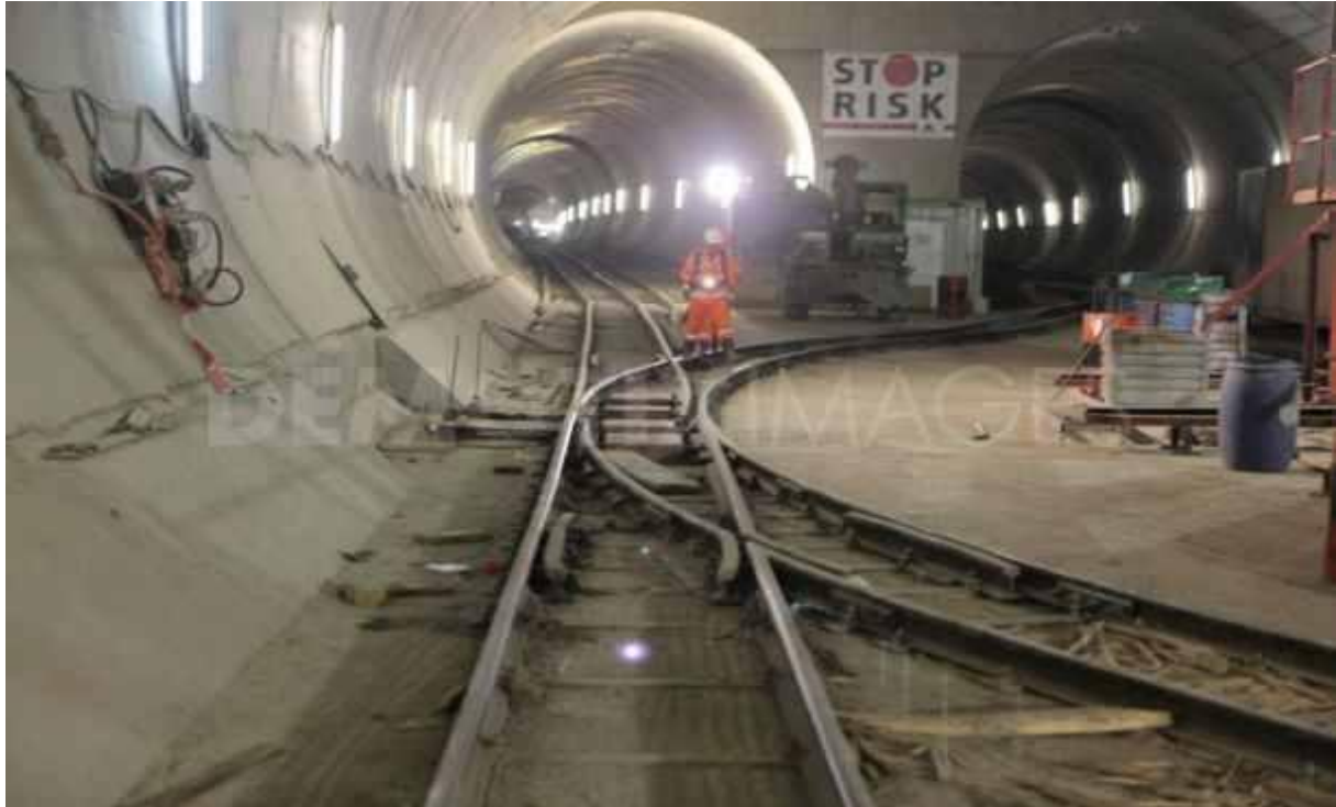
Σημείο παρεκτροπής της κατεύθυνσης των τρένων( διακρίνεται το σήμα της Stop risk-εταιρία προστασίας)
