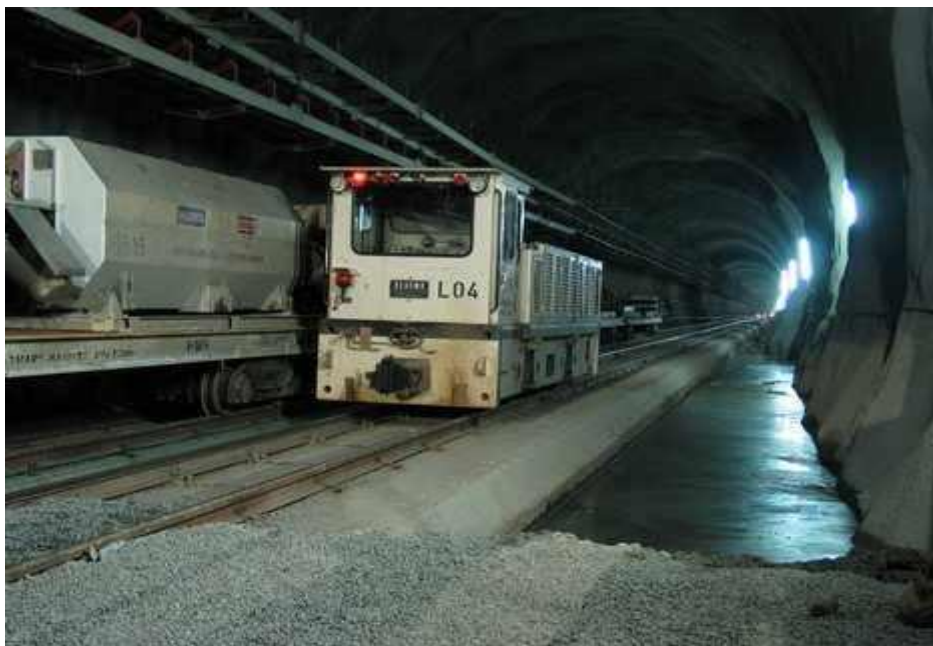
Εργασίες στο Sedrun
