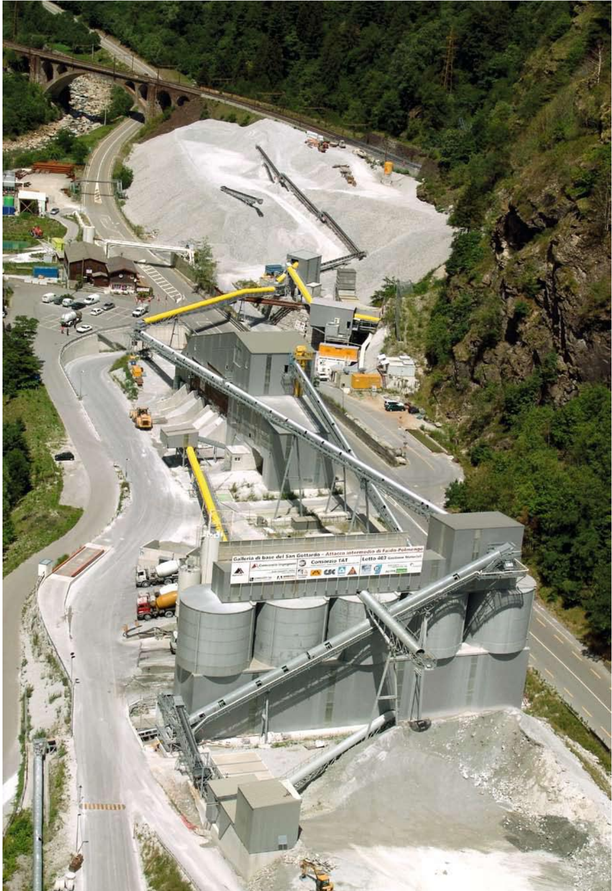
Εργοταξιακή μονάδα στο Faido
