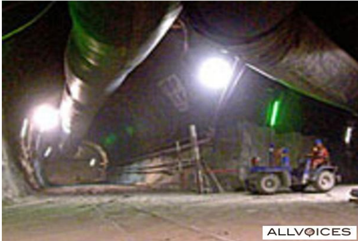
Διαμόρφωση συστήματος εξαερισμού
