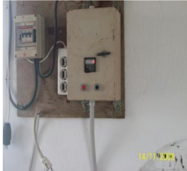
Πίνακας όπου δείχνει τον αριθμό στροφών της μηχανής
