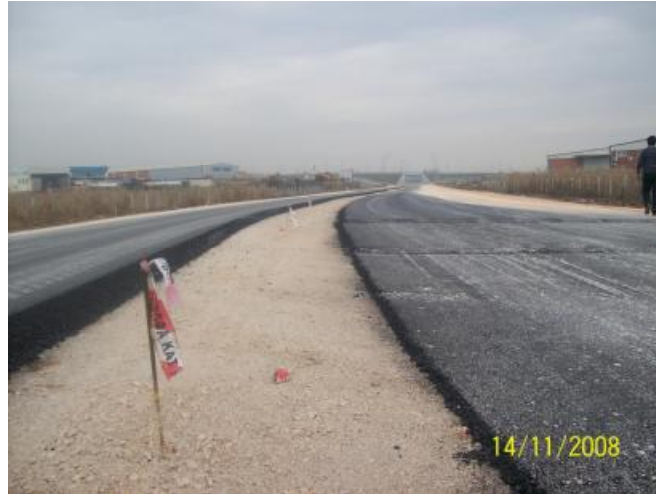
Θέση από όπου έγινε η παραλαβή εδαφικού υλικού
