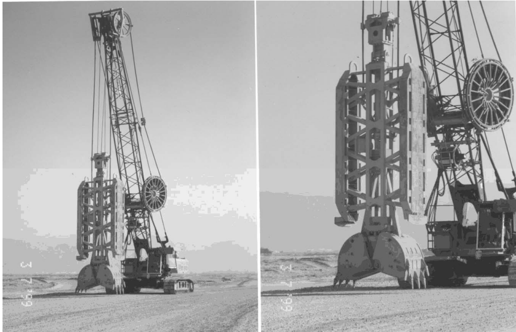
Μηχανικός εξοπλισμός χρησιμοποιούμενος για την κατασκευή διαφραγμάτων
