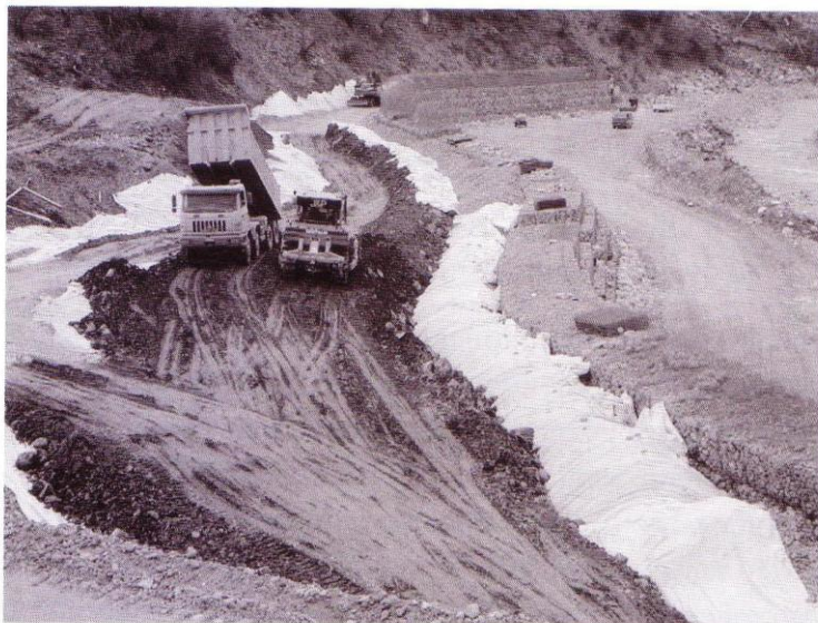
Εικόνα Αντίβαρο ποδός επιχώματος με διάταξη συρματοκιβωτίου.
