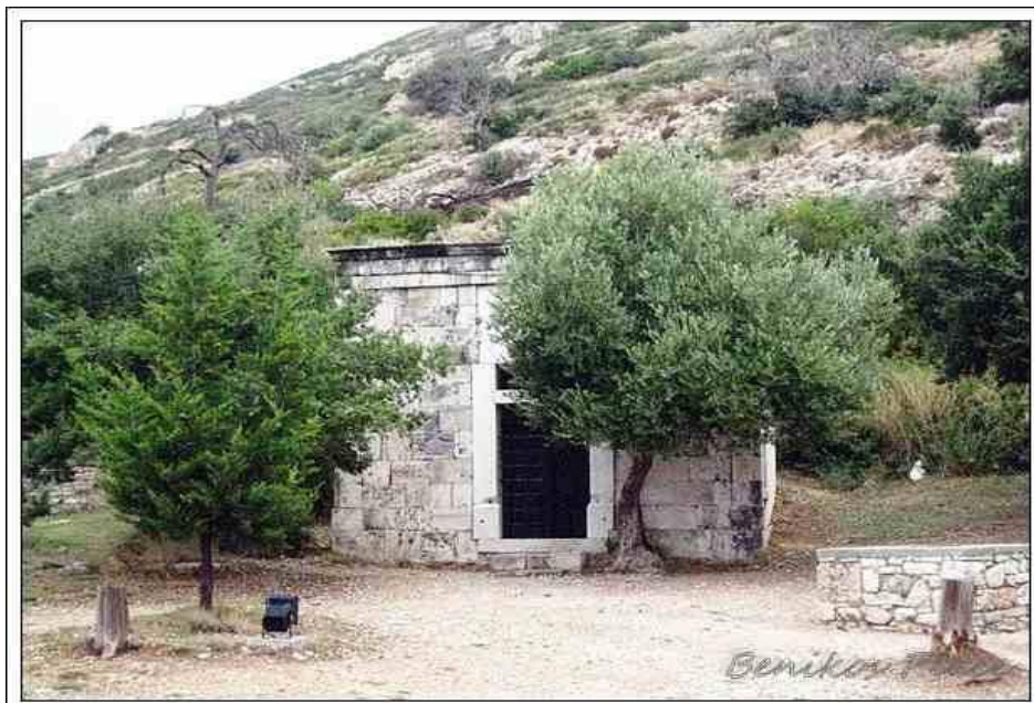
Εικόνα 7.3 κτίσμα στη νότια είσοδο
