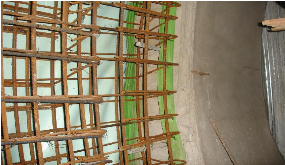
(εικόνα 30 Τμηματική σκυροδέτηση τελικής επένδυσης και τοποθέτηση μεμβράνης στην επιφάνεια του)
