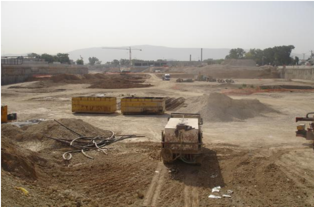
(εικόνα 26 Περιοχή Αμαξοστάσιου -Έξω από την σήραγγα)
