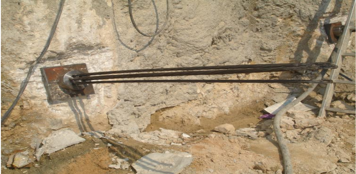
(εικόνα 22 Τοποθέτηση αγκυρίου στον πάσσαλο)
