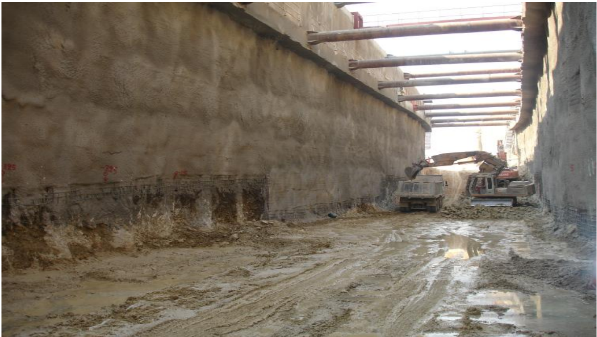
(εικόνα 23 Σκυροδετημένο πλέγμα πάνω στους πασσάλους)
