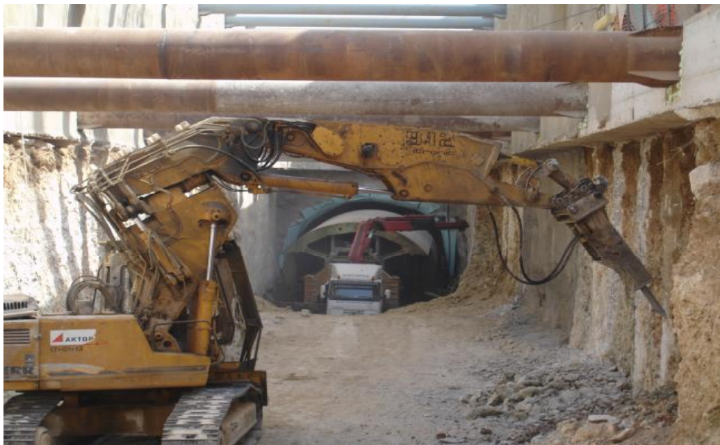
(εικόνα 27 Εργασίες στο τμήμα cut and cover )
