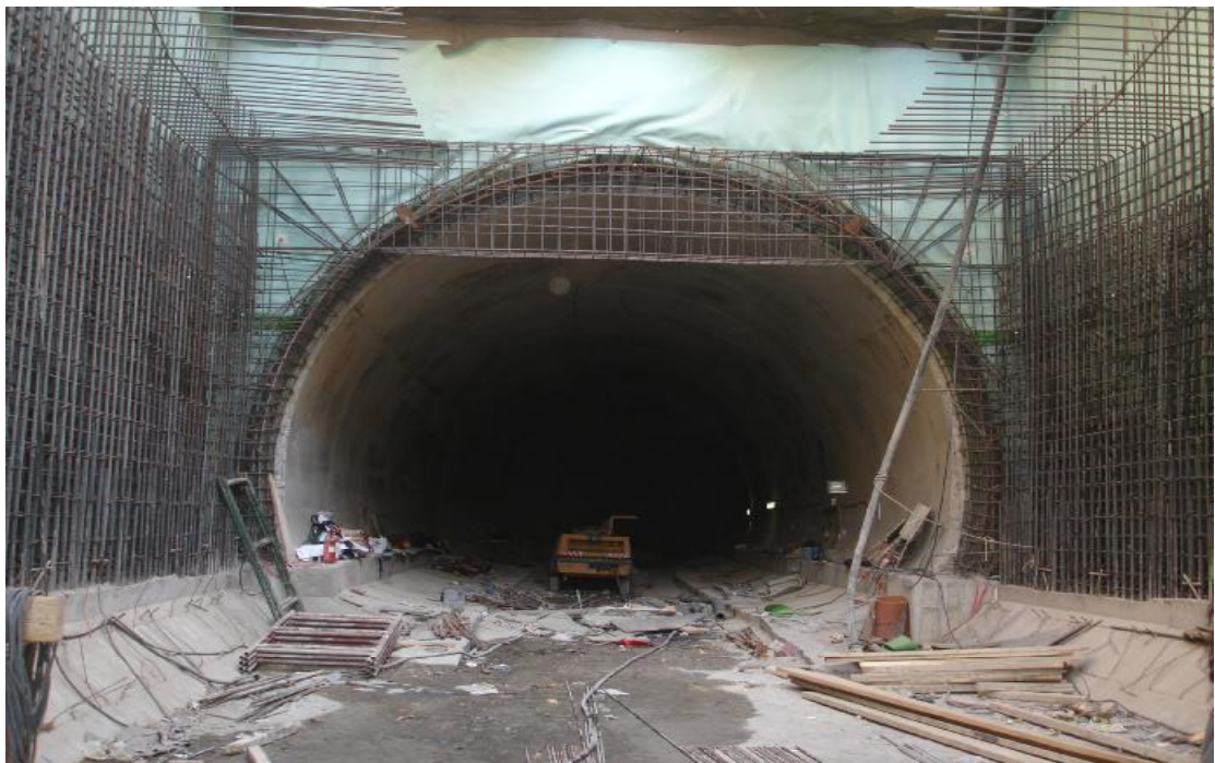
(εικόνα 39 Τοποθέτηση οπλισμού οροφής στο σημείο του τοξωτού κελύφους)
