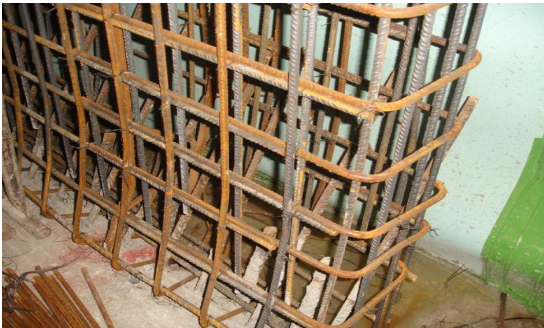
(εικόνα 29 Συνδεσμολογία κύριου οπλισμού κελύφους)
