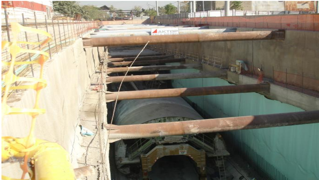
(εικόνα 35 Διπλή στρώση αντηρίδων κεφαλής)
