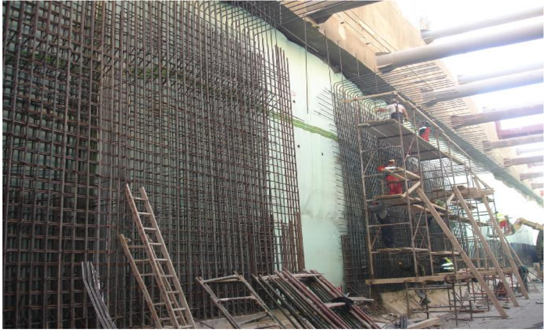
(εικόνα 38 Τοποθέτηση διπλής εσχάρας οπλισμού)
