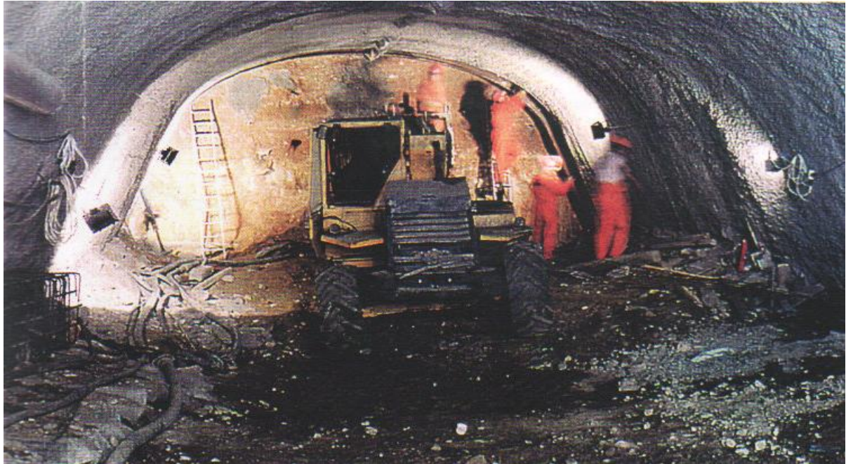
(Εικόνα 2 Φάση εκσκαφής 1)
