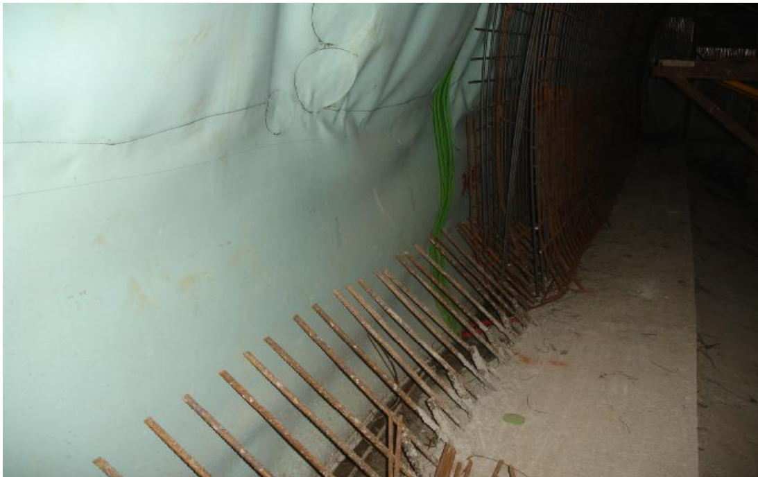
(εικόνα 28 Προεξέχον Οπλισμός αναμονής ποδιού )
