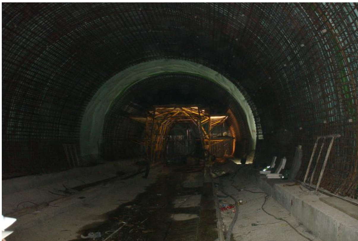
(εικόνα 4 Σκαλωσιά τοποθέτησης μεμβράνης)
