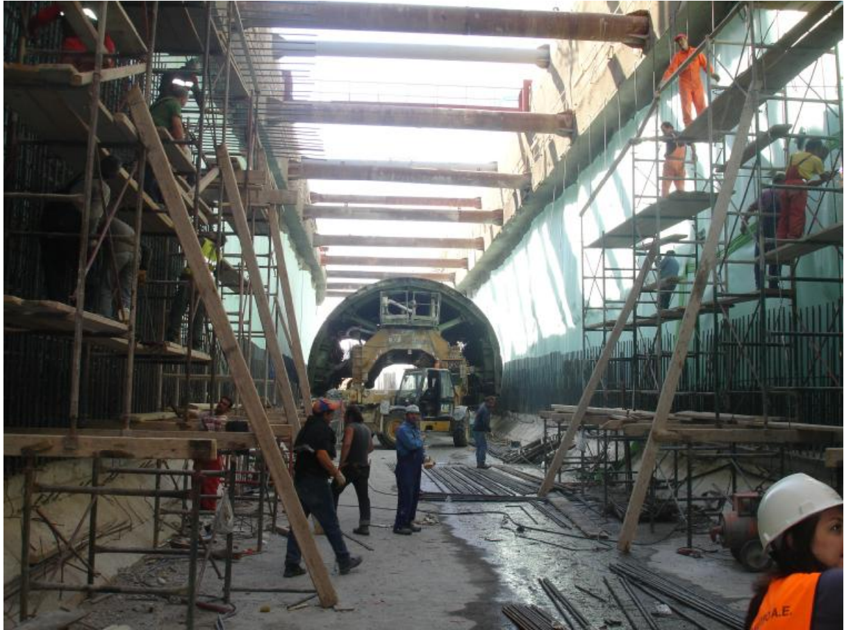
(εικόνα 25 Τοποθέτηση οπλισμού και ξυλότυπου τοιχίων)
