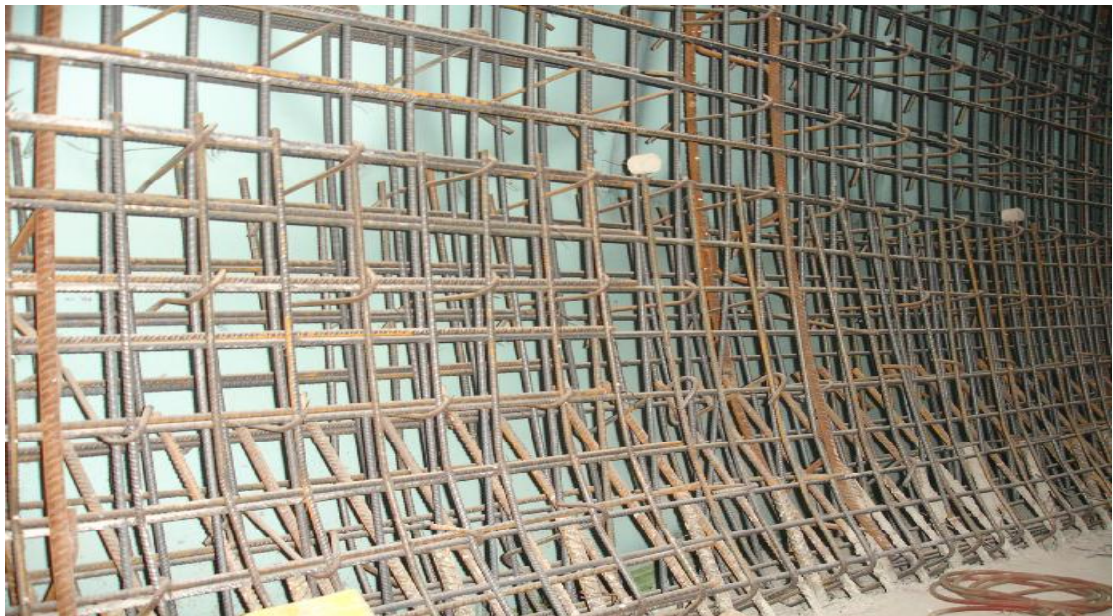
(εικόνα 31 Αποστάτες σχήματος \zeta τοποθετημένη στην διπλή εσχάρα οπλισμού)
