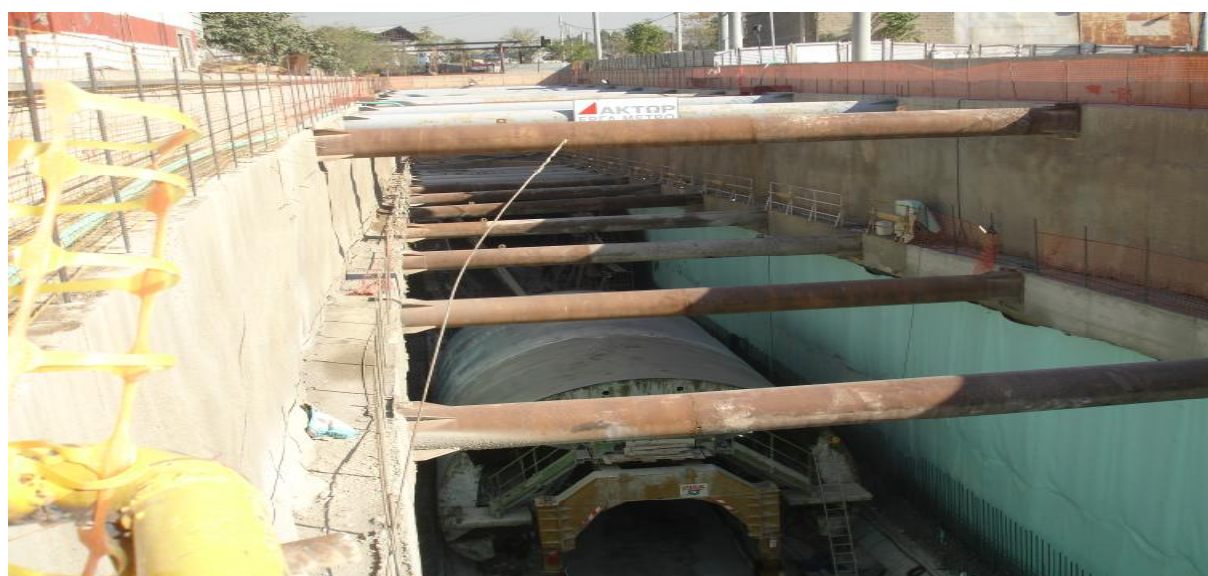
(εικόνα 21 Δοκοί έδρασης με τις αντηρίδες)
