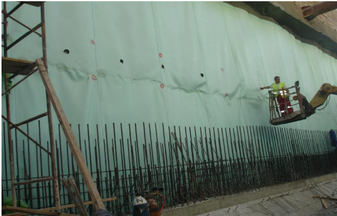
(εικόνα 36 Τοποθέτηση στεγανωτικής μεμβράνης, συρραφή και κάρφωμα)
