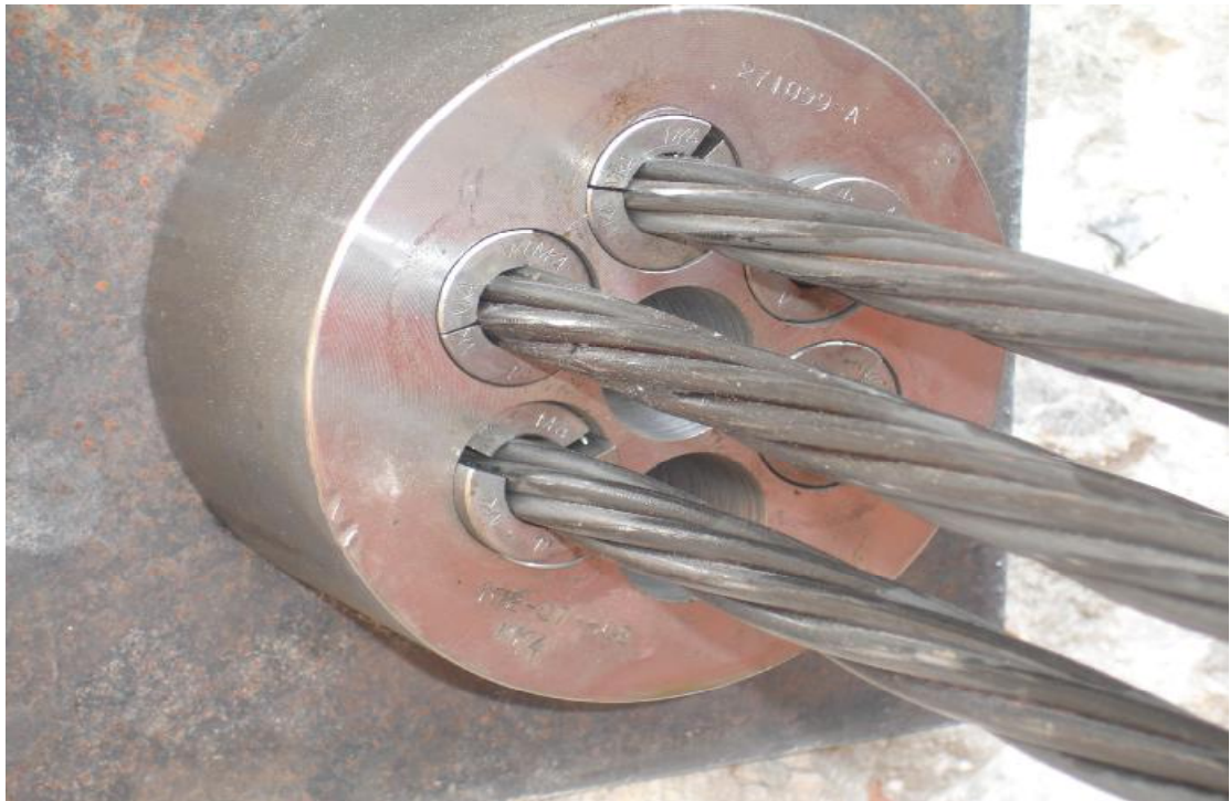
(εικόνα 41 Τοποθετημένο αγκύριο)
