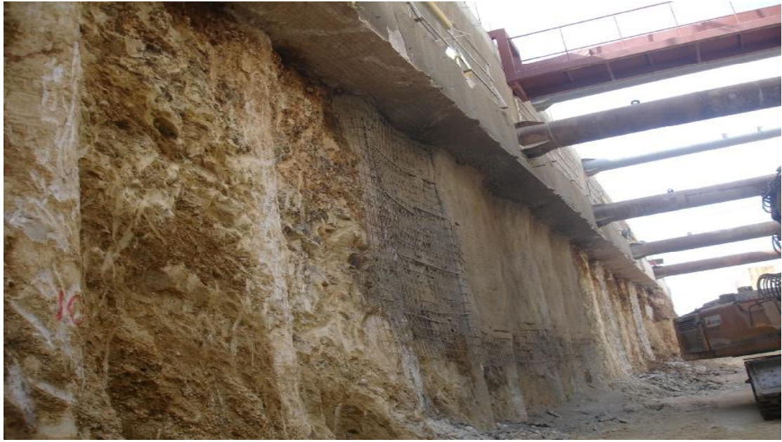
(εικόνα 34 Πάσσαλοι επενδυμένοι με πλέγμα και εκτοξευόμενο σκυρόδεμα)
