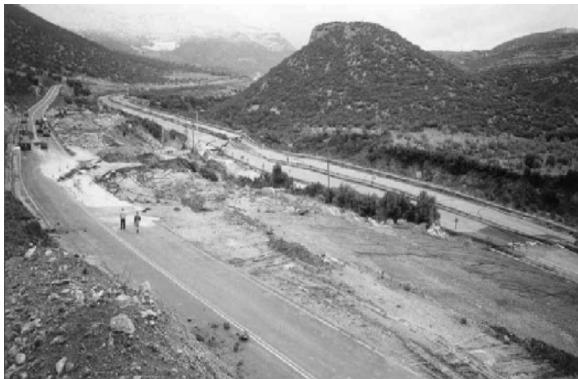
Σχήμα 4. Άποψη της κατολισθημένης μάζας από ανάντη. Διακρίνεται το φρούδι της κατολίσθησης που έφτασε έως το μέσο του ανάντη της Ε.Ο. παράδρομου.
