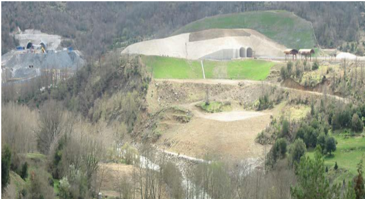
Εικόνα 10. Φωτογραφία της κατολίθησης της Περιοχής Δ3 μετά τα έργα σταθεροποίησης και του κατασκευασμένου Τεχνικού Σ2 του Τμήματος 3.1 (Μ. Περιστέρι - Ανθοχώρι) της Εγνατίας Οδού. Στο βάθος αριστερά διακρίνεται η είσοδος της Σήραγγας Ανθοχωρίου.
