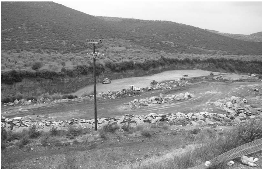
Σχήμα 7. Αποψη της περιοχής ενδιαφέροντος κατά την κατασκευή του σταθεροποιητικού επιχώματος.
