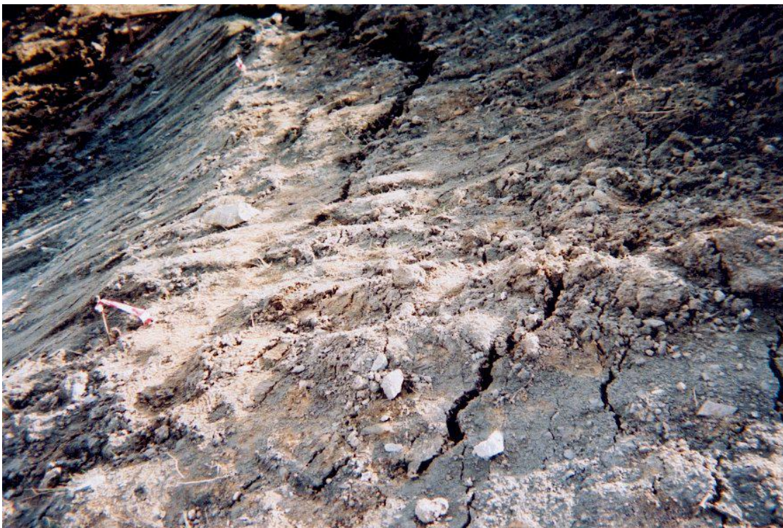
Φωτ. 1 και 2: Αποκόλληση (ρηγμάτωση) του άνω τμήματος του Νότιου πρανούς κάτω από τους στόχους Σ5 και Σ6, με σύγχρονη εμφάνιση μεγάλης υδροφορίας (η οποία όμως εκτονώθηκε σύντομα).
