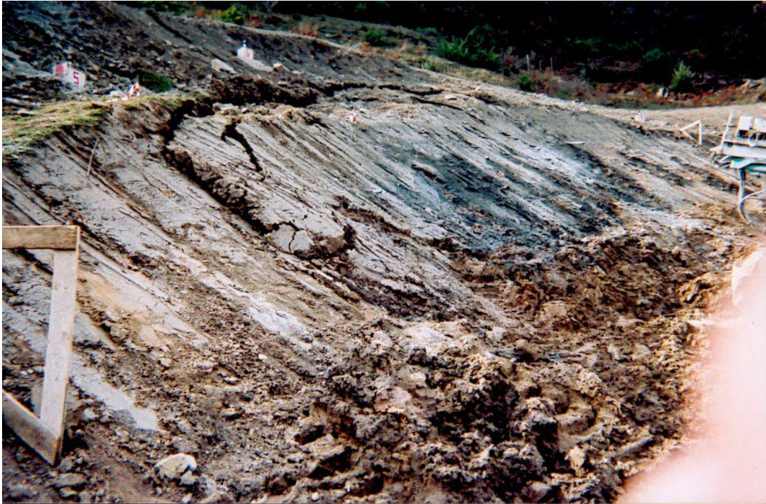
Φωτ. 1 και 2: Αποκόλληση (ρηγμάτωση) του άνω τμήματος του Νότιου πρανούς κάτω από τους στόχους Σ5 και Σ6, με σύγχρονη εμφάνιση μεγάλης υδροφορίας (η οποία όμως εκτονώθηκε σύντομα).
