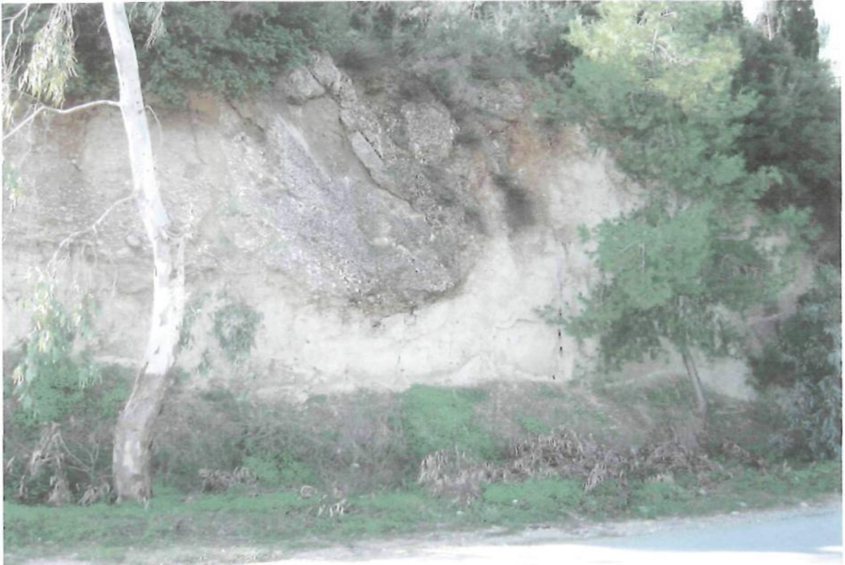
ΦΩΤΟΓΡΑΦΙΑ 7 : Χ. Θ 0+200 3ου Τμήματος Αμμώχες μάργες του Ρέθιου - Δένδρου με χαλαράκροκαλοπαγή στην βάση τους
