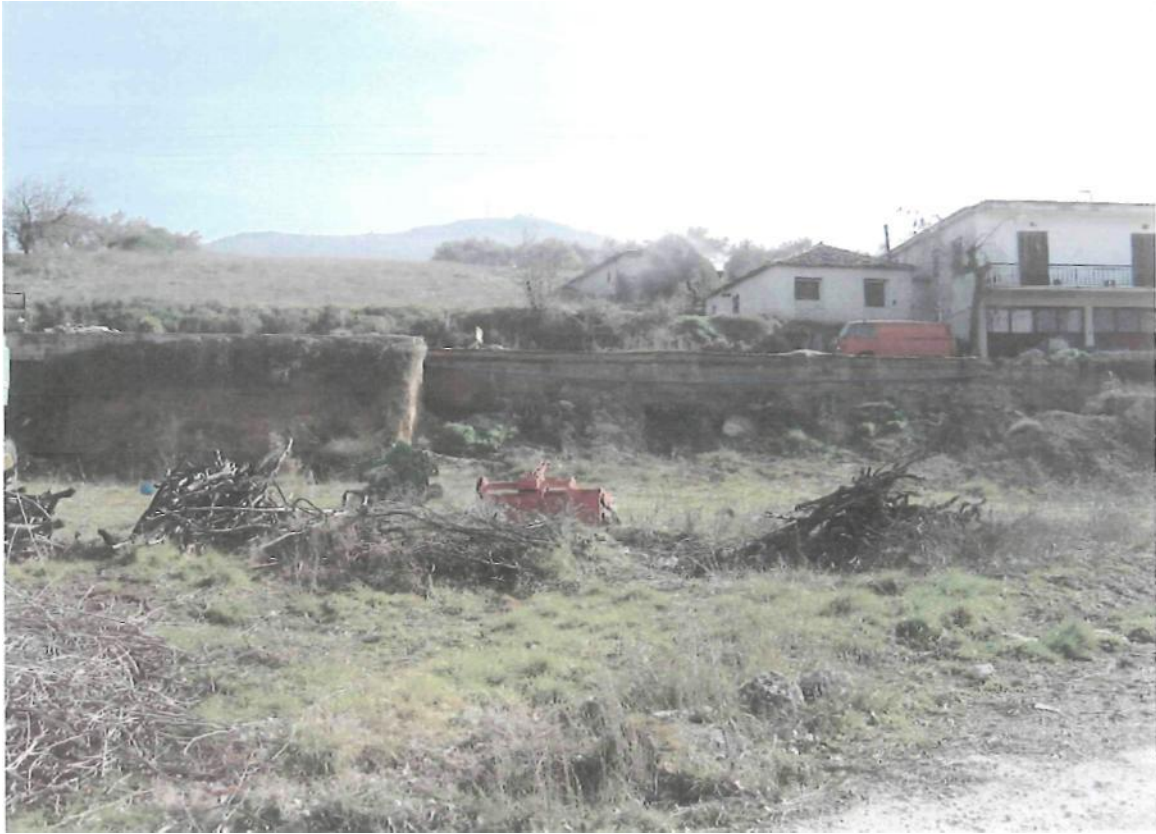
ΦΩΤΟΓΡΑΦΙΑ 3 : Χ. Θ 0+000 2ου Τμήματος Ο οδικός άξονας επικάθεται στα πλευρικά κορήματα
