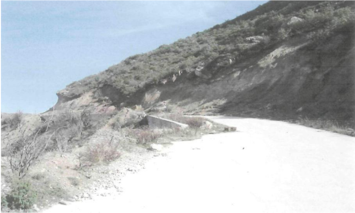
ΦΩΤΟΓΡΑΦΙΑ 11 : Χ. Θ 17+200 3ου Τμήματος Σχηματισμοί Μεγάλου Βάλτου με φαινόμενα ιλυοροής
