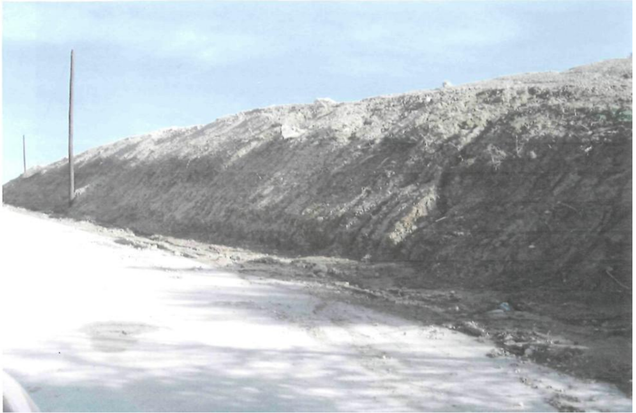
ΦΩΤΟΓΡΑΦΙΑ 5 : Χ. Θ 7+800 2ου Τμήματος Μάργες του πλειόκαινου με ίλυοροή
