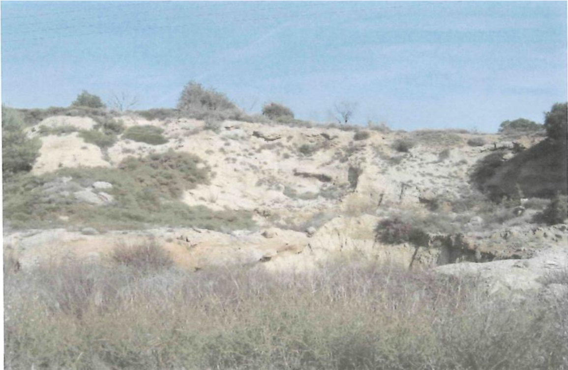
ΦΩΤΟΓΡΑΦΙΑ 4 : Χ.Θ 3+100 2ου Τμήματος Στο πρανές ορατά είναι τα κροκαλοπαγή πλειόκαινου
