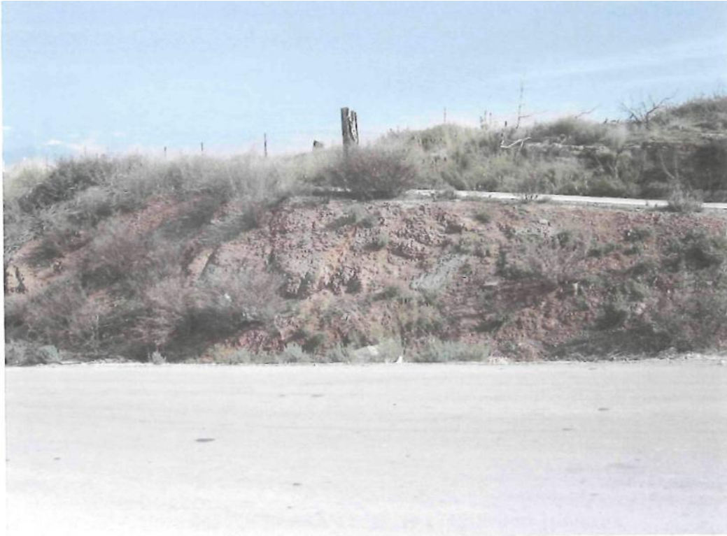
ΦΩΤΟΓΡΑΦΙΑ 9 : Χ. Θ 5+900 3ου Τμήματος Κολλουβιακοί σχηματισμοί
