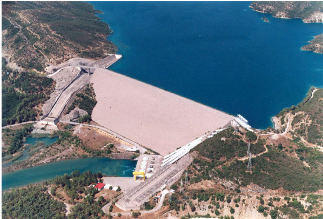
Φωτ. 6 Χωμάτινο φράγμα
