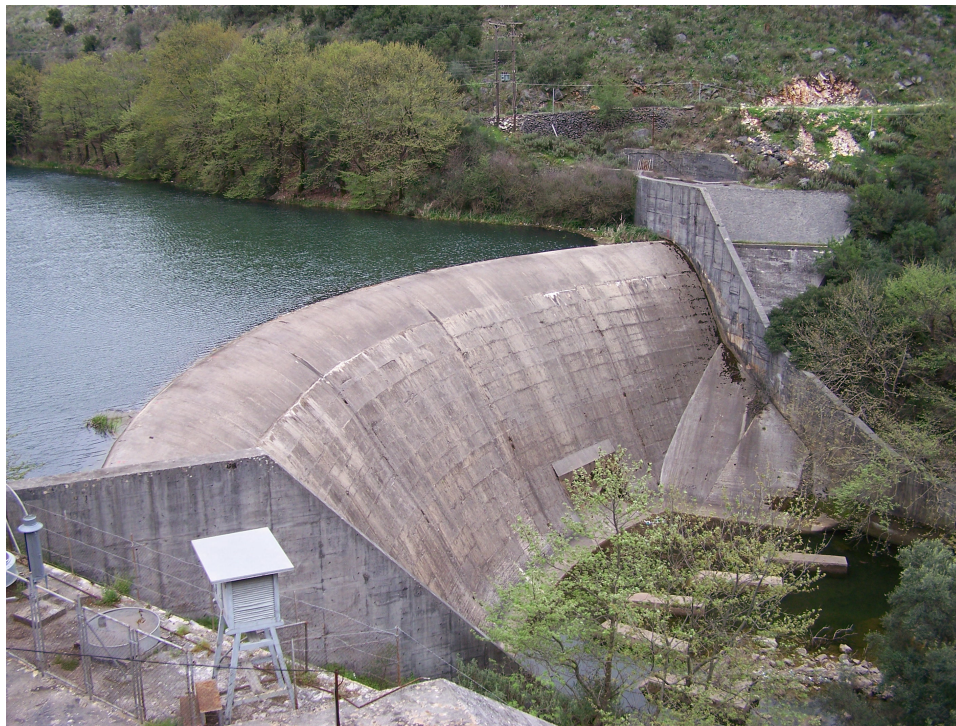
Φωτ. 4 Φράγμα Λούρου
