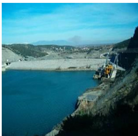
Εικόνα 1.5: Φράγμα αντιστρεπτής λειτουργίας της Σφηκιάς
