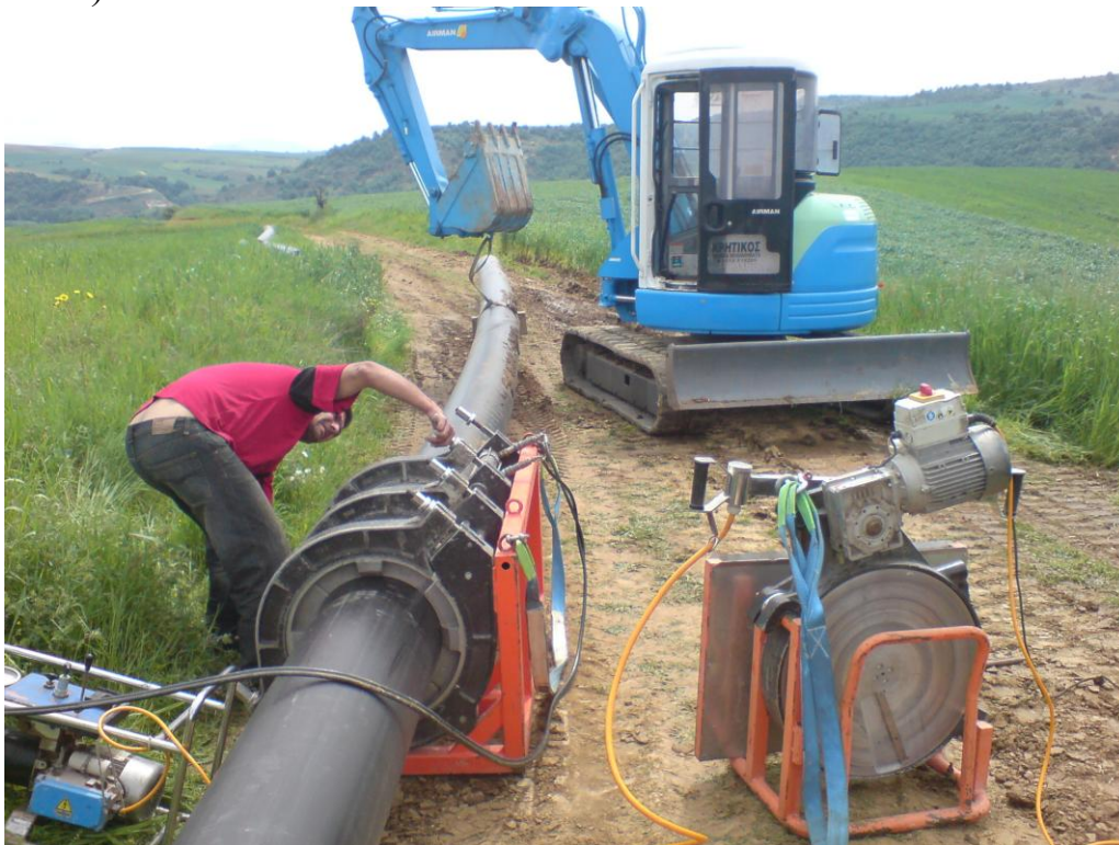
Σχήμα 3.5 Μετωπική συγκόλληση
