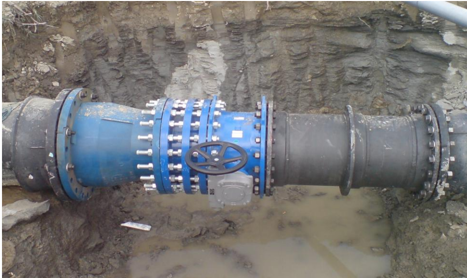
Σχήμα 2.30 Δικλείδα ελέγχου
