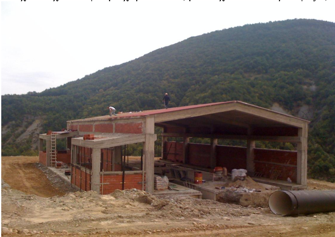
Σχήμα 3.4 Κτίριο εγκατάστασης φίλτρανσης νερού
