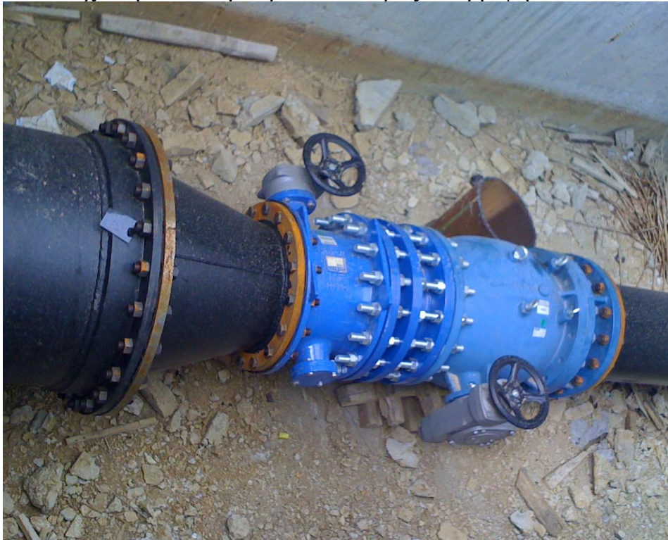
Σχήμα 3.6 Συστολή αγωγού
