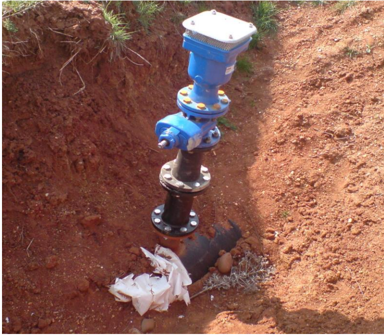
Σχήμα 2.31 Αεροεξαγωγός
