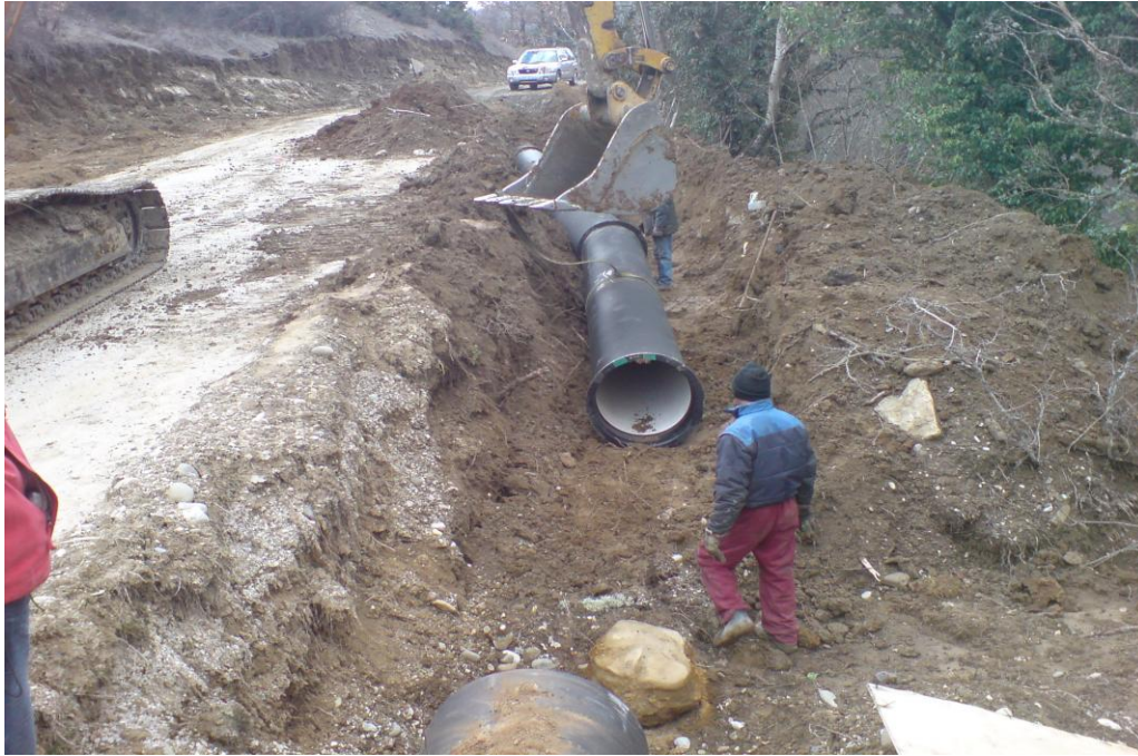
Σχήμα 3.3 Αγωγός προσαγωγής Φ700
