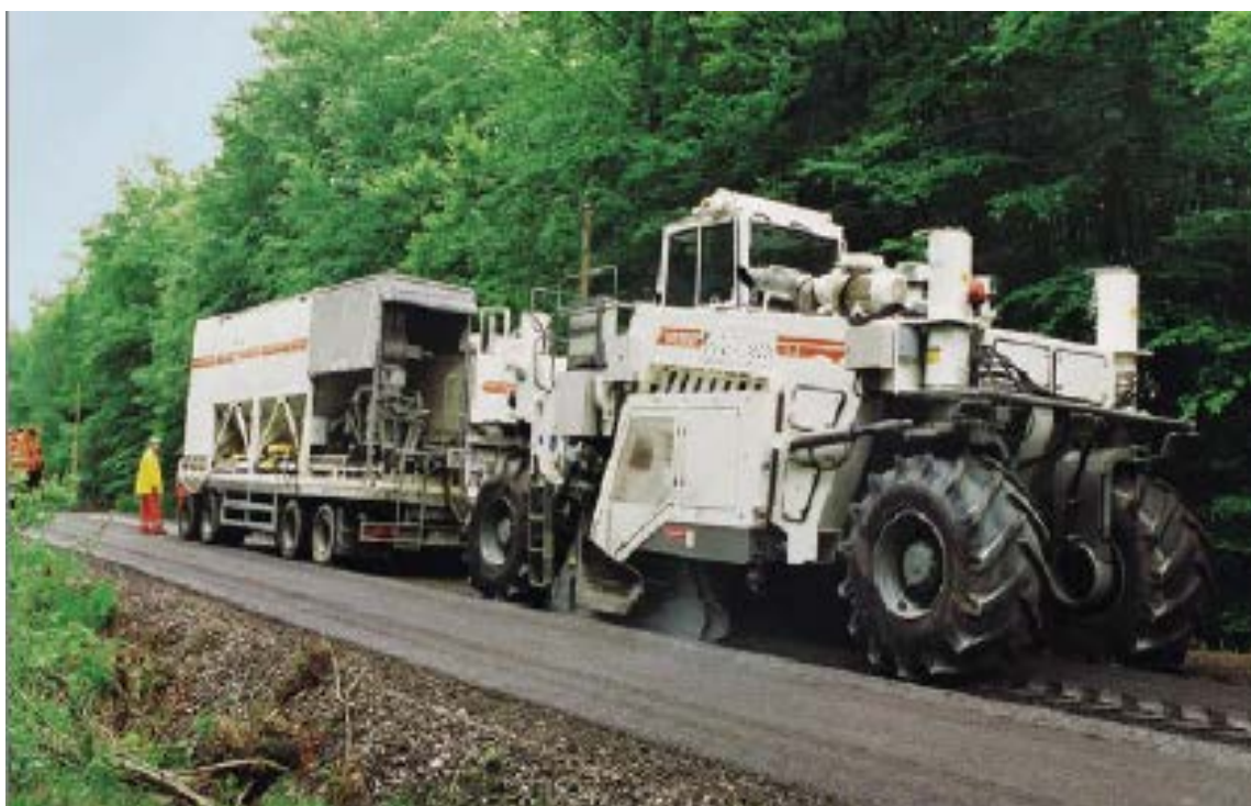
Εικόνα 47. Ειδική φρέζα με δυνατότητα ανάμιξης και διάστρωσης για ανακύκλωση της οδού εν ψυχρώ
