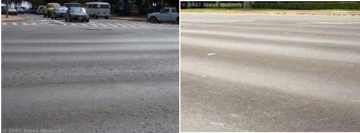
Εικόνα 22. Αυλακώσεις στις τροχιές των τροχών
