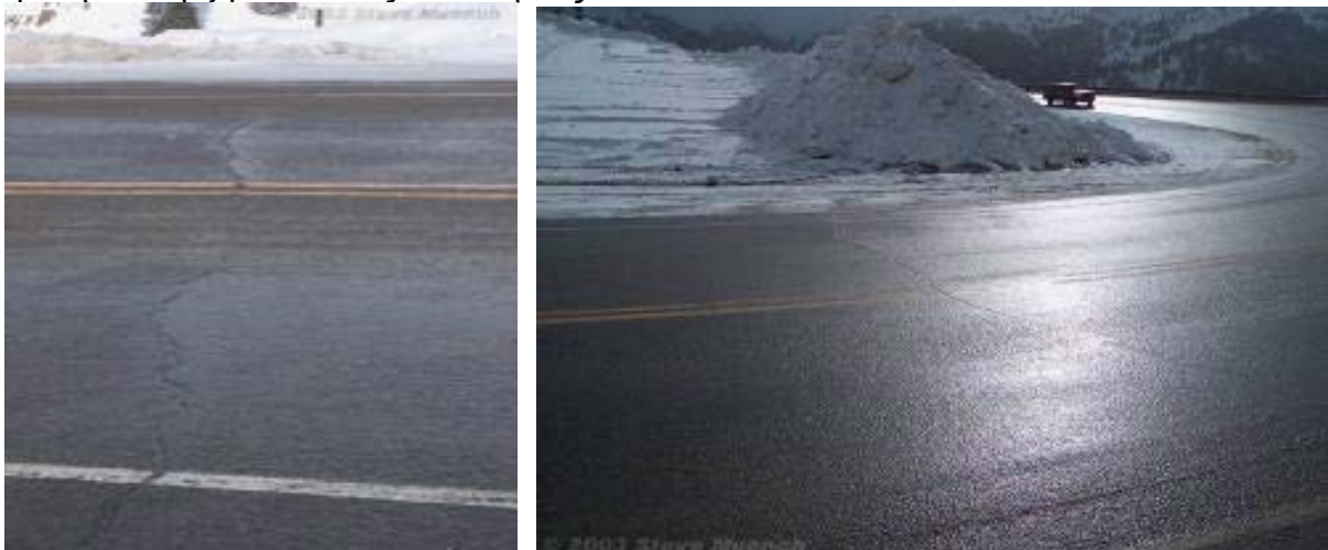
Εικόνα 29. Εγκάρσιες ρωγμές
