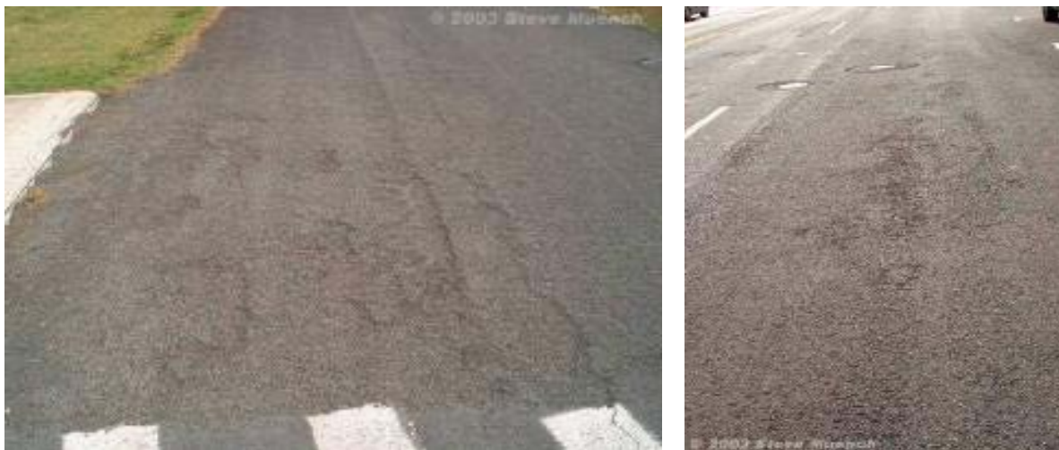
Εικόνα 26. Αποκόλληση αδρανών
