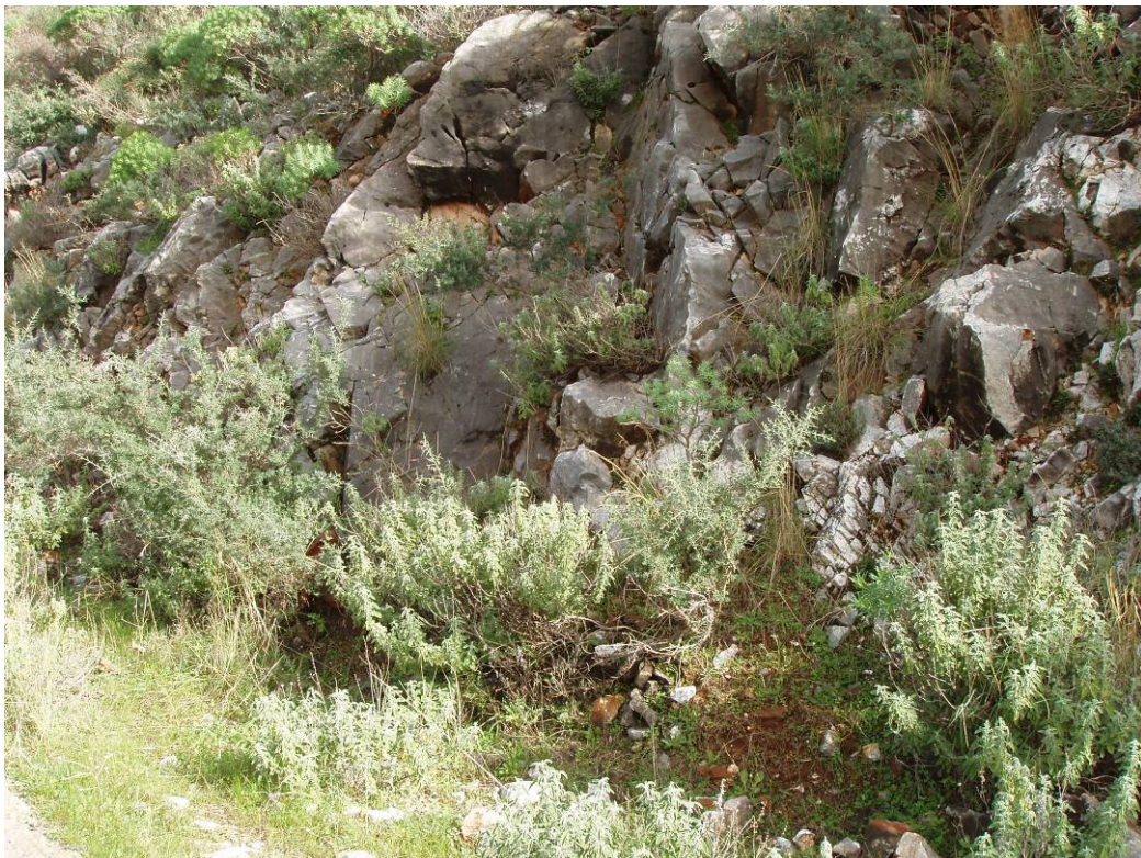
Φωτ. 2 Άποψη των άστρωτων έως παχυστρωματωδών, τεφρόχρωμων, συμπαγών, κρυσταλλικών και καρστικοποιημένων ασβεστόλιθων (Κ.κ), ανάντη της χάραξης, περί τη Χ.Θ. 1+370.
