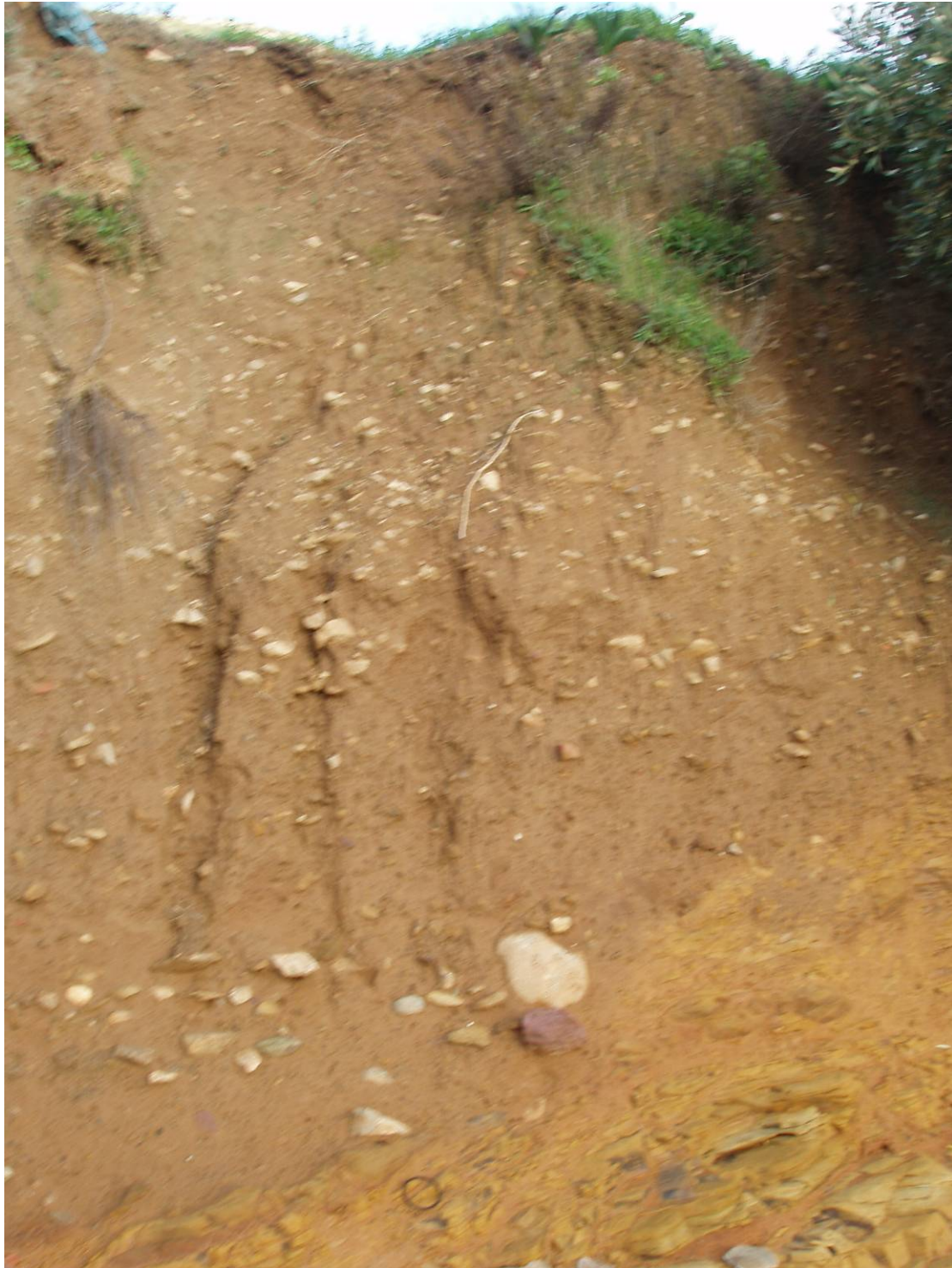
Φωτ. 7 Λεπτομέρεια των σχιστολιθικών και φυλλιτικών, πλευρικών κορημάτων (sc-sch), πάχους 1\pm 1,5\text{m} , σε απόσταση 200m κατόντη της χάραξης από την Χ.Θ. 3+000, ενώ στο κάτω μέρος της φωτογραφίας διακρίνονται οι πηλιτικοί – μαργαϊκοί σχιστόλιθοι (f.sch-ph).
