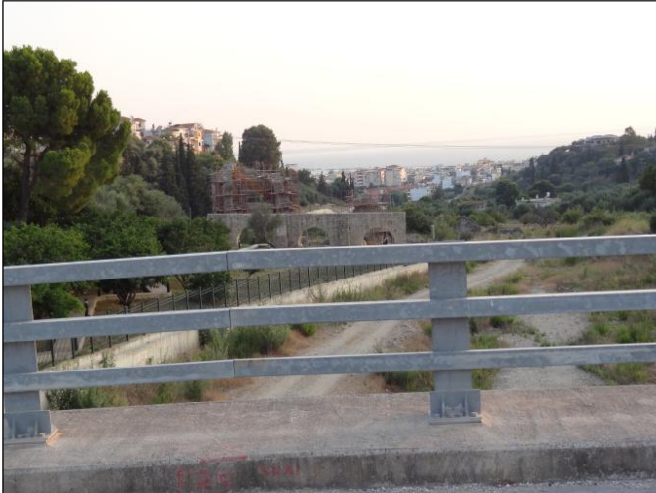
7. ΑΠΟΨΗ ΤΟΥ ΥΔΡΑΓΩΓΕΙΟΥ ΑΠΟ ΤΗ ΓΕΦΥΡΑ Η ΟΠΟΙΑ ΕΞΥΠΗΡΕΤΕΙ ΤΟΥΣ ΚΑΤΟΙΚΟΥΣ ΤΗΣ ΠΕΡΙΟΧΗΣ. (ΣΤΟ ΒΑΘΟΣ ΤΟ ΥΔΡΑΓΩΓΕΙΟ)
