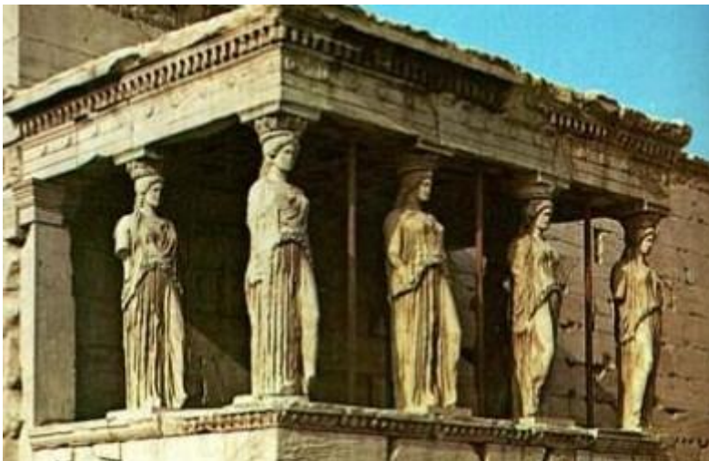
4.2.1 Η γυψοποίηση στην επιφάνεια του πεντελικού μαρμάρου απαλείφει τις λεπτομέρειες από το πρόσωπο και το χιτώνα των Καρυάτιδων
