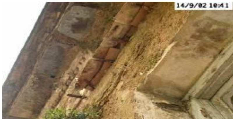
2.3.6 Βλάβες σε τοιχοποιία από την υγρασία και τις ρίζες των φυτών
