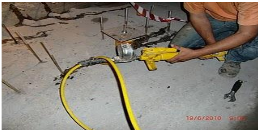
8.10 Δοκιμές εξόλκευσης βλήτρων
