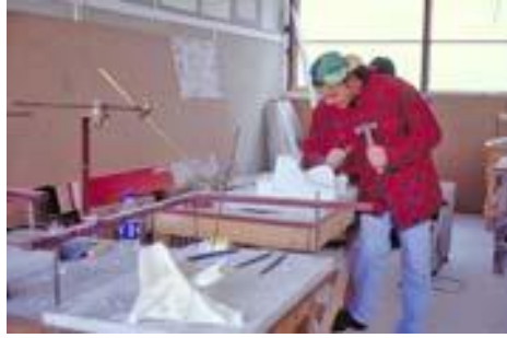
Π9: Δομική αποκατάσταση τμημάτων του Παρθενώνα
