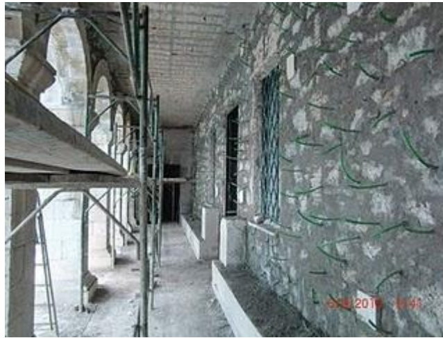
8.7 Τσιμεντενέσεις ομογενοποίησης λιθοδομής
