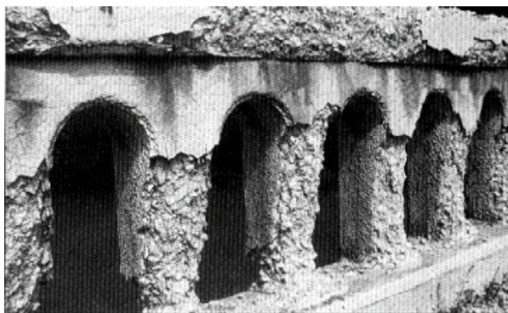
7.1 Χαρακτηριστικό παράδειγμα σκυροδέματος που επιδεινώθηκε από τις δράσεις ψύξης-απόψυξης
