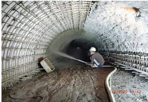
8.3 Εκτόξευση σκυροδέματος με την ξηρά μέθοδο
