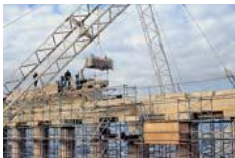
Π8: Αποσυναρμολόγηση τμημάτων του Παρθενώνα
