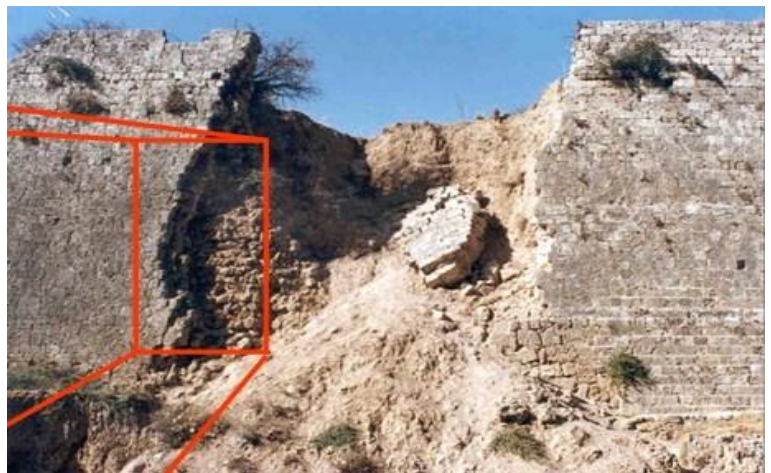
4.4.1 Αποσάθρωση κονιαμάτων σε τοιχοποιίες
