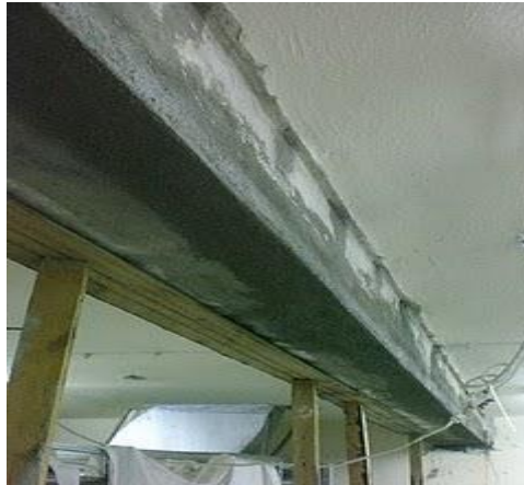
8.6 Αποκατάσταση διατομής δοκού
