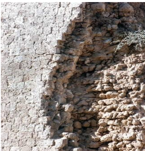
4.4.1 Αποσάθρωση κονιαμάτων σε τοιχοποιίες
