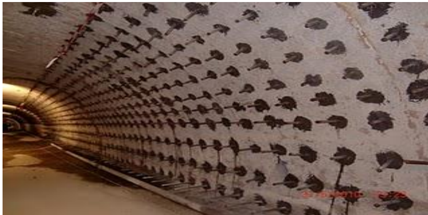
8.9 Τοποθετημένα βλήτρα σε έργο ενίσχυσης οχετού
