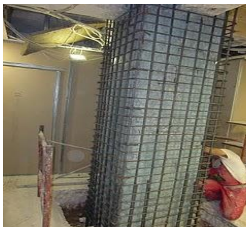
8.2 Τοποθέτηση σιδηρού οπλισμού
