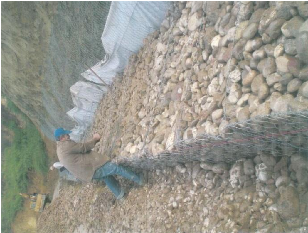
Κατασκευή συρματοκιβωτίου
