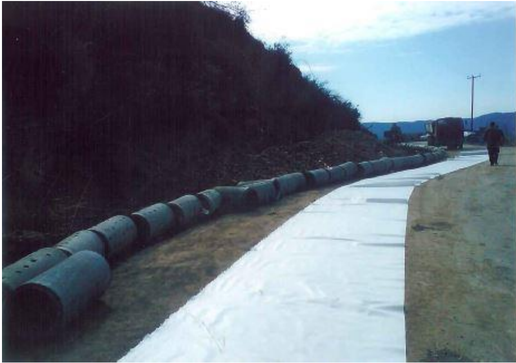
Διάτρητοι τσιμεντοσωλήνες και γεωύφασμα
