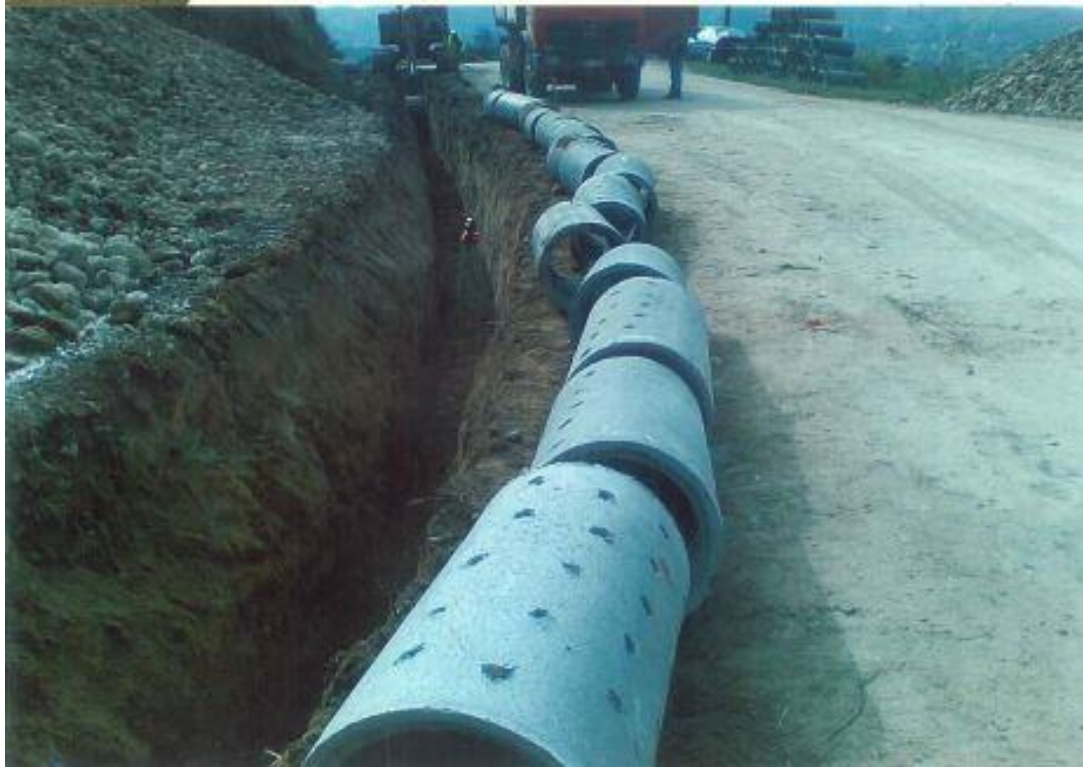
Διάτρητοι τσιμεντοσωλήνες προς τοποθέτηση στο όρυγμα
