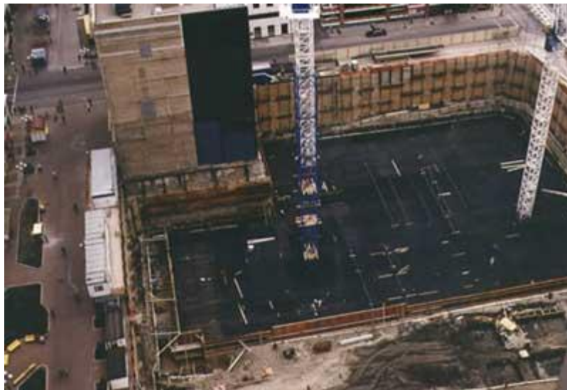
Σχήμα 3.5: Πραγματική εφαρμογή συστήματος πασσαλότοιχων μεμονωμένων πασσάλων.
