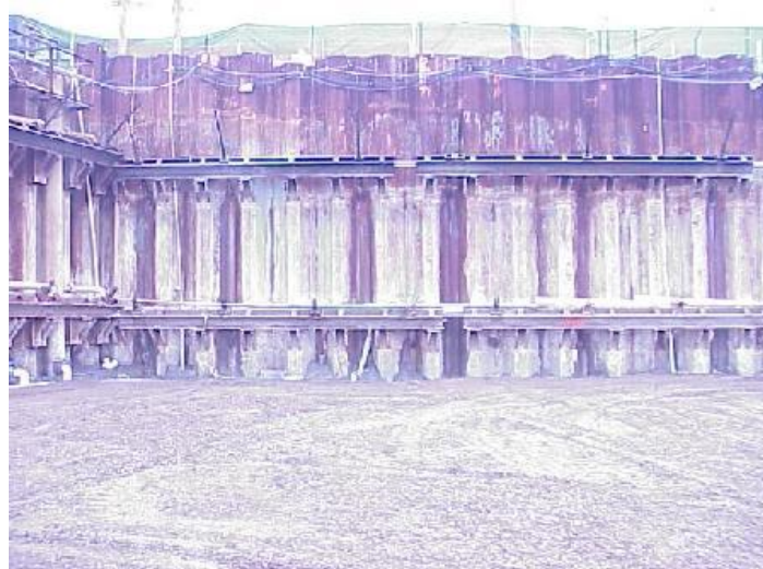
(α) (β) Σχήμα 3.9: Πασσαλότοιχοι με πασσάλους/ελάσματα: α) σχεδιάγραμμα διαδοχικών συνδεδεμένων ελασμάτων και β) φωτογραφία πραγματικής εφαρμογής.
