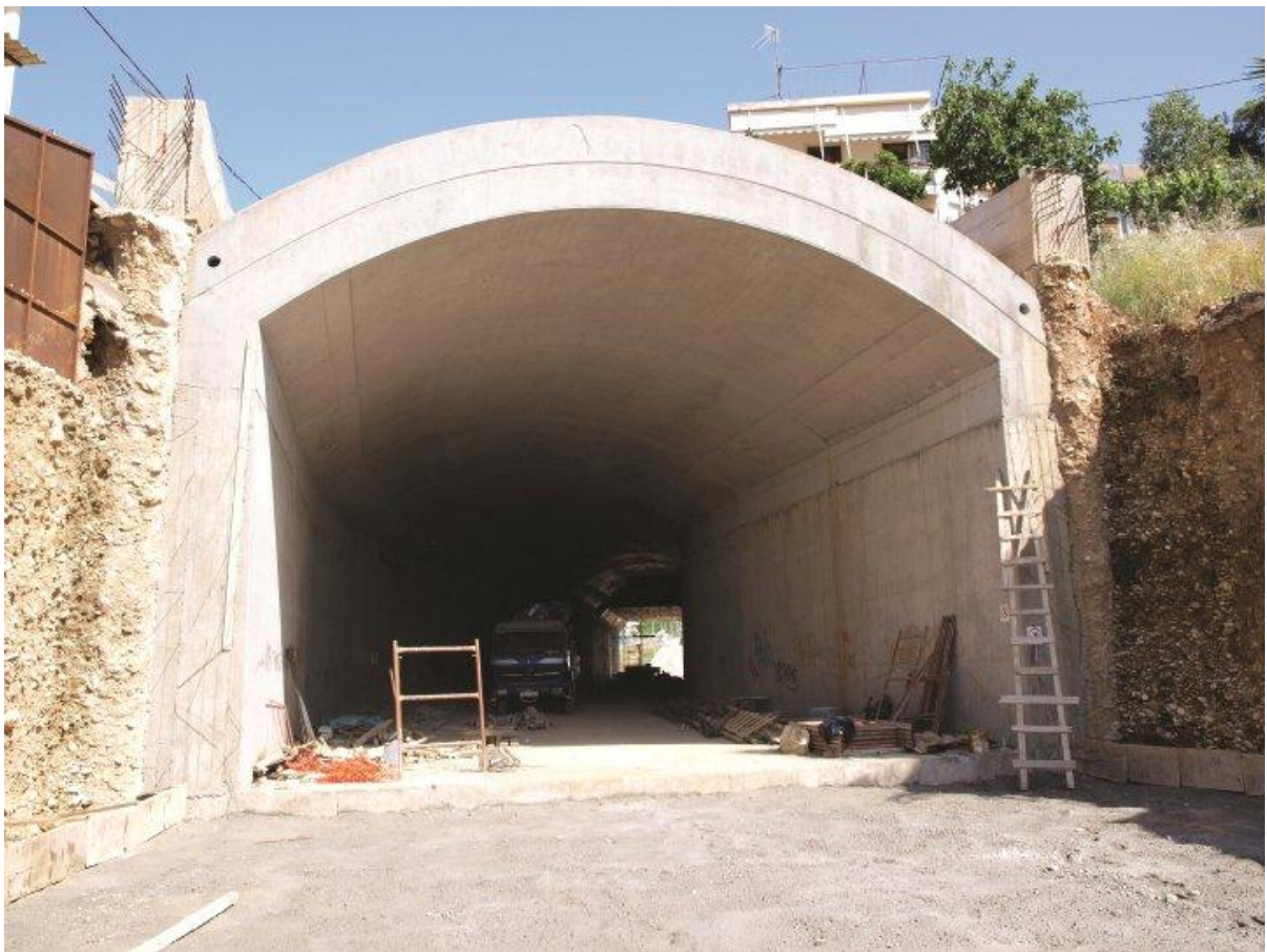
Σχήμα 5.6: Τελική μορφή σήραγγας πριν τα έργα επίχωσης και στεγάνωσης.
