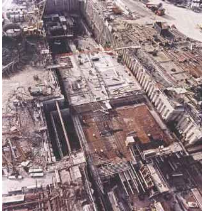
Σχήμα 3.2: Έργο θεμελίωσης κτιριακής κατασκευής με χρήση εφαπτόμενου πασσαλότοιχου.
