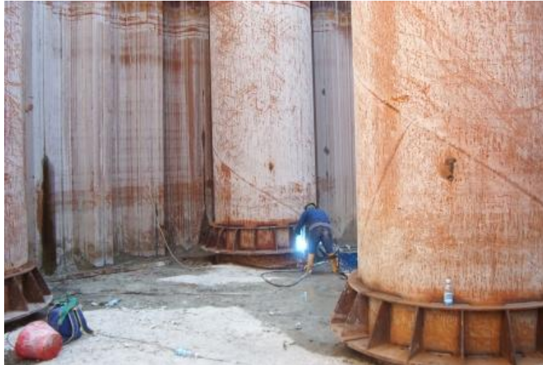
Σχήμα 3.16: Σύστημα αντιστήριξης υδατοστεγούς περιβλήματος για την κατασκευή γέφυρας τραίνων (ποταμός Po, Ιταλία).
