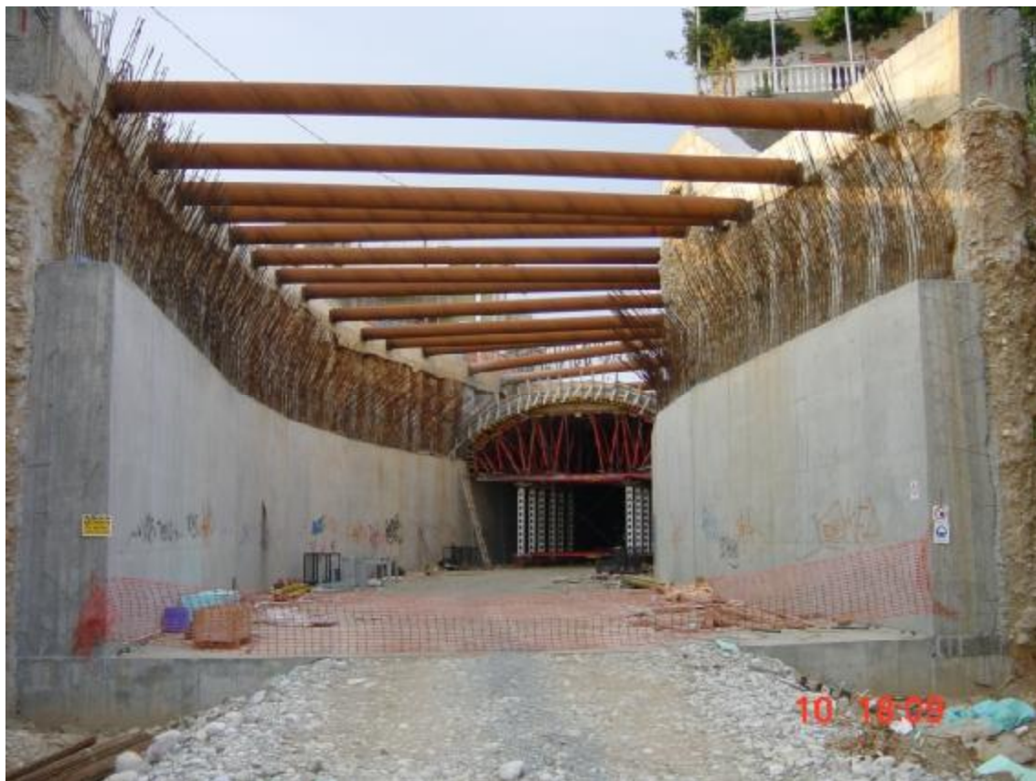
Σχήμα 5.5: Στάδιο έναρξης σκυροδέτησης οροφής σήραγγας.
