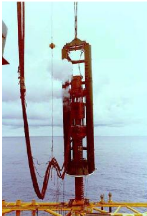
Σχήμα 2.4: Εφαρμογή έμπηξης με σφυρί ατμού.
