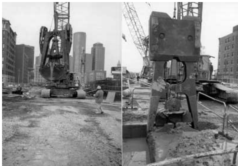
Σχήμα 3.11: Εξοπλισμός εκσκαφής (αριστερά υδραυλικό clamshell και δεξιά μηχανικό)
