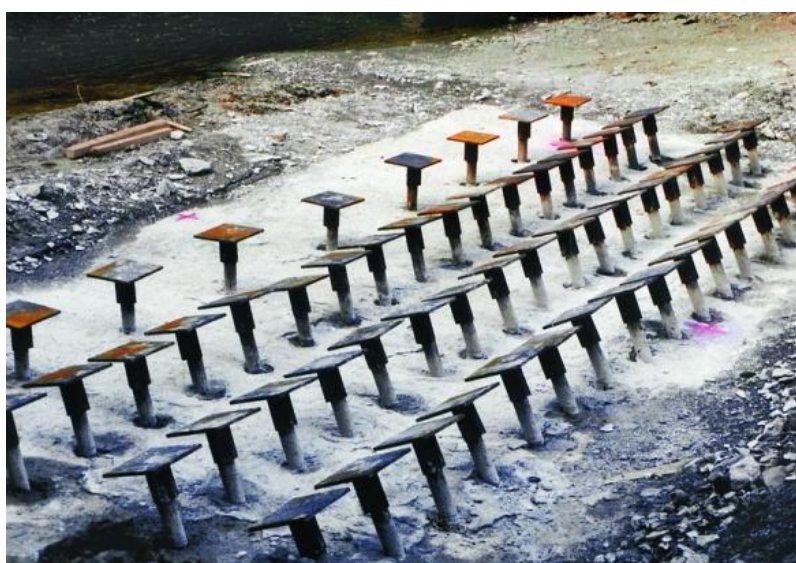
Σχήμα 11: Τυπική εφαρμογή μικροπασσάλων.
