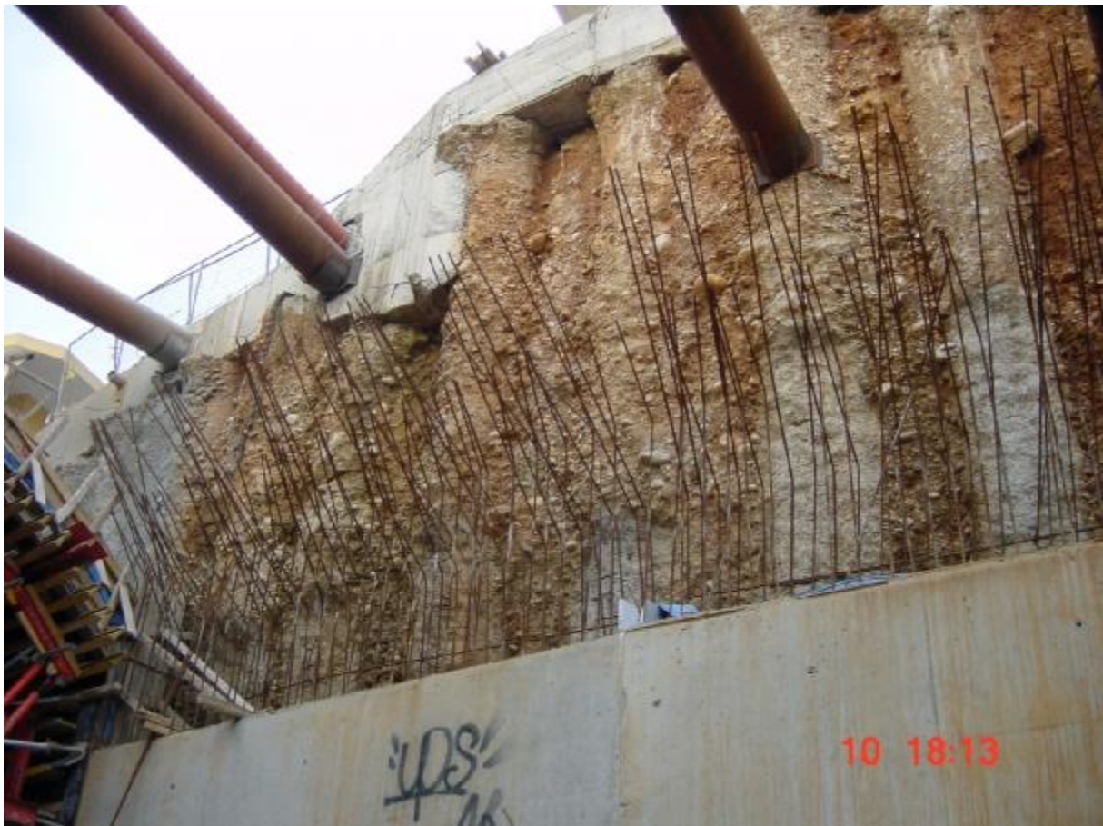
Σχήμα 5.2: Σειρά πασσάλων στη πλαϊνή μεριά της σήραγγας με την πρώτη φάση σκυροδέτησης του διαφραγματικού τοίχου να έχει ολοκληρωθεί.
