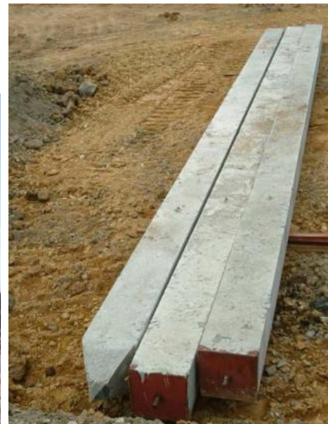
Σχήμα 3: Τυπικοί πάσσαλοι οπλισμένου σκυροδέματος: α) σκυροδετούμενοι στο πεδίο και β) προεντεταμένοι - προκατασκευασμένοι.
