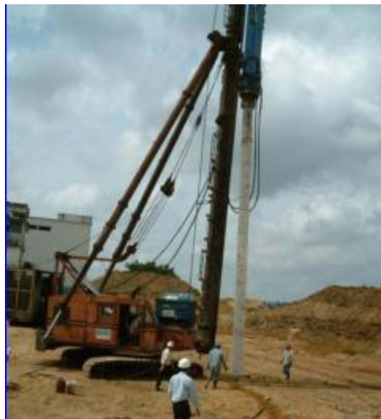
Σχήμα 2.3: Εφαρμογή έμπηξης με σφυρί ντίζελ στο πεδίο.
