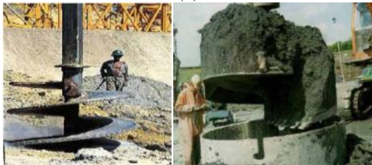
Σχήμα 2.9: α) Μέρη μηχανισμού εκσκαφής (τρυπάνι, εργαλείο μεγέθυνσης οπής και δοχείο εκκαθάρισης) και β) εικόνες κατά τη διάρκεια εκσκαφής.
