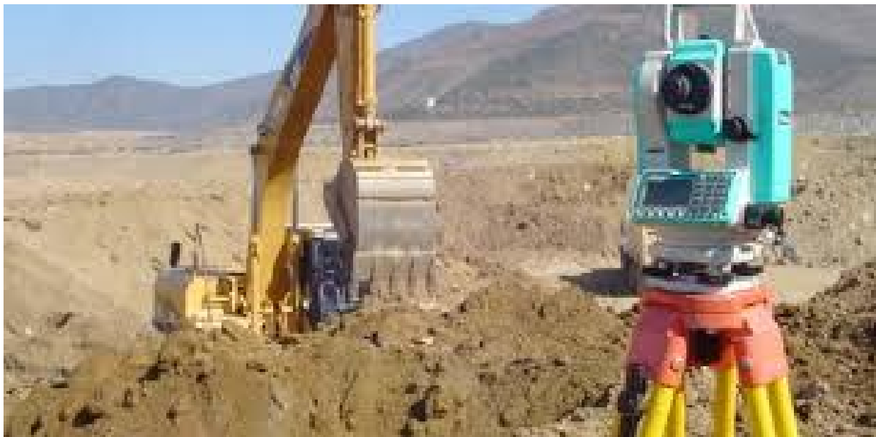
Εικόνα 32. Καθοδήγηση σκαπτικών μηχανημάτων.
