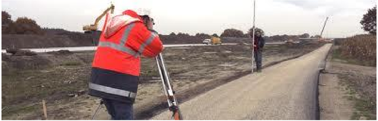
Εικόνα 33. Επαλήθευση άξονα οδού με gps.
