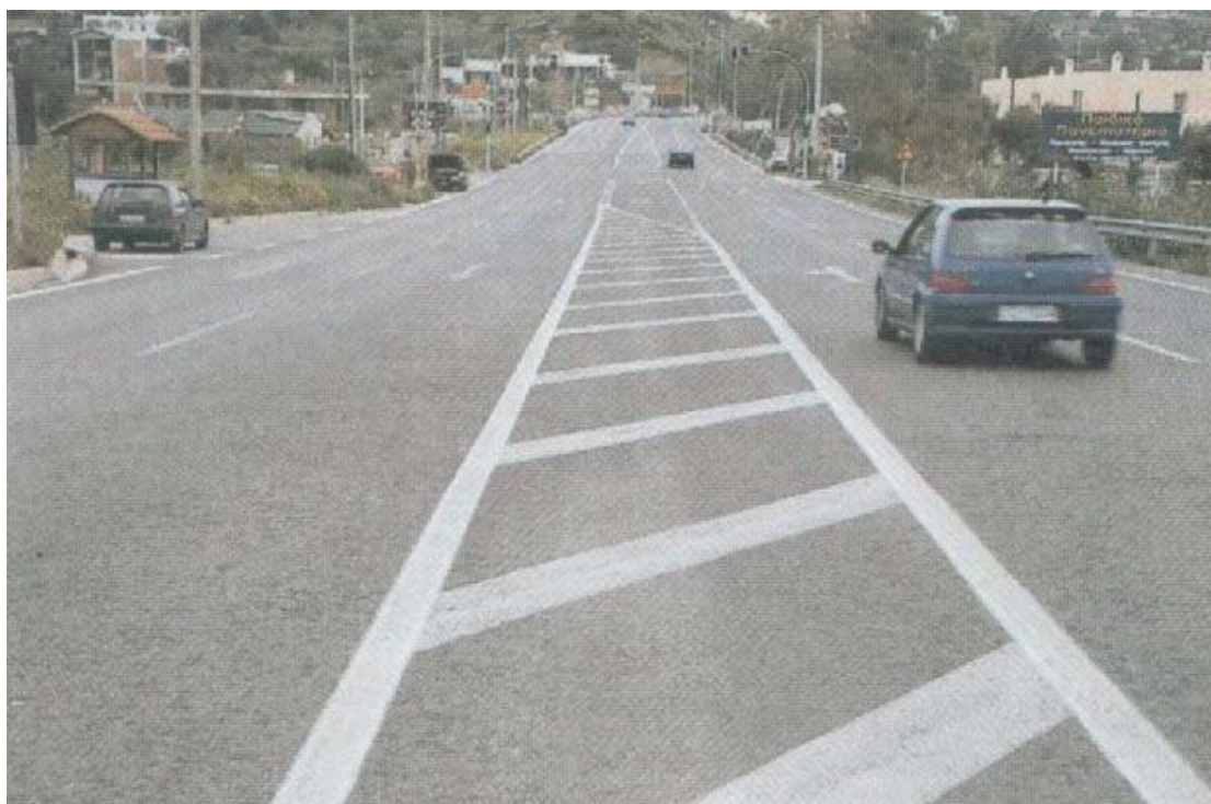
Εικόνα 3.1: Διαγράμμιση επιφάνειας αποκλεισμού οδοστρώματος.
