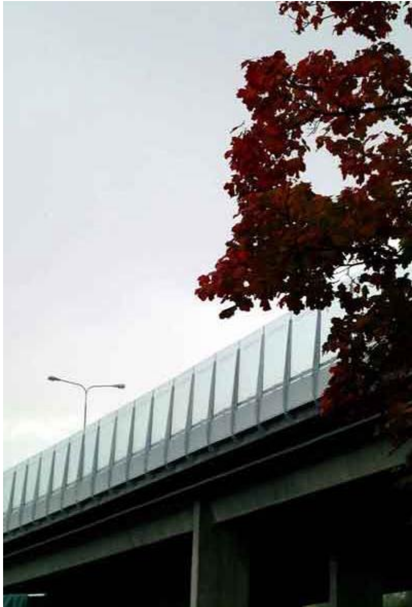
Εικόνα 6.2: Διαφανές ηχοπέτασμα επάνω σε γέφυρα.
