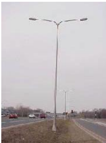
Εικόνα 1.8: Στύλος φωτισμού με διπλό βραχίονα.
