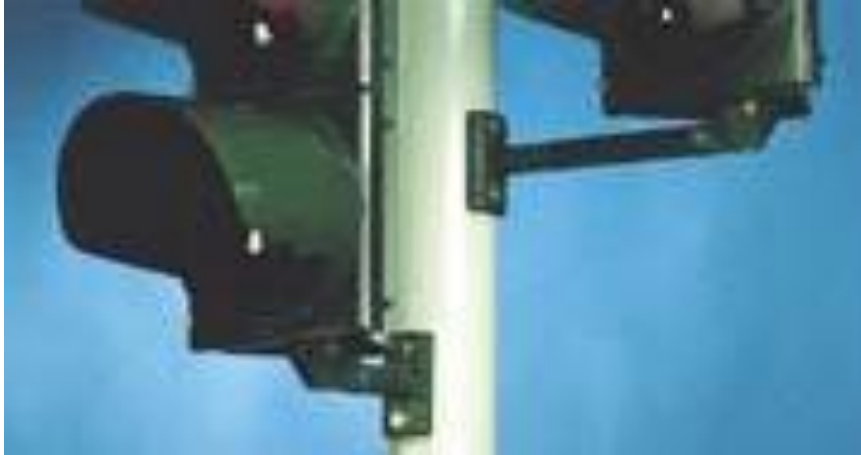
Εικόνα 5.4: Αριστερά στερέωση με απλό βραχίονα και δεξιά με βραχίονα προέκτασης.
