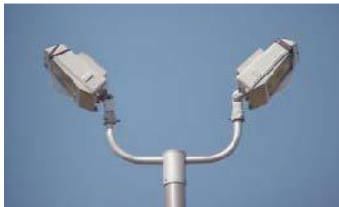
Εικόνα 1.3: Φωτιστικό σώμα κατακόρυφης διάταξης.
