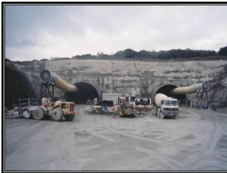
Εργοτάξιο Μετώπου Εισόδου
