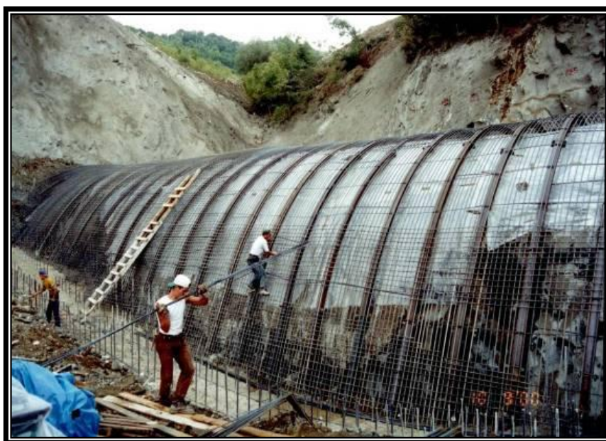
Τεχνικό Μισγάνγειας στο Δεξιό Κλάδο Μετώπου Εξόδου
