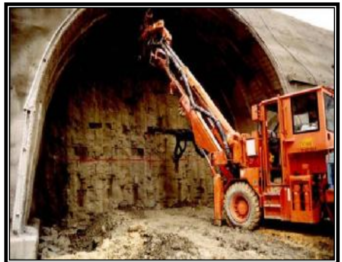
Προπλάισια – Διάτρηση Α.Κ. Μετώπου Εισόδου
