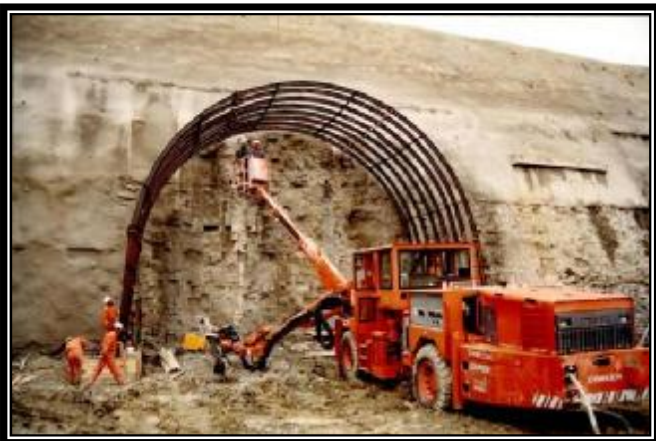
Προπλάισια – Διάτρηση Α.Κ. Μετώπου Εισόδου
