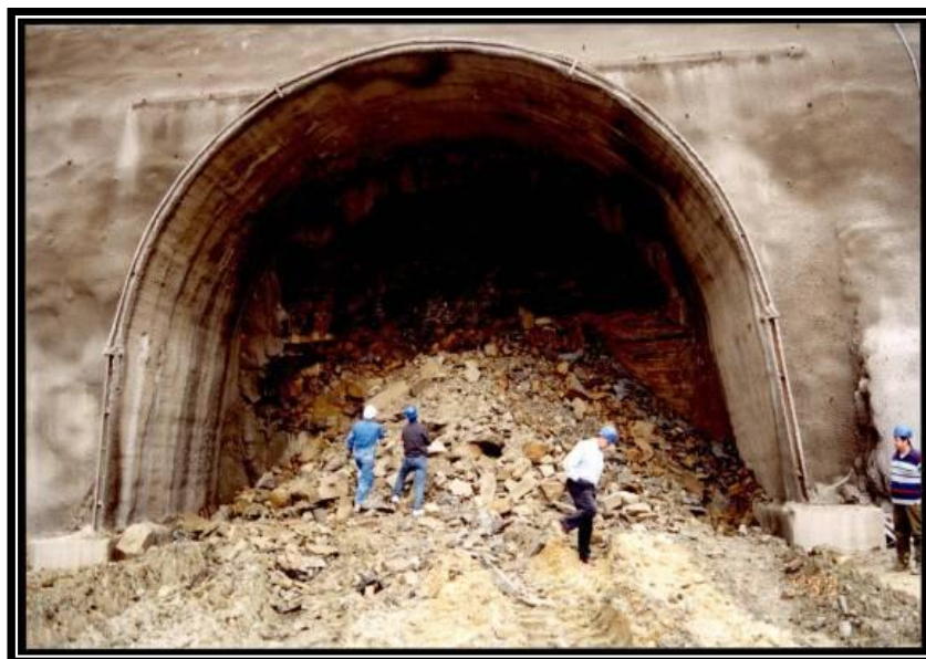
Έναρξη Εκσκαφών Υπογείου Αριστερός Κλάδος Μετώπου Εισόδου
