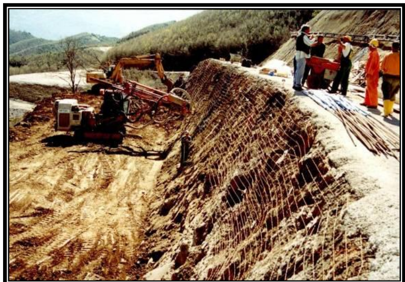
Διαμόρφωση Καθρέπτη Μετώπου Εξόδου
