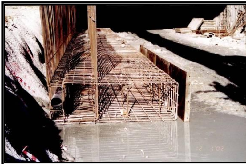
Σιδηρός Οπλισμός Θεμελίων - Invert
