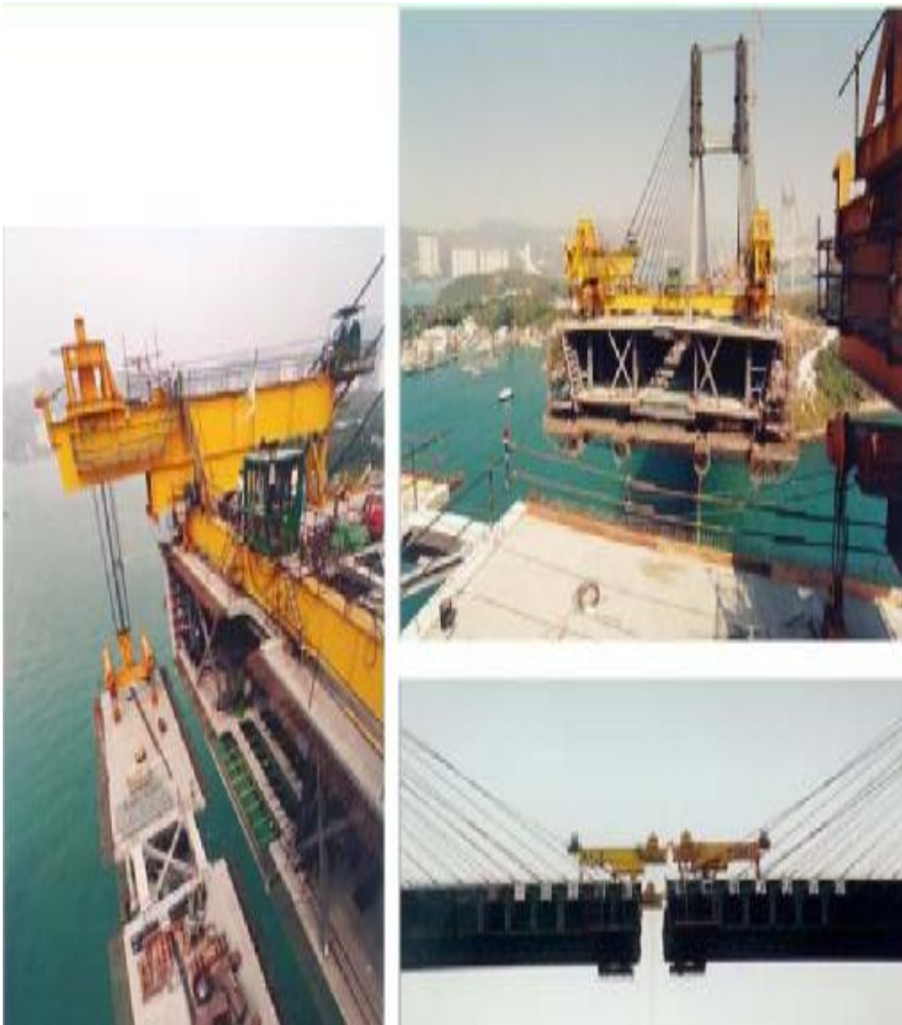
Ανέλκυση και ανέγερση της διαμορφωμένης γέφυρας
