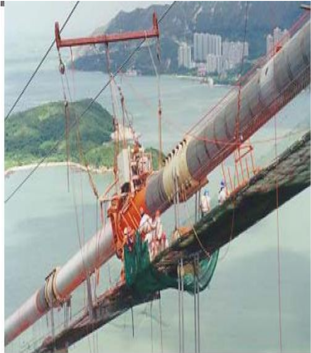
Συμπύκνωση και τελική περίσφιξη του κύριου καλωδίου
