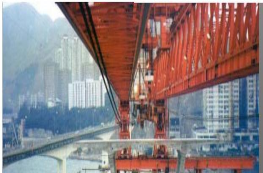
Τμήμα οδογέφυρας πριν τη διέλευση του καναλιού Rambler (με τη χρήση προκατασκευασμένων box section αντί του U – ακτίνες)
