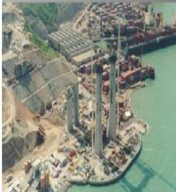
Κατασκευή του πύργου της γέφυρας
