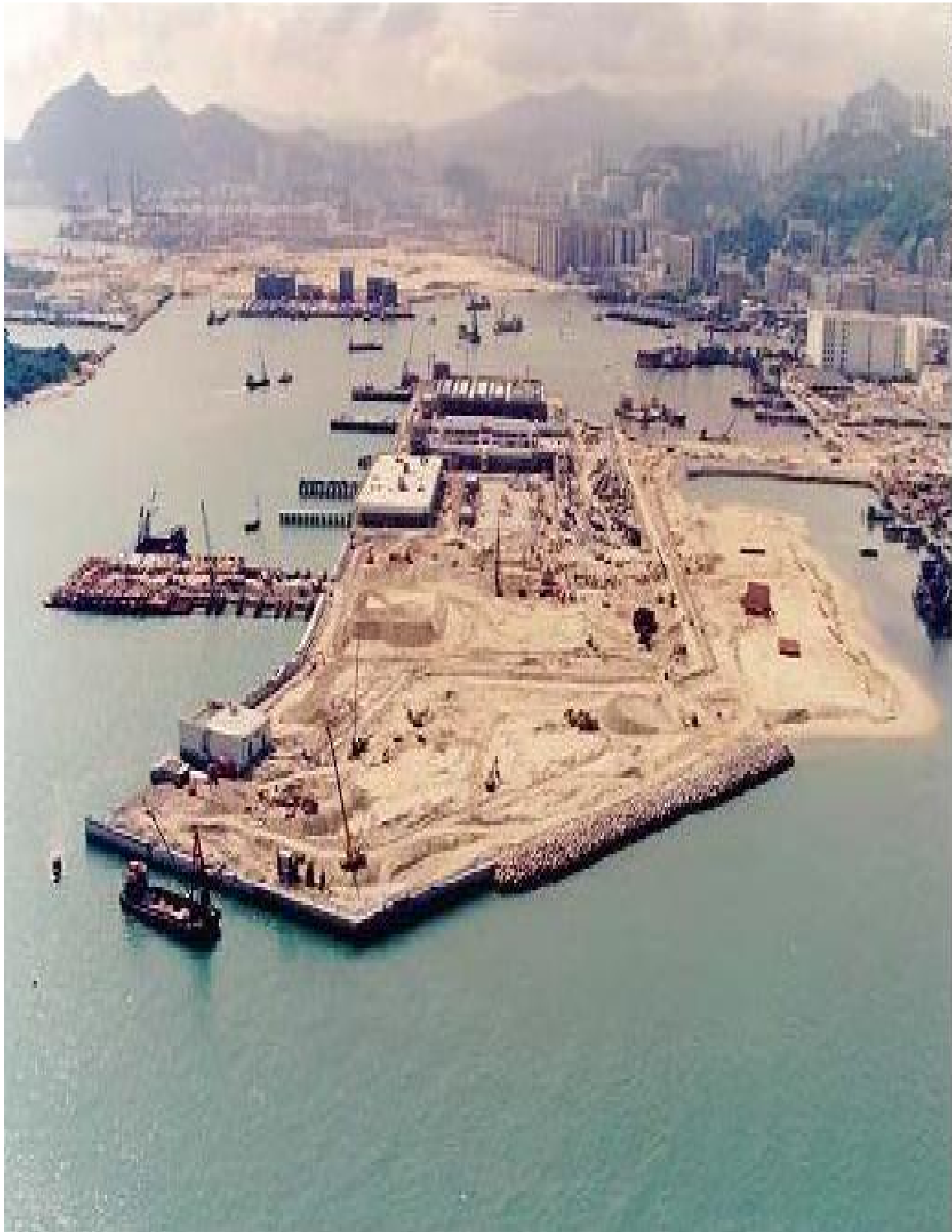
Εγγειοβελτιωτικά έργα στο Sha Wan
