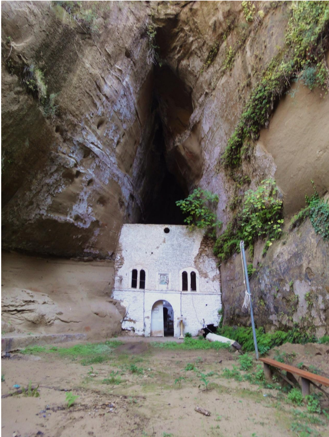
Εικ. 17: Το εξωτερικό της Ιεράς Μονής Ασκητή
