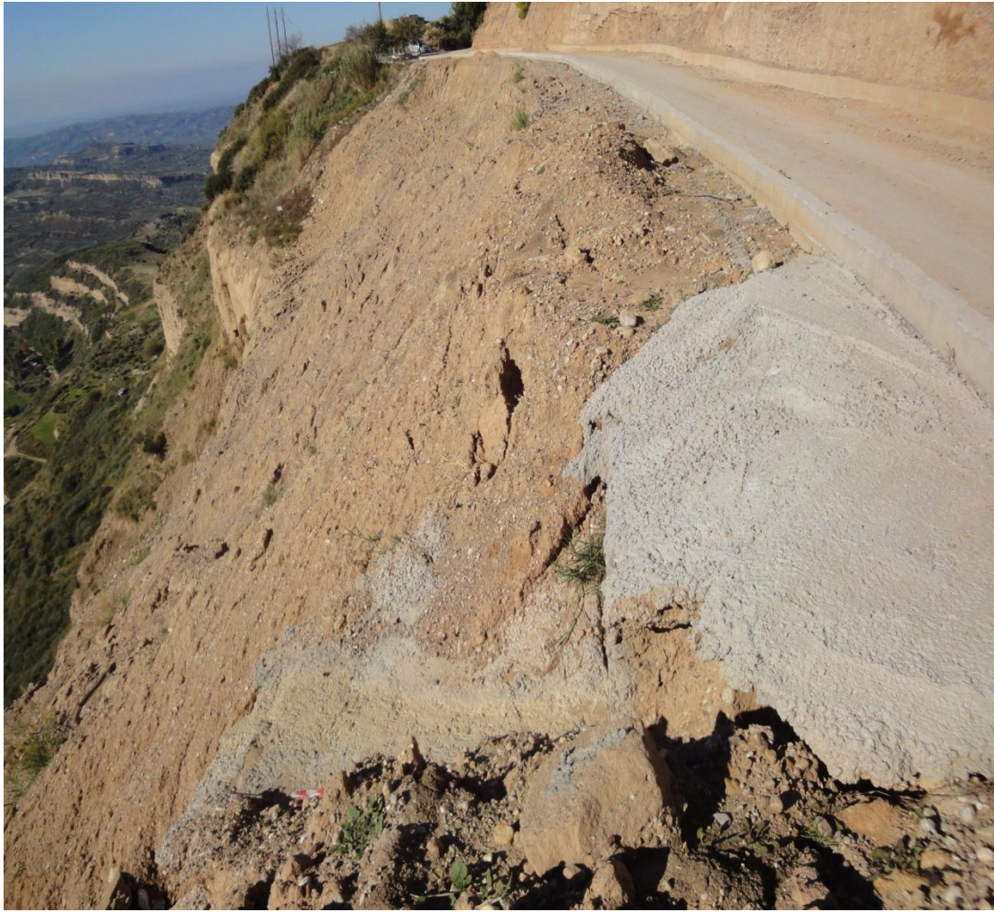
Εικ. 12: Σημείο του κατάντι πρανούς, στο οποίο είναι απαραίτητη η τοποθέτηση συρματοκιβωτίων
