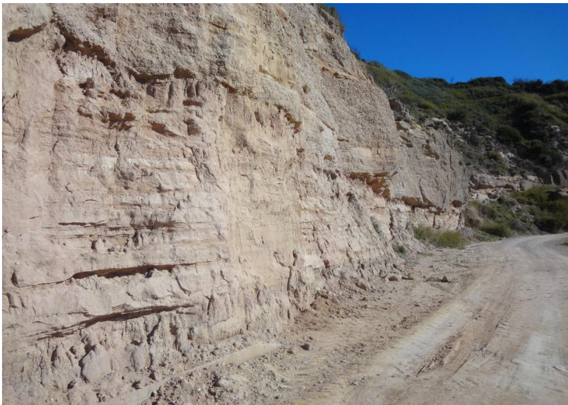
Εικ. 9: Σημείο του ανάντι πρανούς που χρήζει εκσκαφής και διαμορφώσεως
