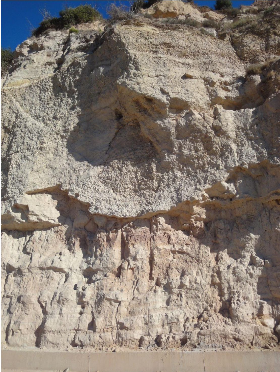
Εικ. 5: Σημείο του ανάντι πρανούς που χρήζει εκσκαφής και διαμορφώσεως
