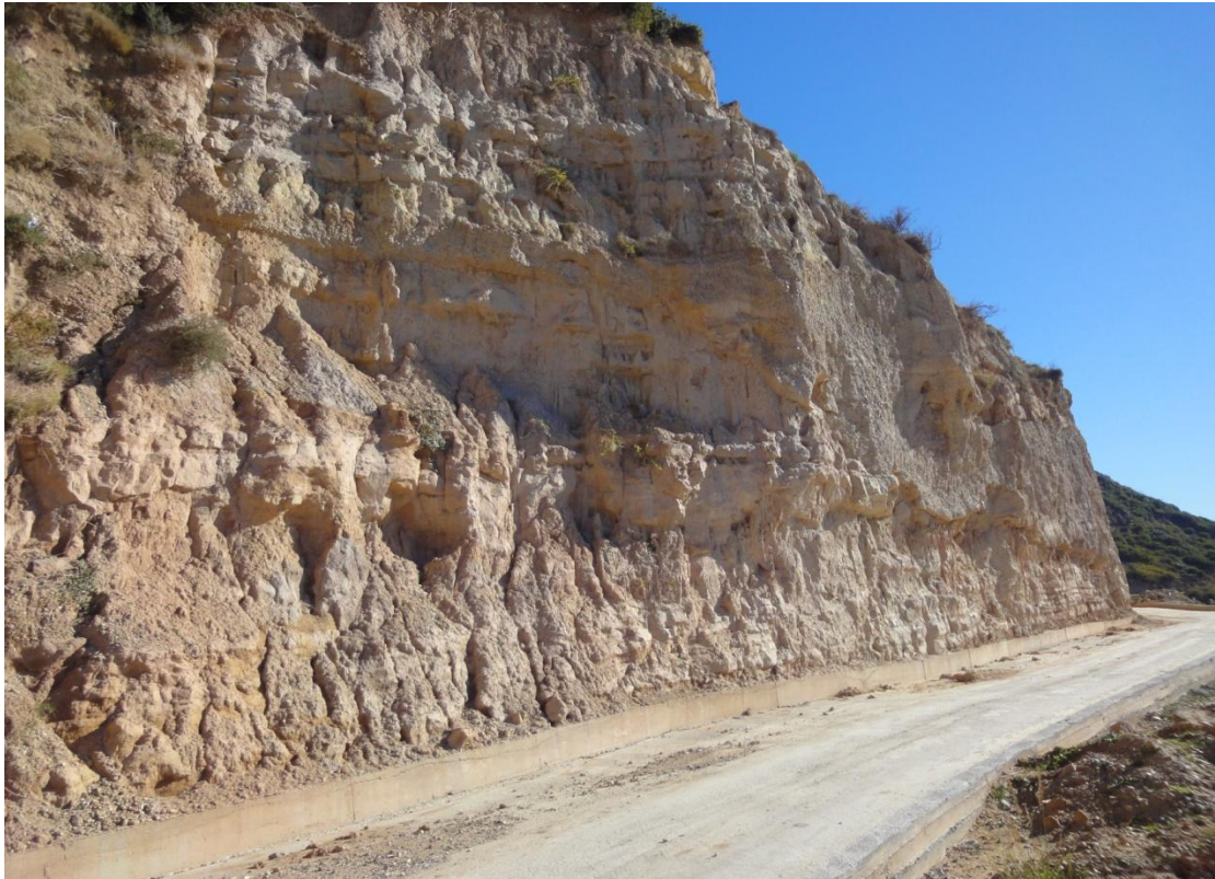
Εικ. 8: Σημείο του ανάντι πρανούς που χρήζει εκσκαφής και διαμορφώσεως
