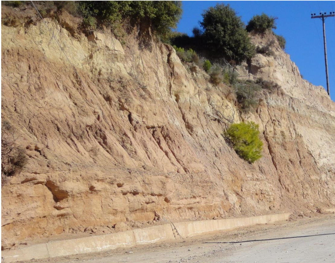
Εικ. 3: Σημείο του ανάντι πρανούς που χρήζει εκσκαφής και διαμορφώσεως
