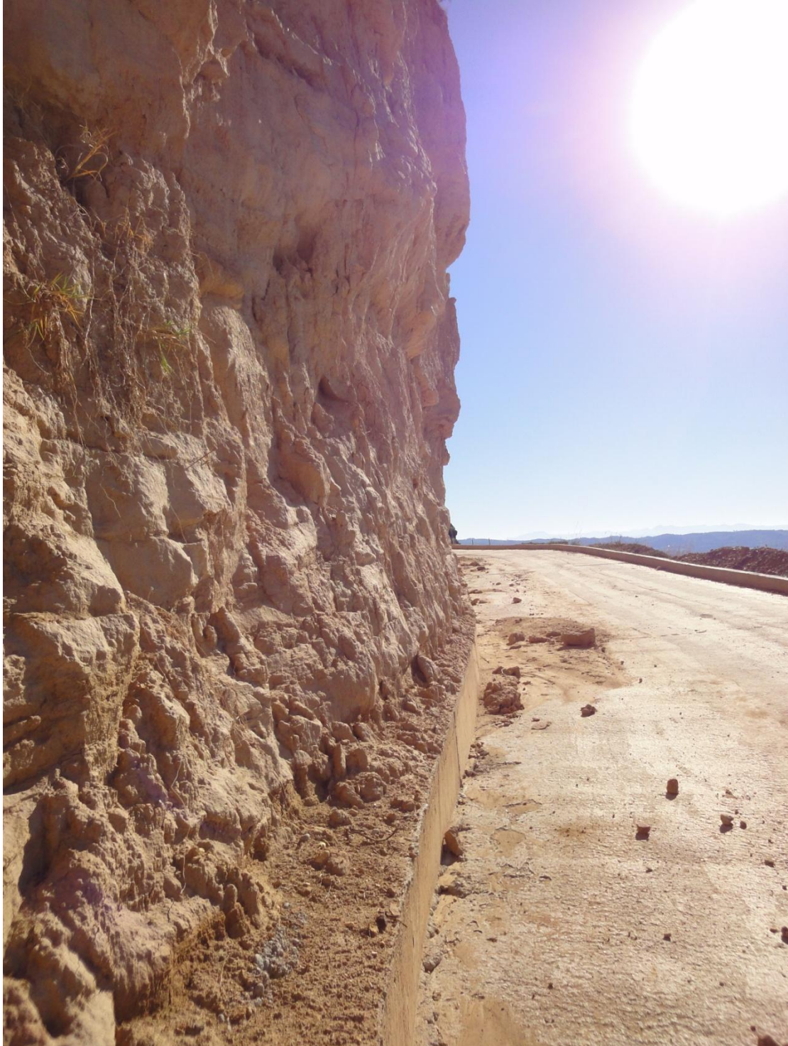
Εικ. 6: Σημείο του ανάντι πρανούς που χρήζει εκσκαφής και διαμορφώσεως
