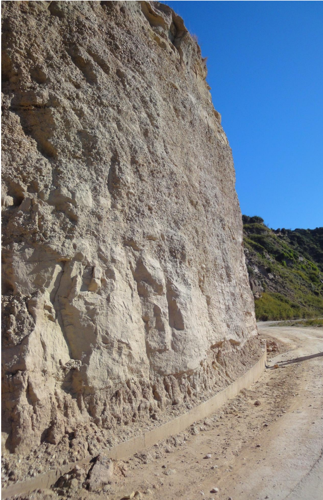
Εικ. 7: Σημείο του ανάντι πρανούς που χρήζει εκσκαφής και διαμορφώσεως
