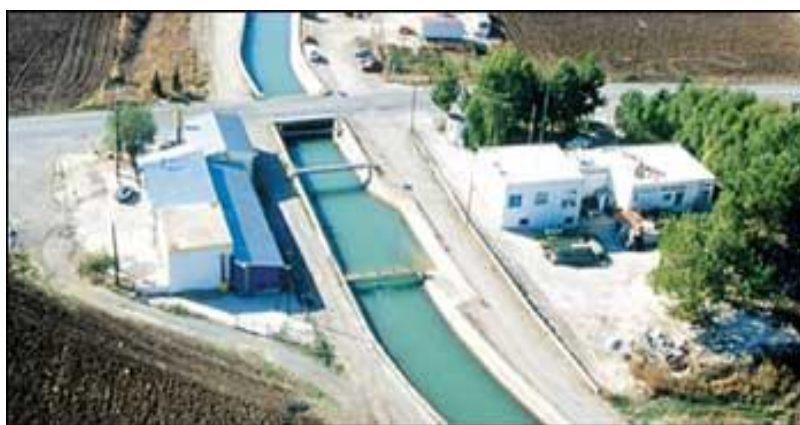
Εικόνα 3.6β Ενωτικό υδραγωγείο Μόρνου-Υλίκης.
