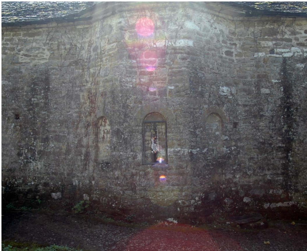
4. Μέσο Νότιας όψης ναού
