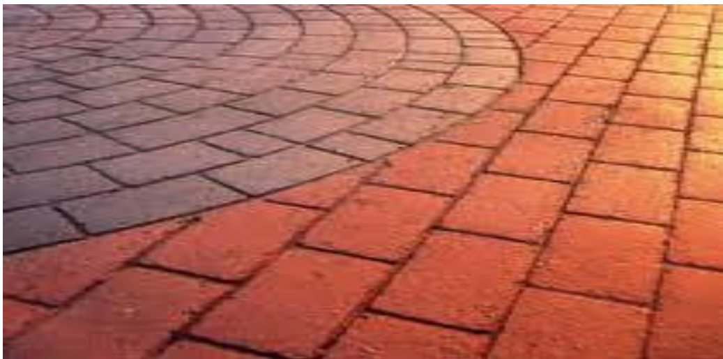
Εικόνα 4.4: Εφαρμογή streetprint σε πεζοδρόμιο
