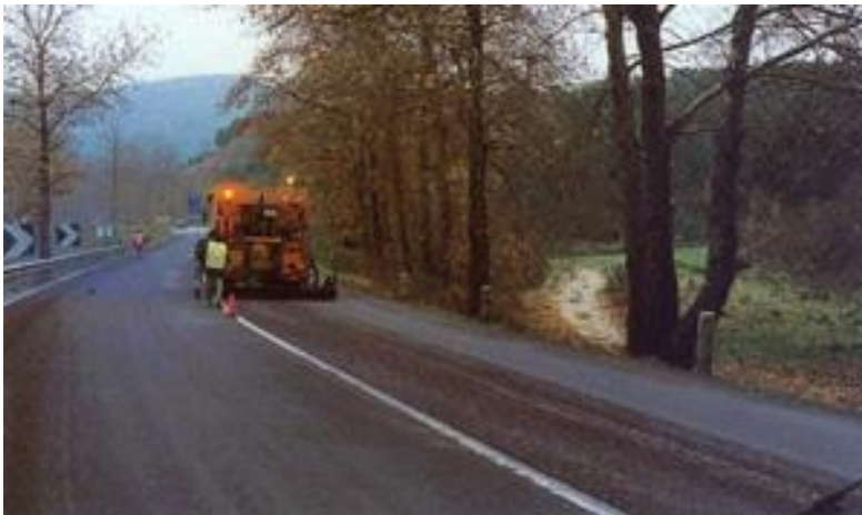
Εικόνα 3.11: Διάστρωση μιας λωρίδας κυκλοφορίας
