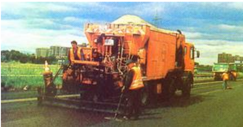
Εικόνα 3.9: Επίστρωση slurry seal πάνω στο παλιό οδόστρωμα
