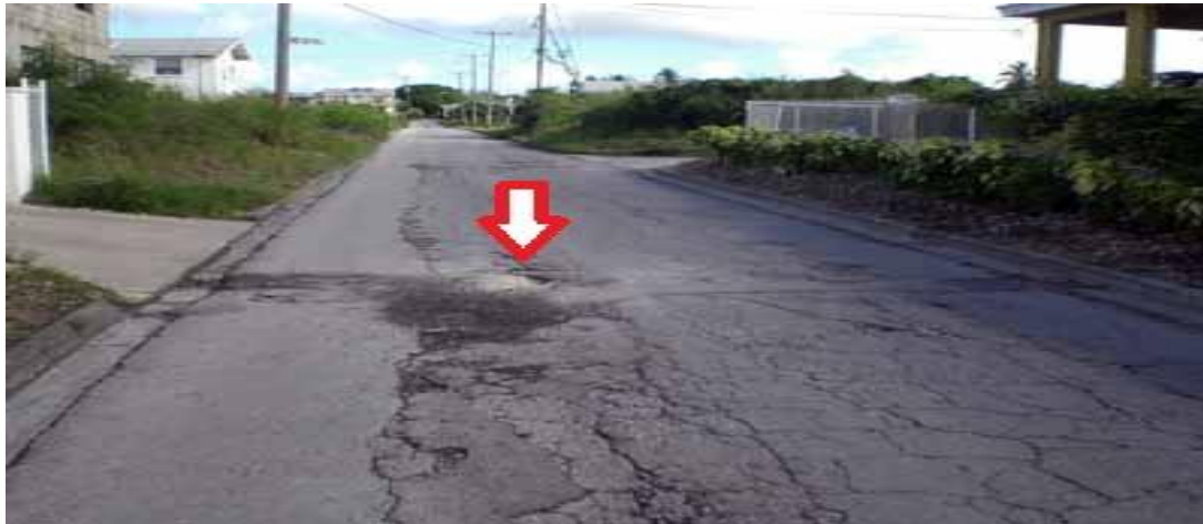
Εικόνα 2.3: Χαρακτηριστικό βύθισμα της επιφάνειας κύλισης
