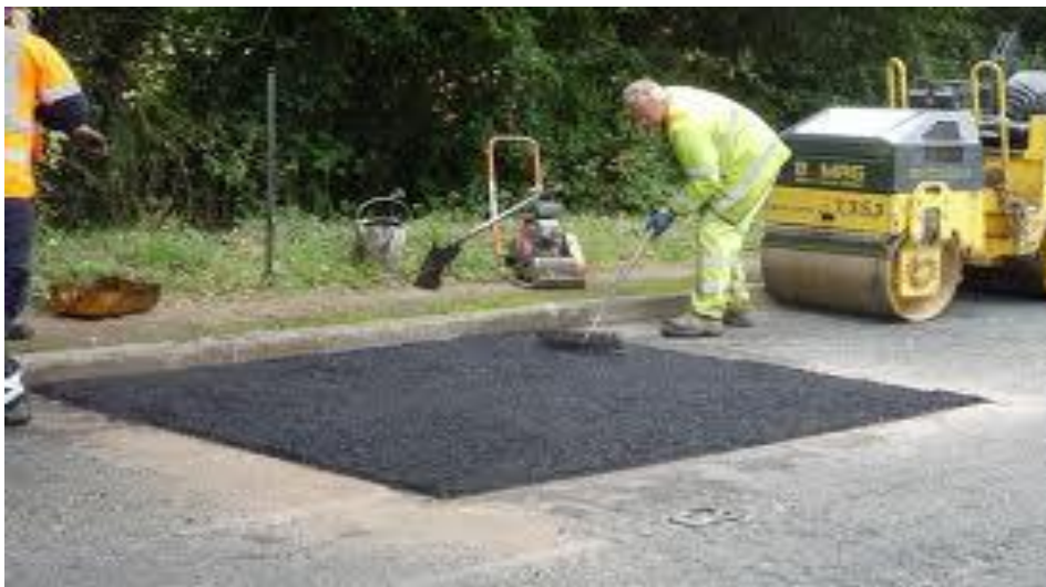
Εικόνα 4.5: Πλήρωση λακκούβας με τη μέθοδο Patchers
