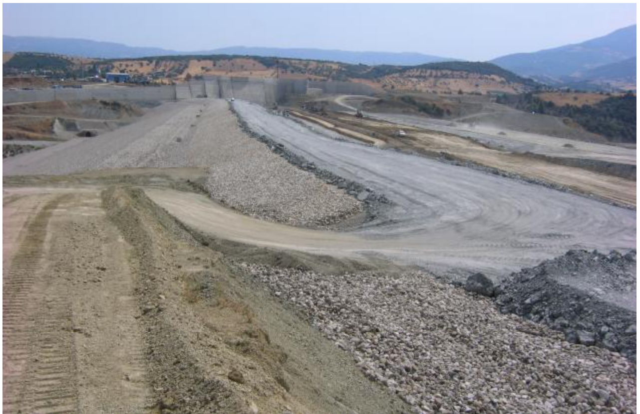
Εικόνα 33: Γενική όψη Φράγματος
