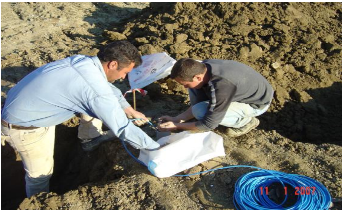
Εικόνα 27: Πιεζόμετρο-σκάμμα
