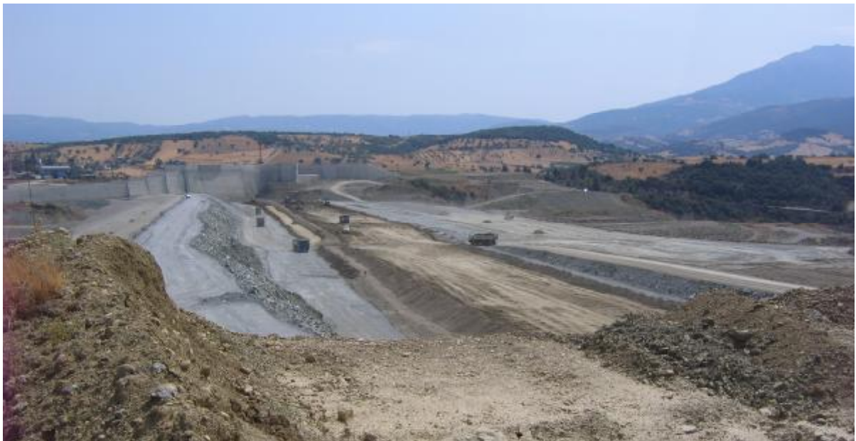
Εικόνα 35: Τμηματική Κατασκευή Ανάντη Σώματος Στήριξης
