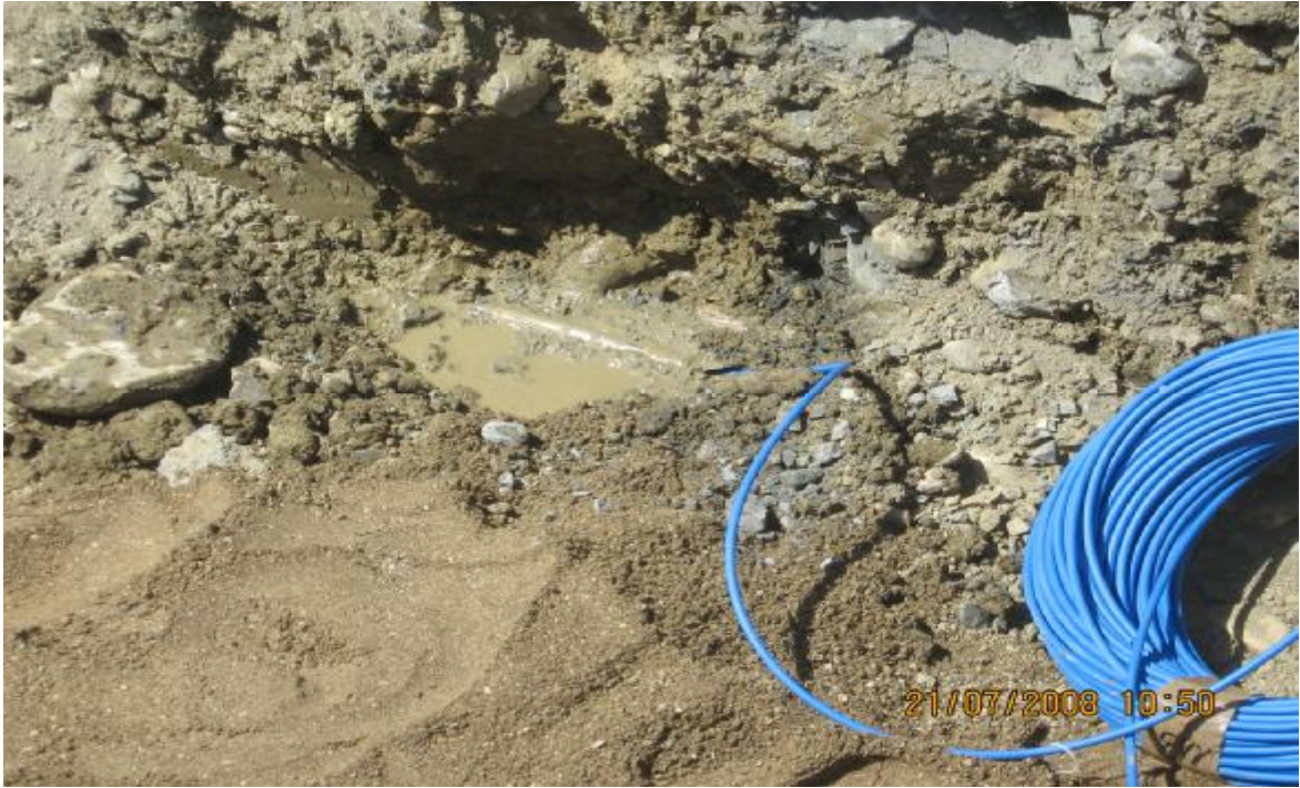
Εικόνα 13: Πιεζομετρικά Κύτταρα
