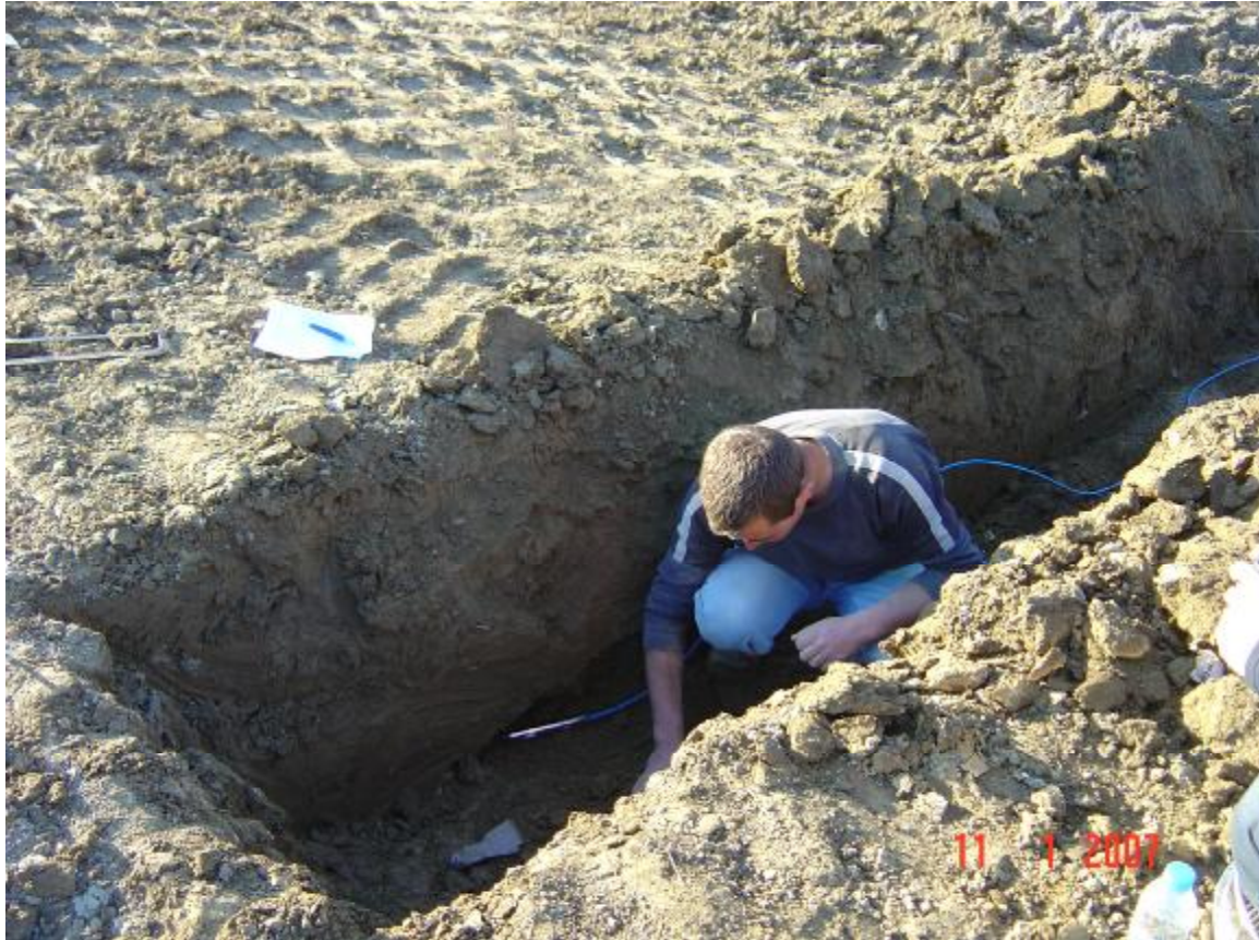
Εικόνα 28: τοποθέτηση Πιεζόμετρου
