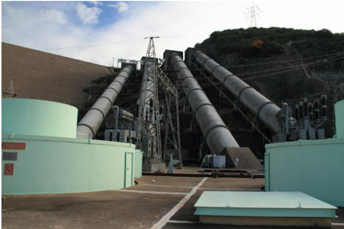
Κατασκευή αγωγών πτώσης
