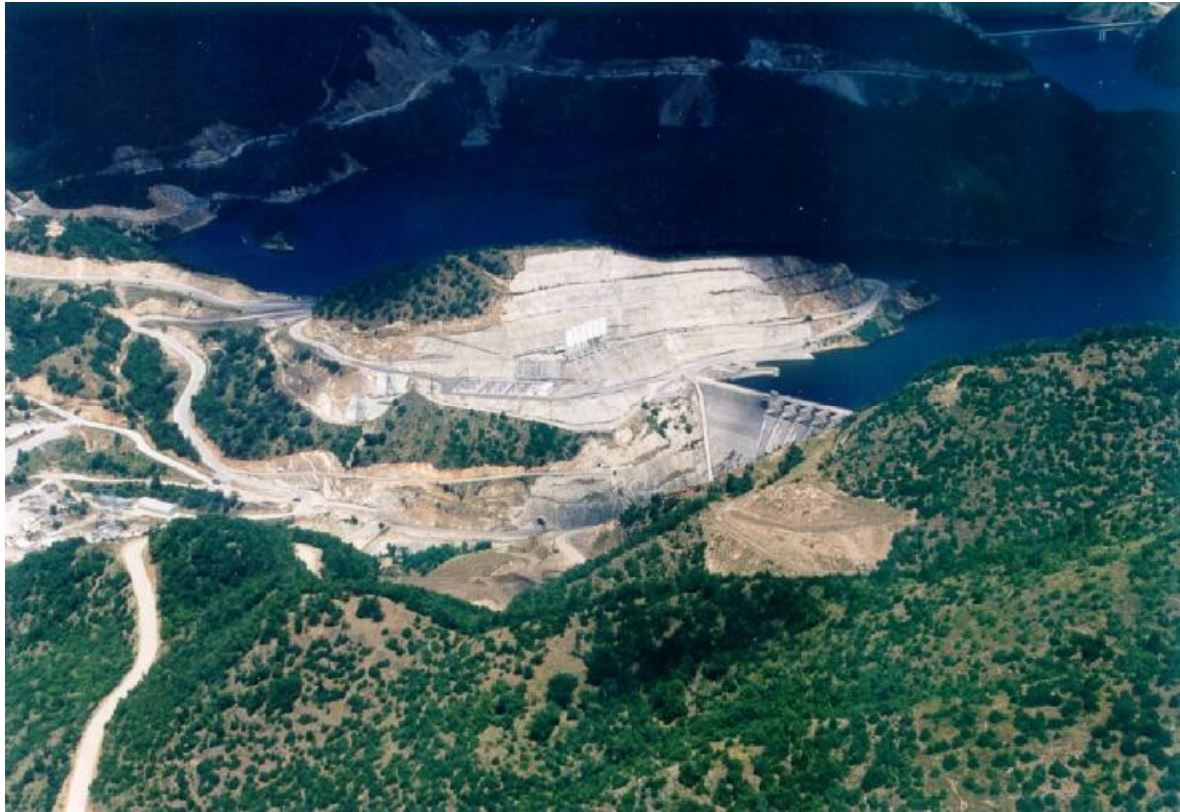
Εικόνα 9: υ/η ταμιευτήρας Πλατανόβρυσσης
