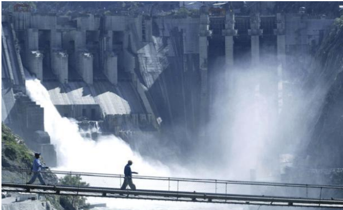
Εικόνα 7: Baglihar υ/η φράγμα
