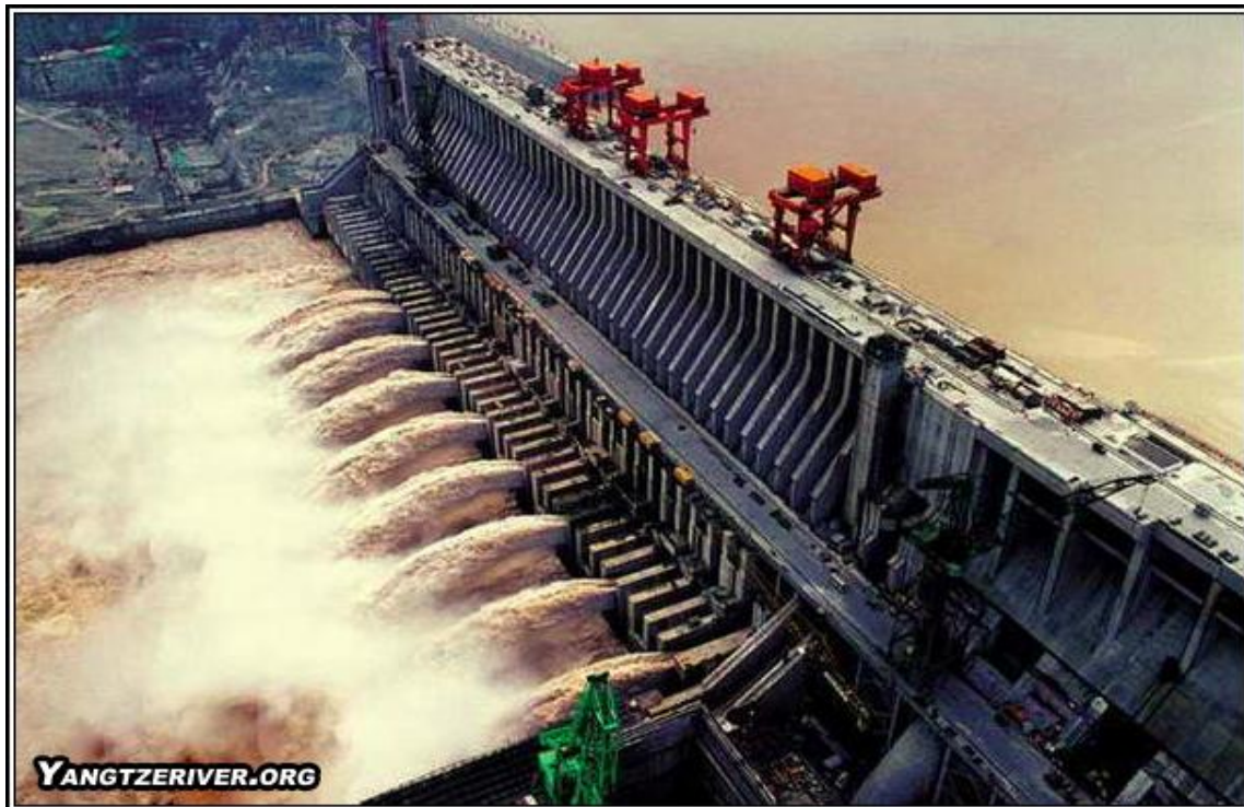
Εικόνα 12: υ/η φράγμα στον ποταμό YANGZEN στην Κίνα
