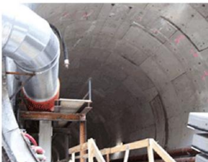
Εικόνα 3: Τελική επένδυση σήραγγας με προκατασκευασμένα στοιχεία οπλισμένου σκυροδέματος.
