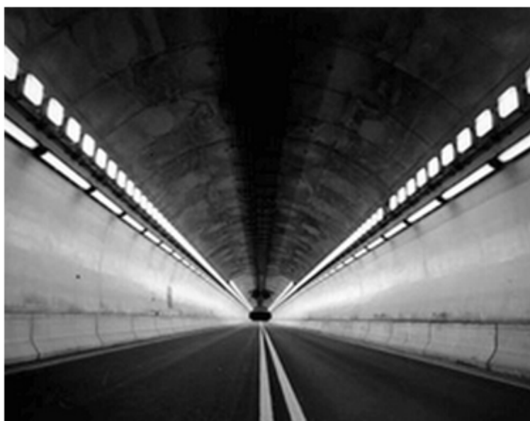
Εικόνα 8: Τελική επένδυση σήραγγας με εκτοξευόμενο σκυρόδεμα στη σήραγγα στο Lehigh της Pennsylvania.
