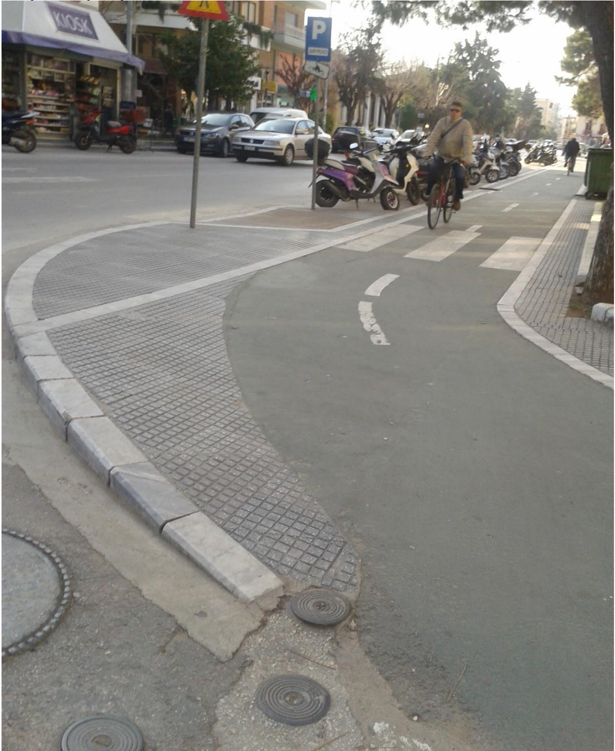
Φωτογραφία 5.1: Επέκταση πεζοδρομίου για την διαμόρφωση αμφίδρομης ποδηλατολωρίδας
