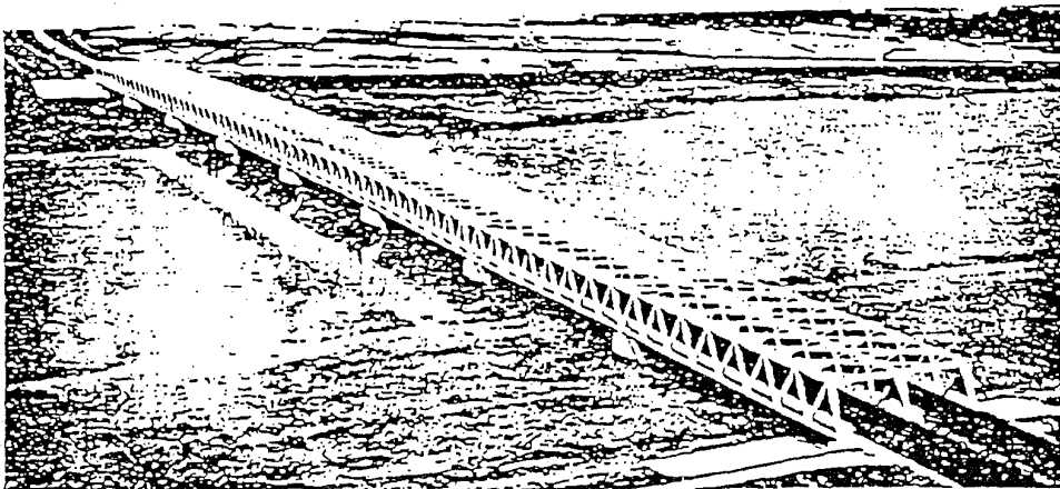
Σχ.2 Δικτυωτή γέφυρα Tonogawa (α) (Ιαπωνία 1972)
