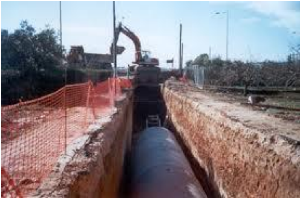
Εικόνα 1-3: Τοποθέτηση σωληνωτού οχετού κατά τη φάση της κατασκευής. (Διαδίκτυο 2012) ( http://www.larissanet.gr/el/june2012/thessaly_region/27744/Επιβλεψη-Αγοραστού-σε-έργα-της-Αν-Αργιθέας.htm )
