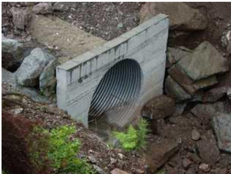
Εικόνα 1-4: Σωληνωτός μετά την κατασκευή κατά τη φάση λειτουργίας του έργου. (Διαδίκτυο 2012) ( http://www.larissanet.gr/el/june2012/thessaly_region/27744/Επιβλεψη-Αγοραστού-σε-έργα-της-Αν-Αργιθέας.htm )
