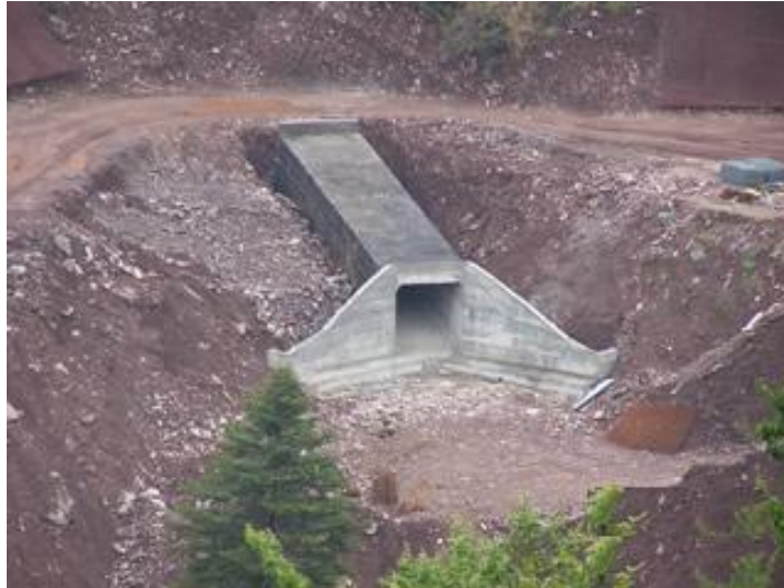
Εικόνα 1-12: Πτερυγότοιχοι σε κιβωτοειδή οχετό. (Διαδίκτυο 2012) ( http://www.mandrakis.net/index.php?categoryid=12&p17_sectionid=6&p17_imageid=91 )
