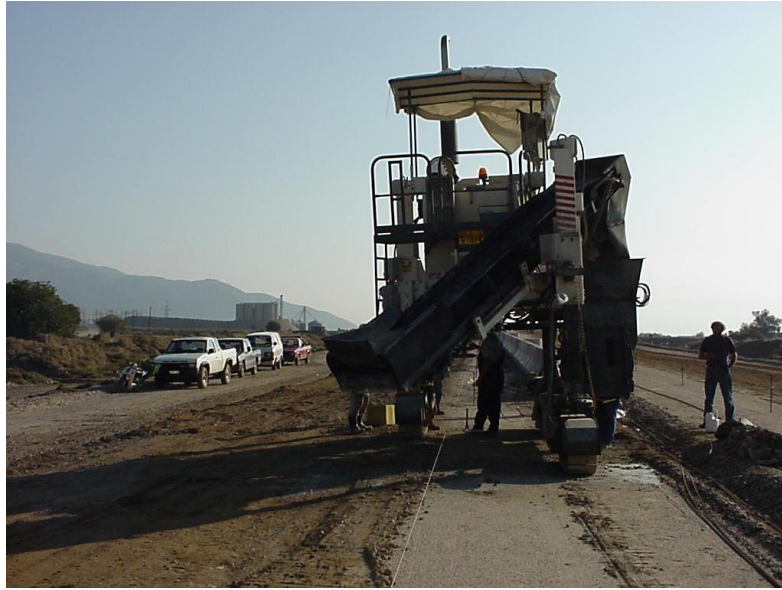
Εικόνα 6.5 : Σταθεροποίηση με ερυθρά ιλύ στη Εγνατία Οδό
