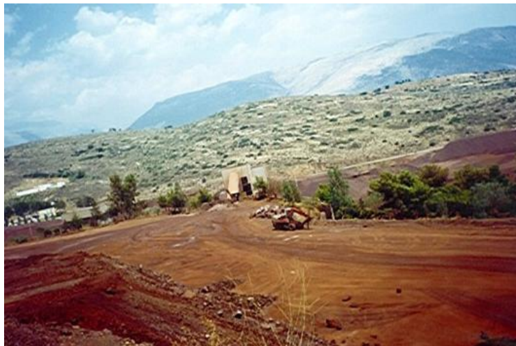
Εικόνα 6.6: Σταθεροποίηση με ερυθρά ιλύ στο τμήμα Ξάνθης – Κομοτηνής της Εγνατίας Οδού
