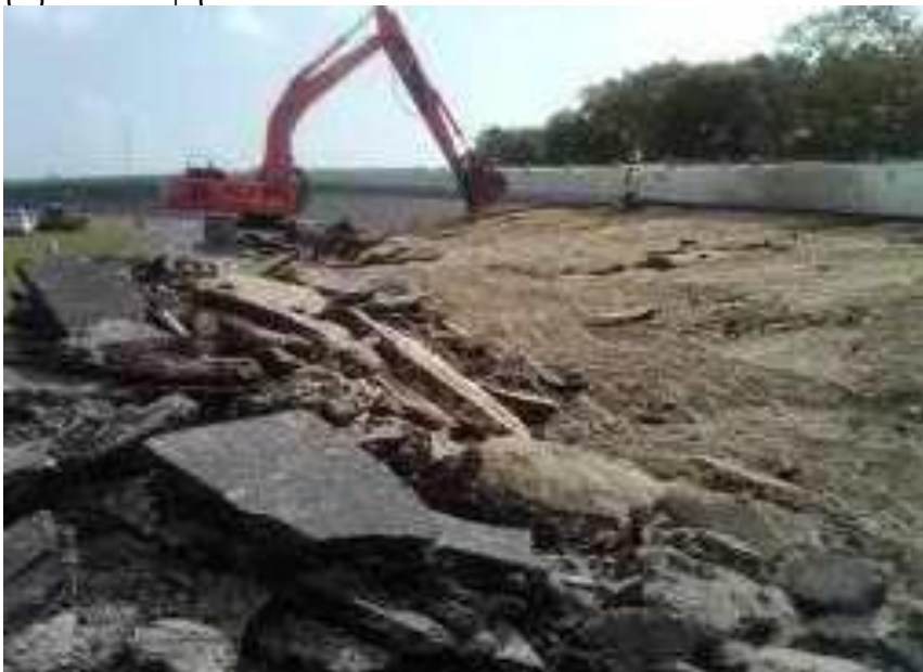
Εικόνα 79.Εργασίες ανακατασκευής οδοστρώματος
