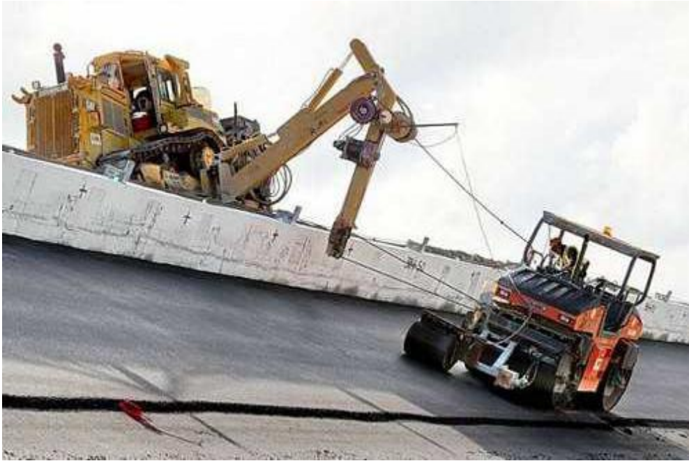
Εικόνα 86.Εργασίες ανακατασκευής οδοστρώματος
