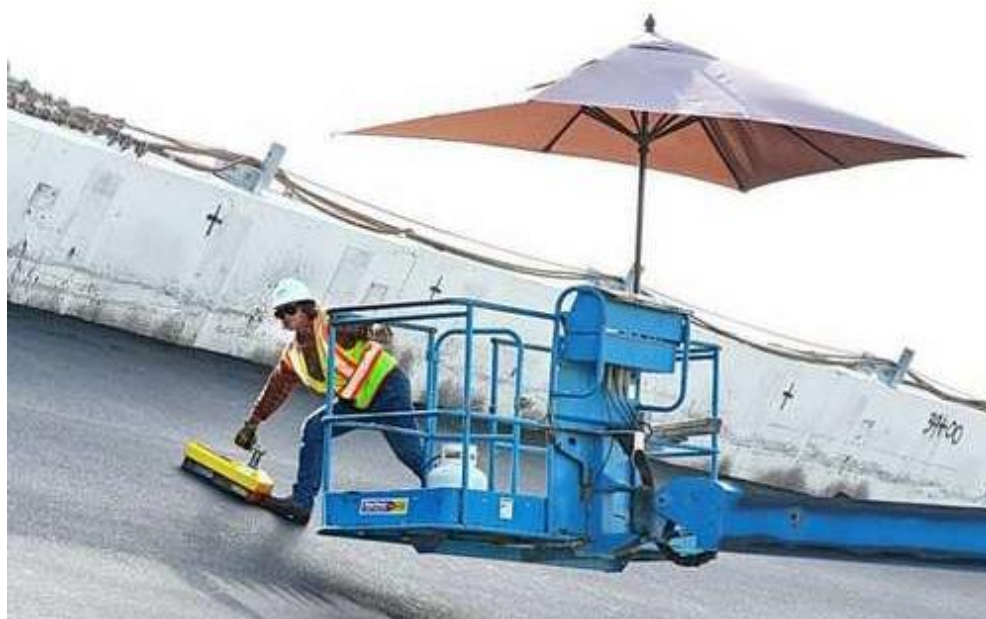
Εικόνα 83.Εργασίες ανακατασκευής οδοστρώματος
