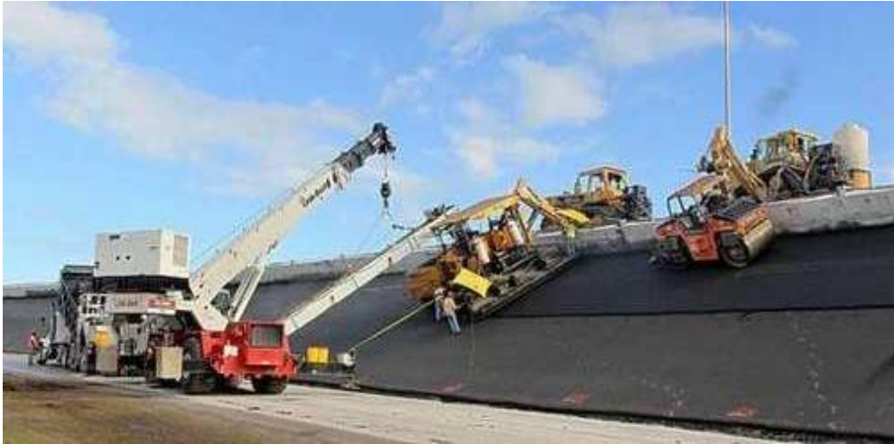
Εικόνα 88.Εργασίες ανακατασκευής οδοστρώματος
