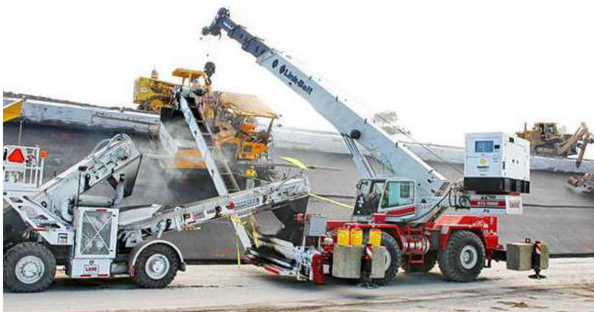
Εικόνα 82.Εργασίες ανακατασκευής οδοστρώματος
