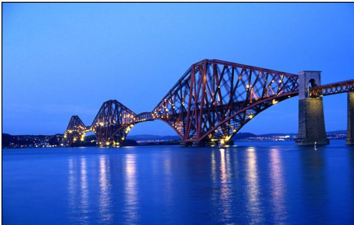
Εικόνα 4.3. «Firth of Forth Bridge» (Εδιμβούργο, Σκωτία).
