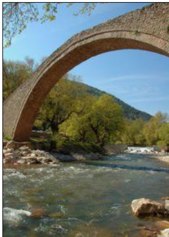
Εικόνα 8. Η Γέφυρα του «Αγίου Βησσαρίωνα» (Θεσσαλία, Ελλάδα)
