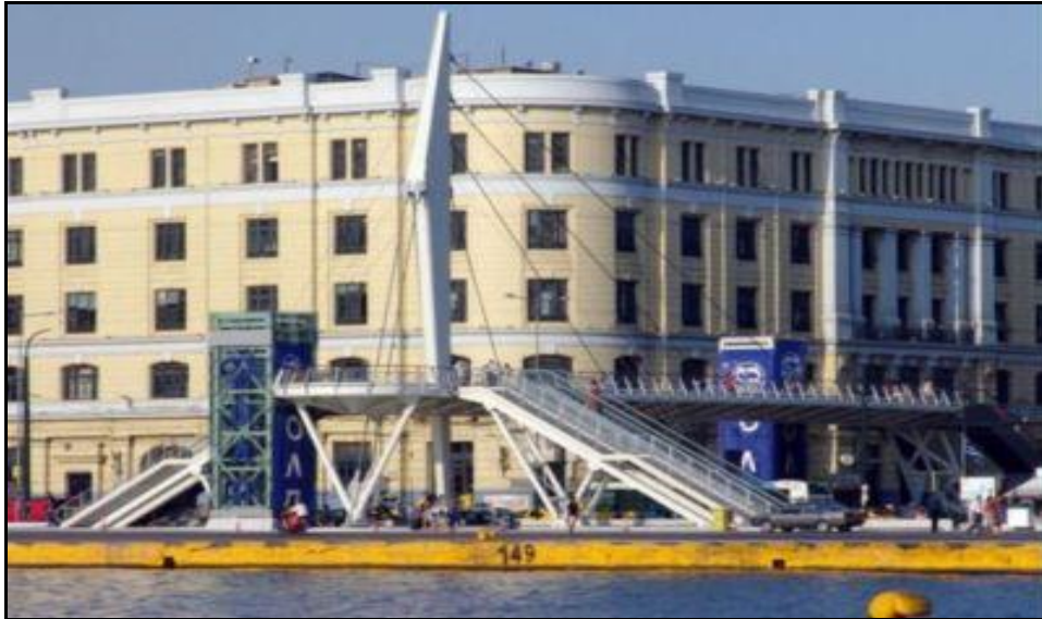
Εικόνα 5.14. «Πεζογέφυρα του Πειραιά» ( Πειραιάς, Ελλάδα)
