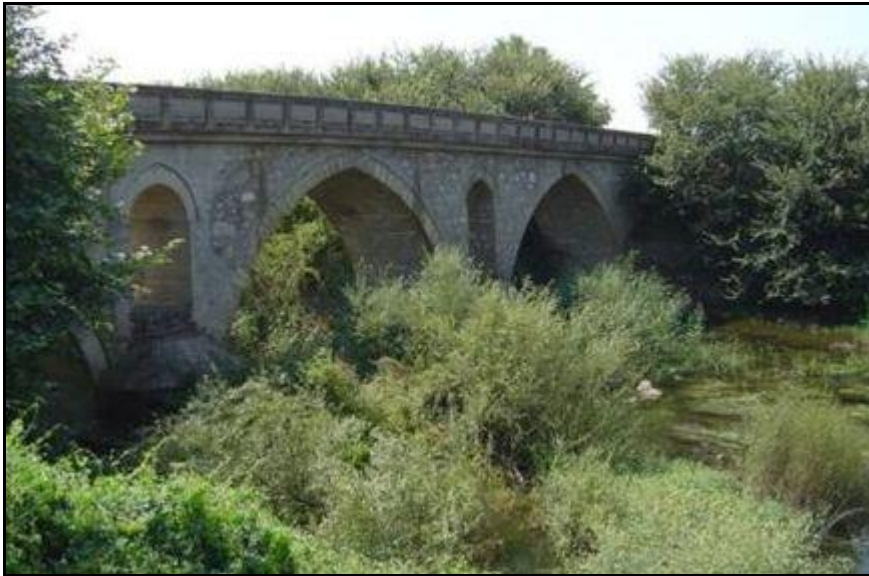
Εικόνα 5. Η Γέφυρα «Μοσχολουρίου» (Θεσσαλία, Ελλάδα)
