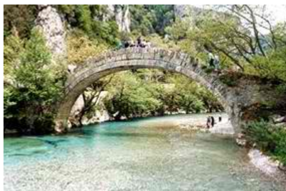
Εικόνα 80. Το γεφύρι της Πλάκας
