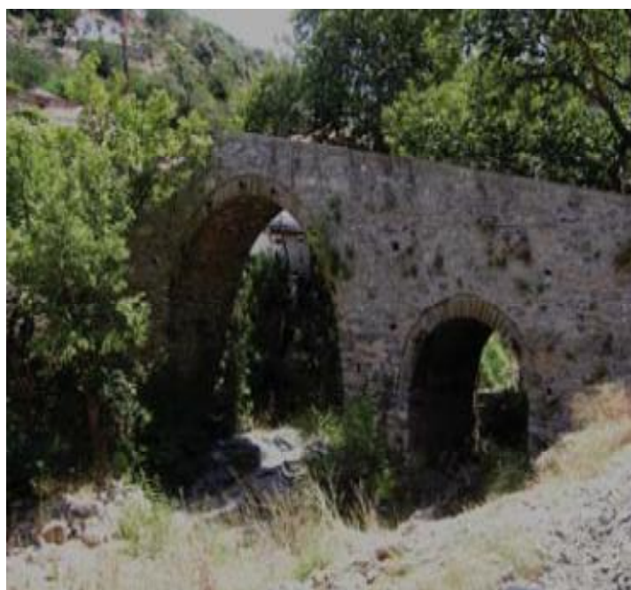
Εικόνα 34.Κάτω Κερασιά (1886). Δίτοξο, εντός του οικισμού
