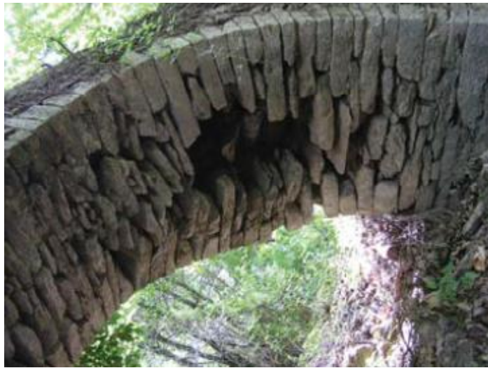
Εικόνα 29.Αγ.Λαυρέντιος, υδατογέφυρα Χατζήνη
