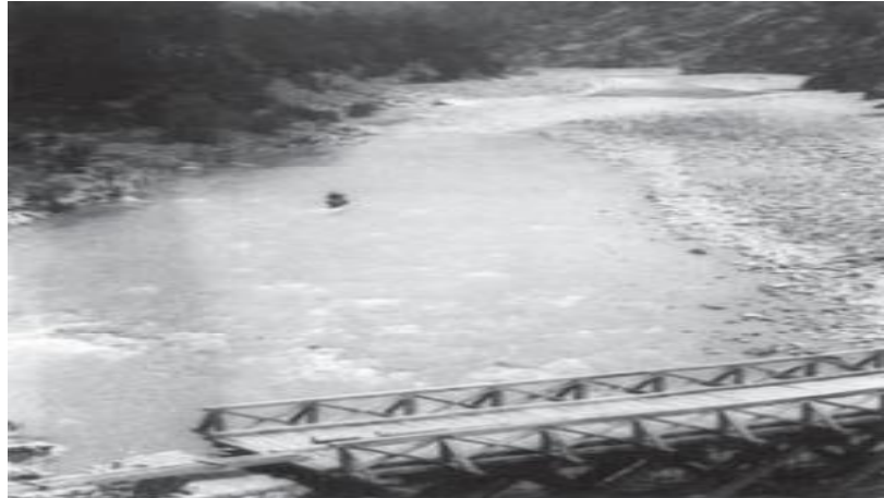
Εικόνα 11. Ξύλινη γέφυρα στον Αωό
