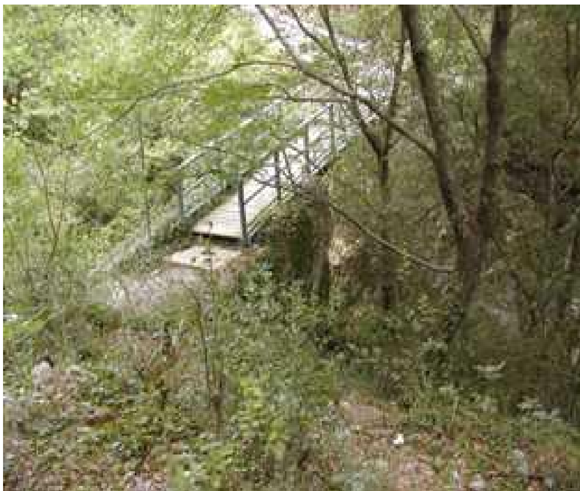
Εικόνα 58. Το γεφύρι της μονής Φιλοσόφου στον Λούσιο
