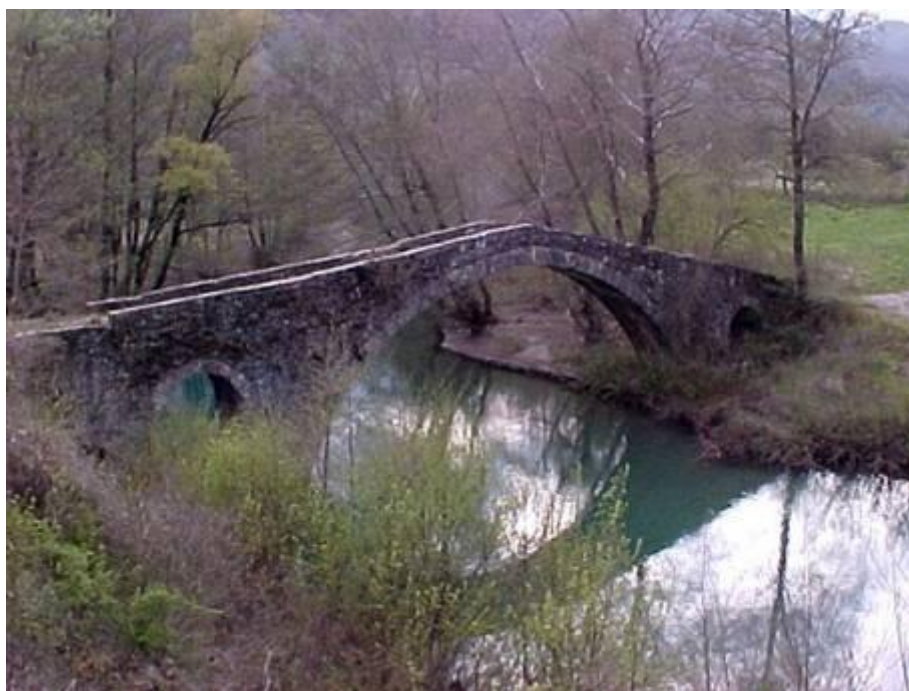
Εικόνα 76. Το γεφύρι του Καμπρέ-Αγά
