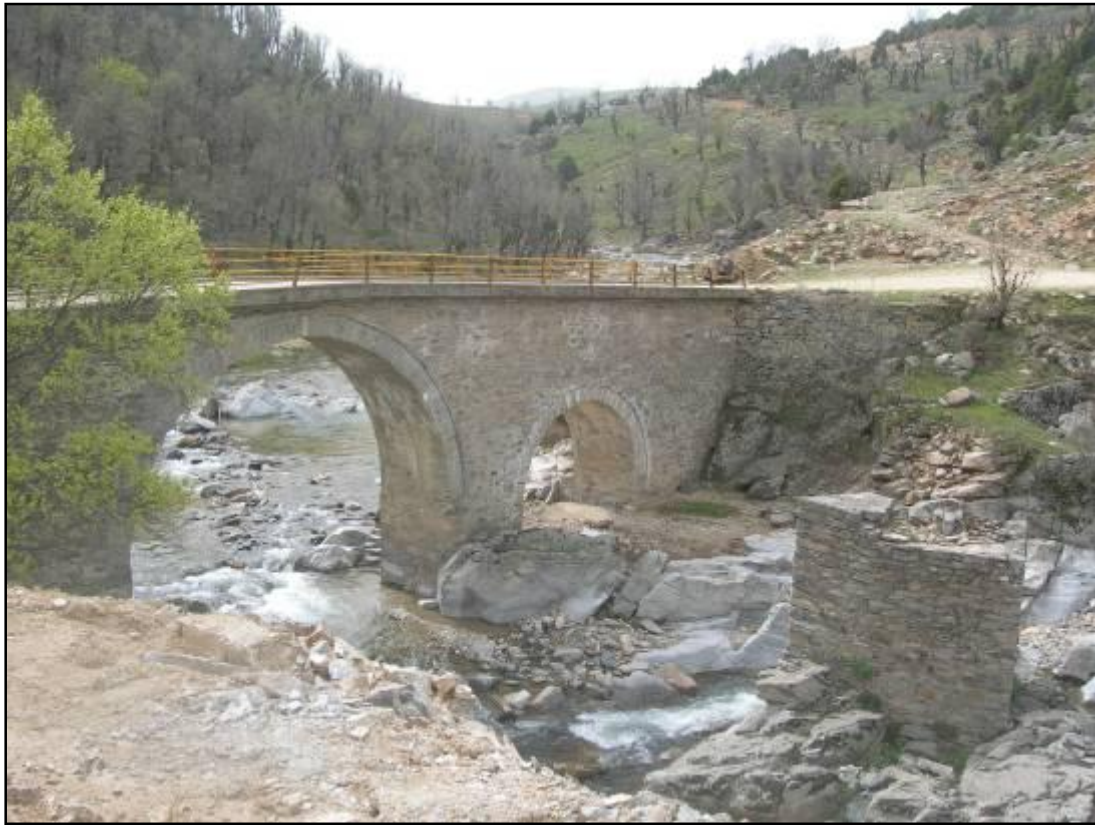
Εικόνα 94. Δίτοξο γεφύρι στον Πετρόλοφο (Ν. Έβρου) Απαραίτητο στοιχείο η τσιμεντόστρωση στο κατάστρωμά του
