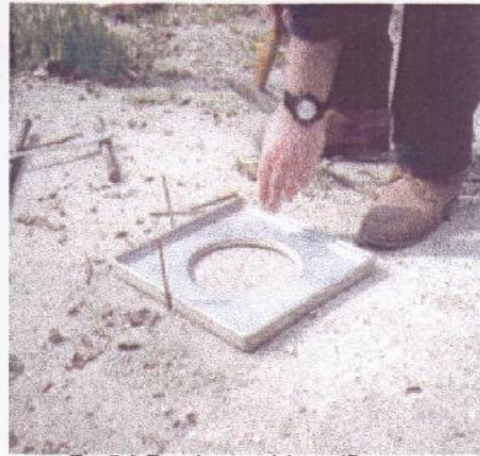
Σχ. 5.8 Στερέωση πλάκας έδρασης
