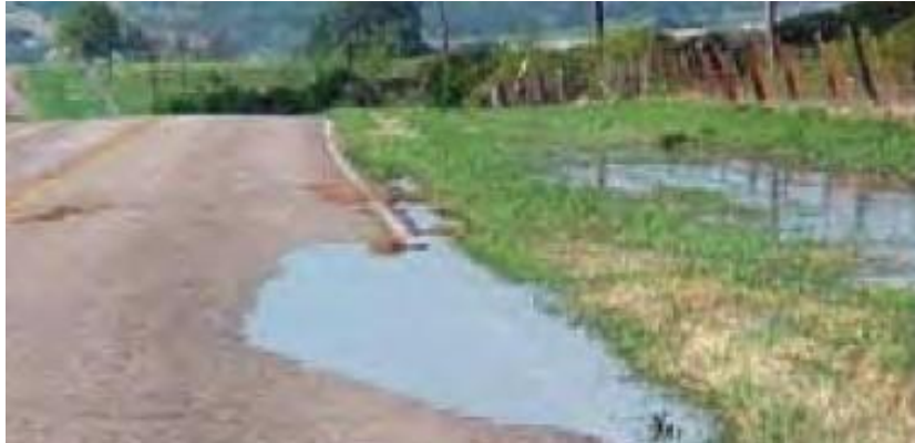
Εικόνα 3.18 «Φτωχή» αποστράγγιση
