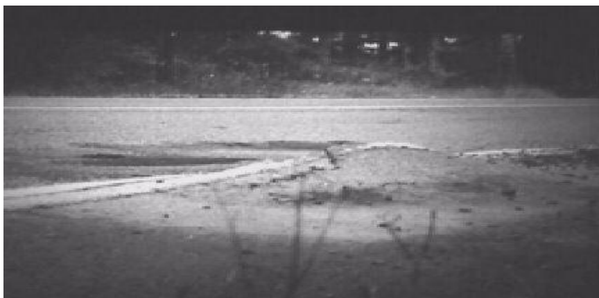
Εικόνα 3.8 Τοπική διόγκωση
