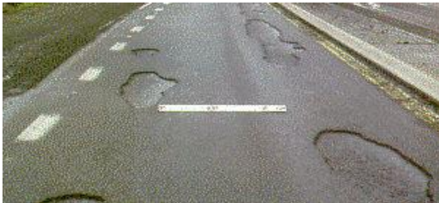
Εικόνα 3.11 Αποκόλληση κατά πλάκες
