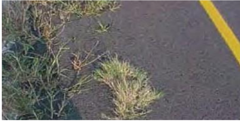
Εικόνα 3.17 Ανάπτυξη χορταριού ανάμεσα στο οδόστρωμα
