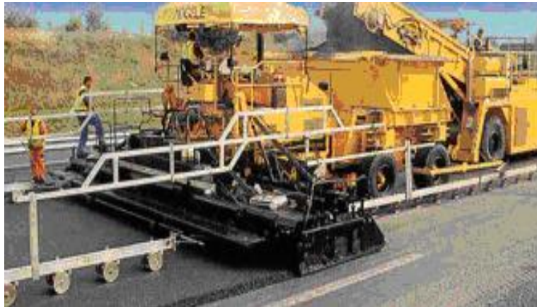
Εικόνα 1.2 Διάστρωση ασφάλτου
