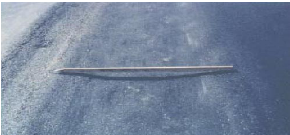
Εικόνα 3.9 Αυλακώσεις στις τροχιές των τροχών
