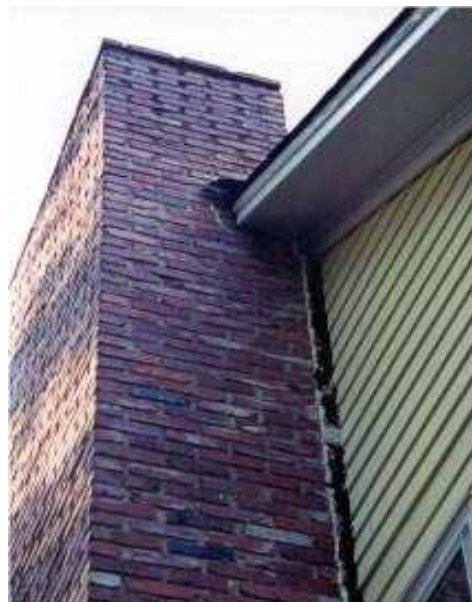
Φωτογραφία 4.2 Διαχωρισμός καμινάδας από τη στάθμη της στέγης
