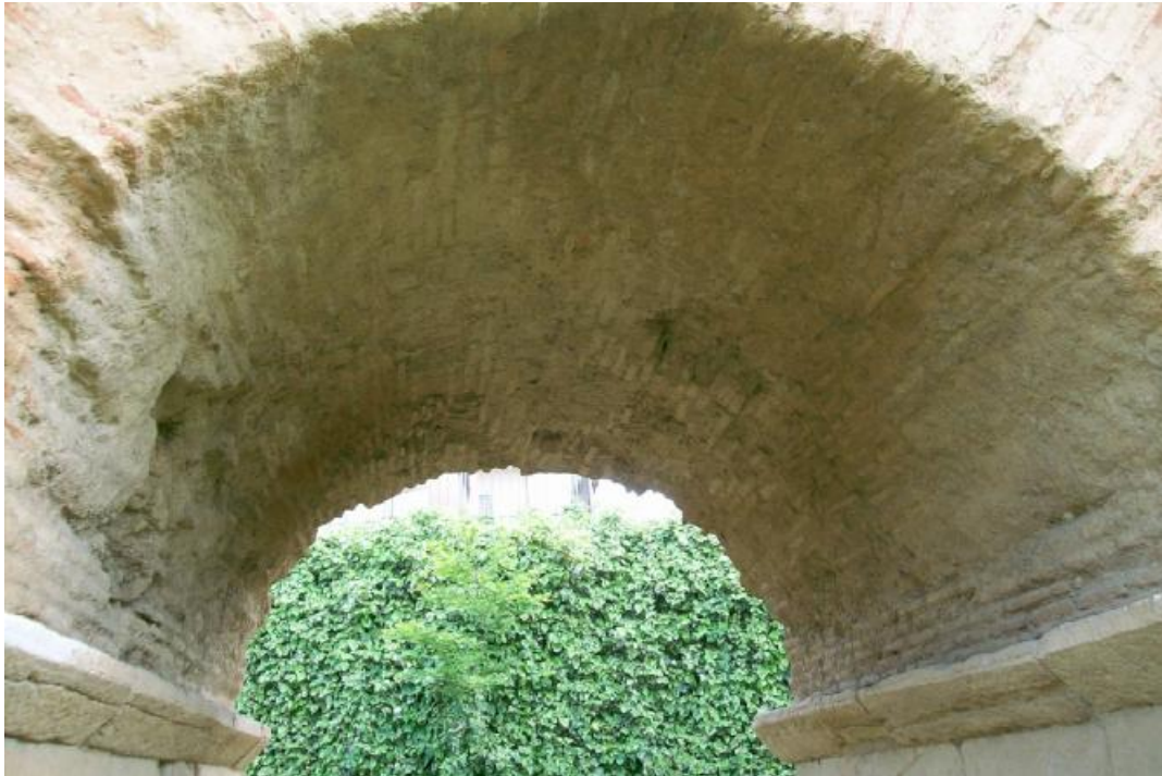
Εικόνα 52. Φωτογραφία του ανοίγματος της Γέφυρας από κάτω
