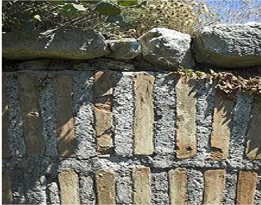
Εικόνα 23. Λεπτομέρεια τόξου: διπλή στρώση πλίνθων δεμένων με κονίαμα.
