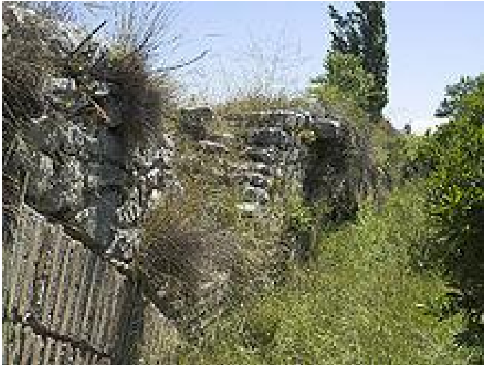
Εικόνα 22. Οι καμάρες 8 και 9, νότια πλευρά, θαμμένες από προσχώσεις ως τη βάση των αψίδων.
