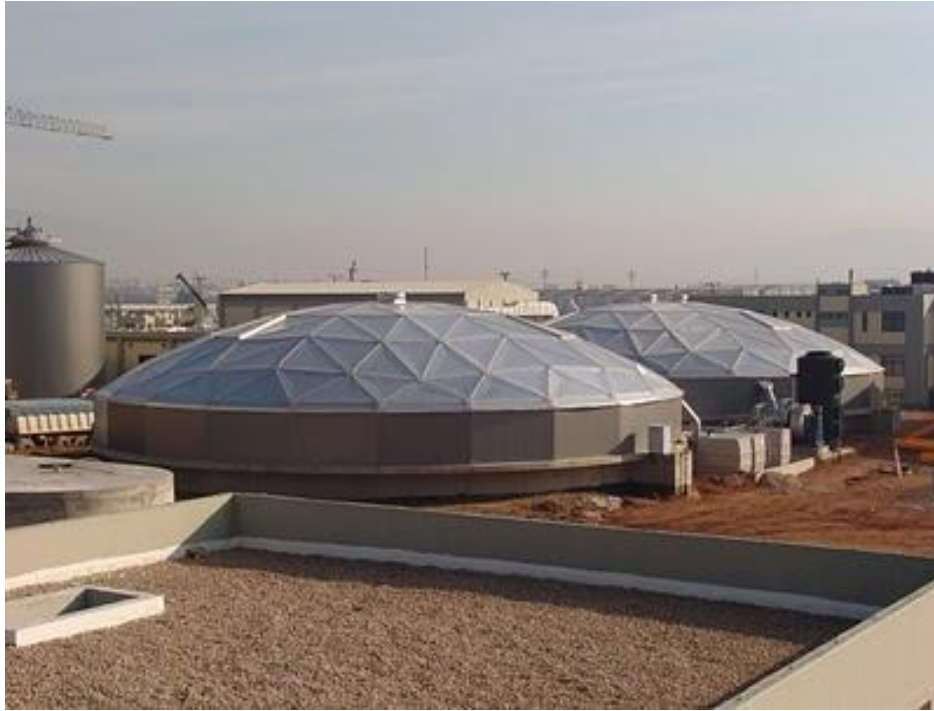
Εικόνα 9.2: Κτίριο Βιολογικού καθαρισμού Θριάσιου Πεδίου
