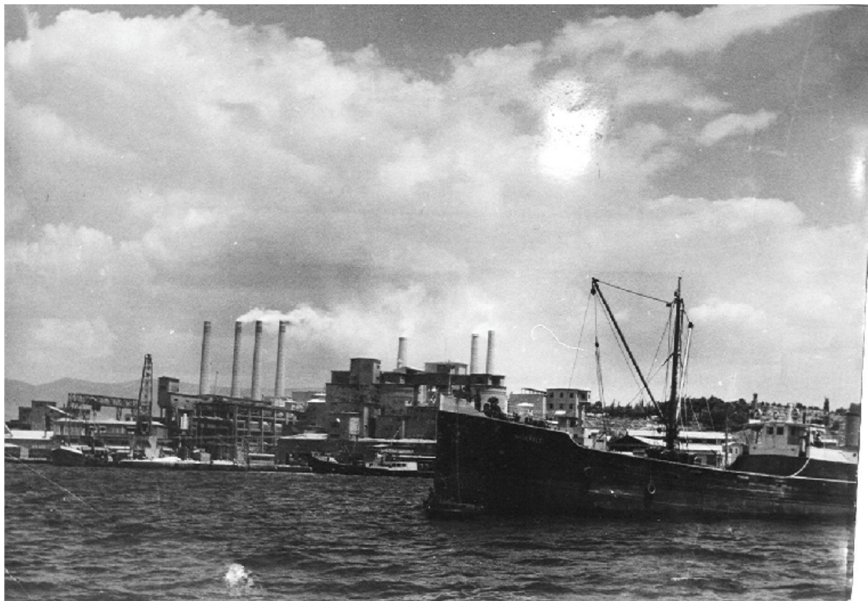
Εικόνα 1 : Άποψη του εργοστασίου σκυροδέματος TITAN
