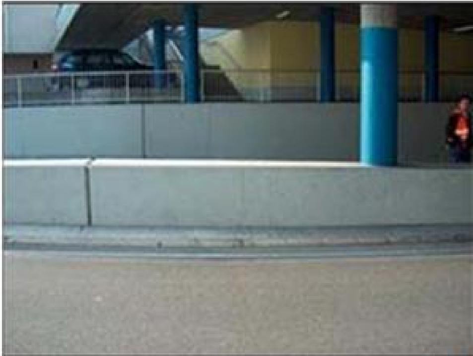
Εικόνα 23. Μετά την επισκευή με ενισχυμένο ΑΣΣ
