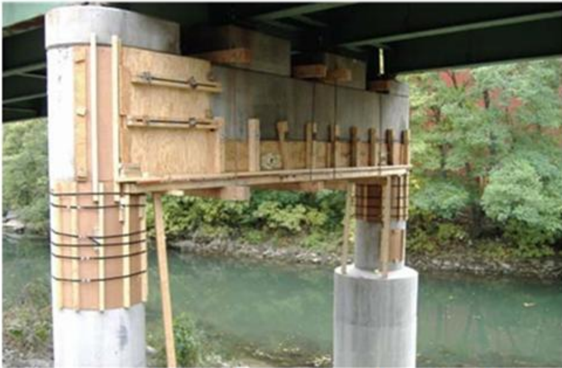
Εικόνα 26. Καλουπωμένη δοκός πριν την σκυροδέτηση με ΑΣΣ
