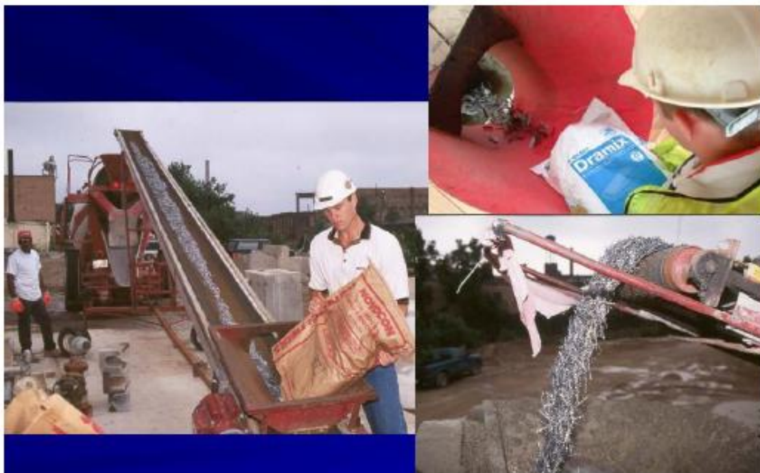
Εικόνα 41. Προσθήκη μεταλλικών ινών στο σκυρόδεμα
