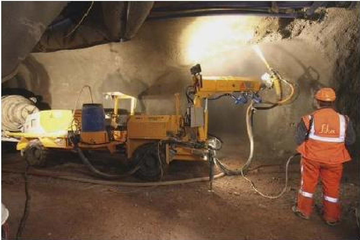
Εικόνα 36. Εκτόξευση ινοπλισμένου σκυροδέματος.
