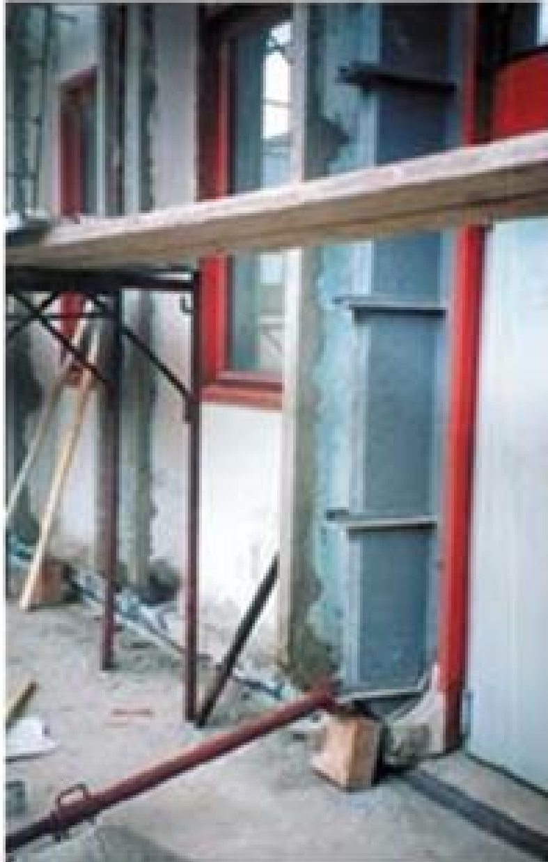
Εικόνα 25. Προκατασκευασμένο τοίχωμα μετά την αποκατάσταση
