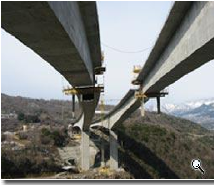
Εικόνα 1. .Γέφυρα κατασκευασμένη με σκυρόδεμα υπερυψηλής αντοχής
