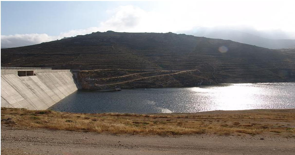
Σχήμα 2.2 Φράγμα στο Στενό Σερίφου
