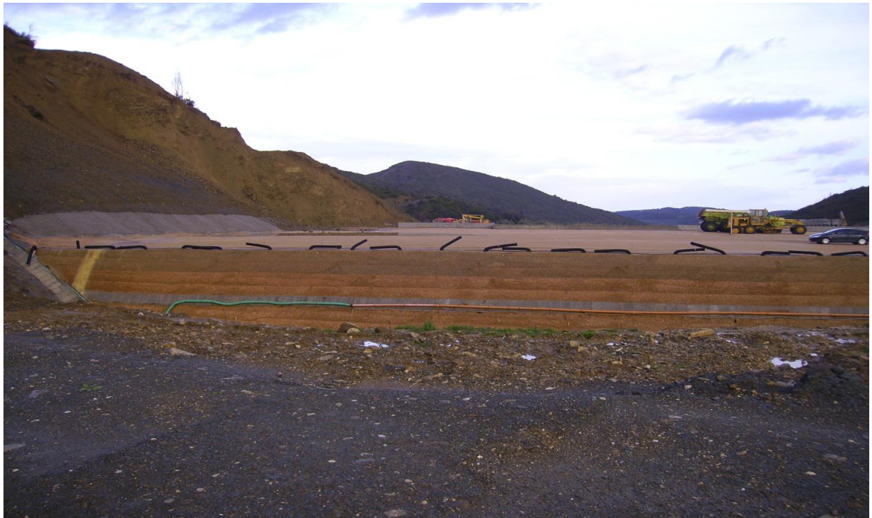
Σχήμα 1.1 Το Φράγμα Φιλιατρινού ποταμού κατά τη διάρκεια κατασκευής (Φεβρουάριος 2012)
