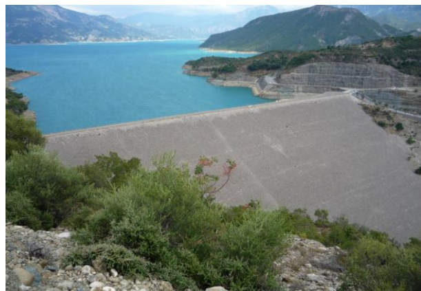
Σχήμα 1.15 Χωμάτινο φράγμα Κρεμαστών στον ποταμό Αχελώο
