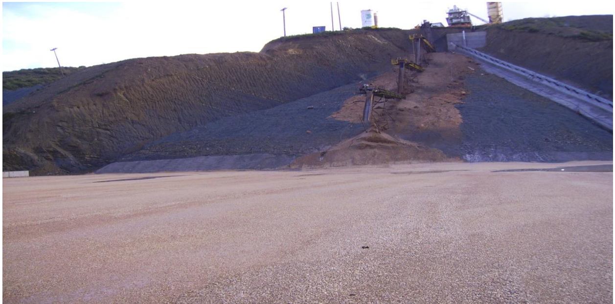
Σχήμα 1.20 Το Φράγμα Φιλιατρινού ποταμού κατά τη διάρκεια κατασκευής (Φεβρουάριος 2012)
