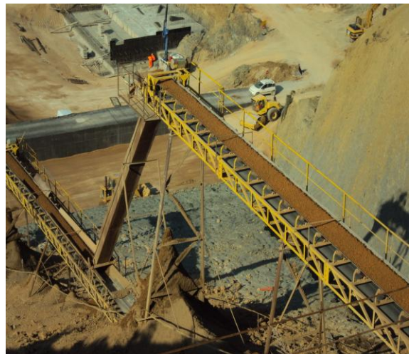
Σχήμα 2.3 Παραγωγή και μεταφορά Σκληρού Επιχώματος στο Φράγμα Φιλιατρινού Ποταμού
