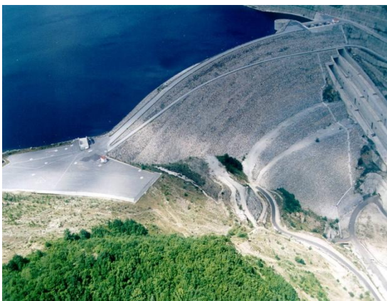
Σχήμα 1.14 Χωμάτινο φράγμα Καστρακίου στον ποταμό Αχελώο
