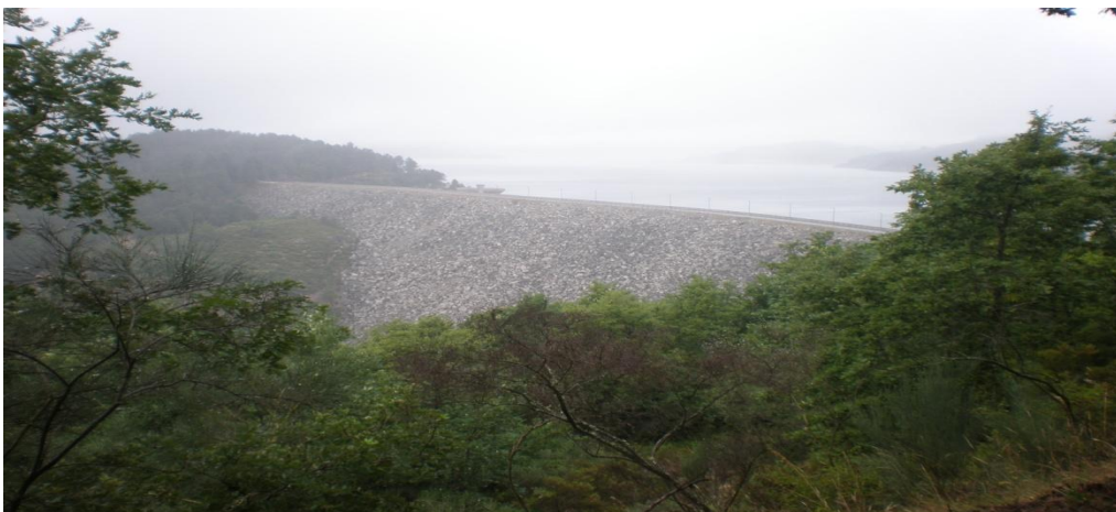
Σχήμα 1.18 Λιθόρριπτο φράγμα Paradela στη Πορτογαλία
