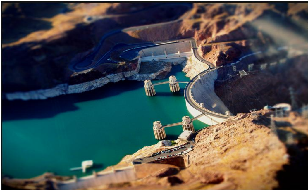
Σχήμα 1.8 Τοξωτό φράγμα Hoover στη Νεβάδα
