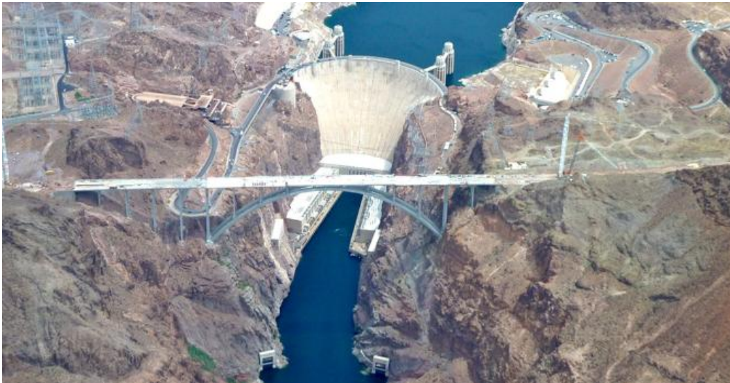
Σχήμα 1.7 Τοξωτό φράγμα Hoover στη Νεβάδα
