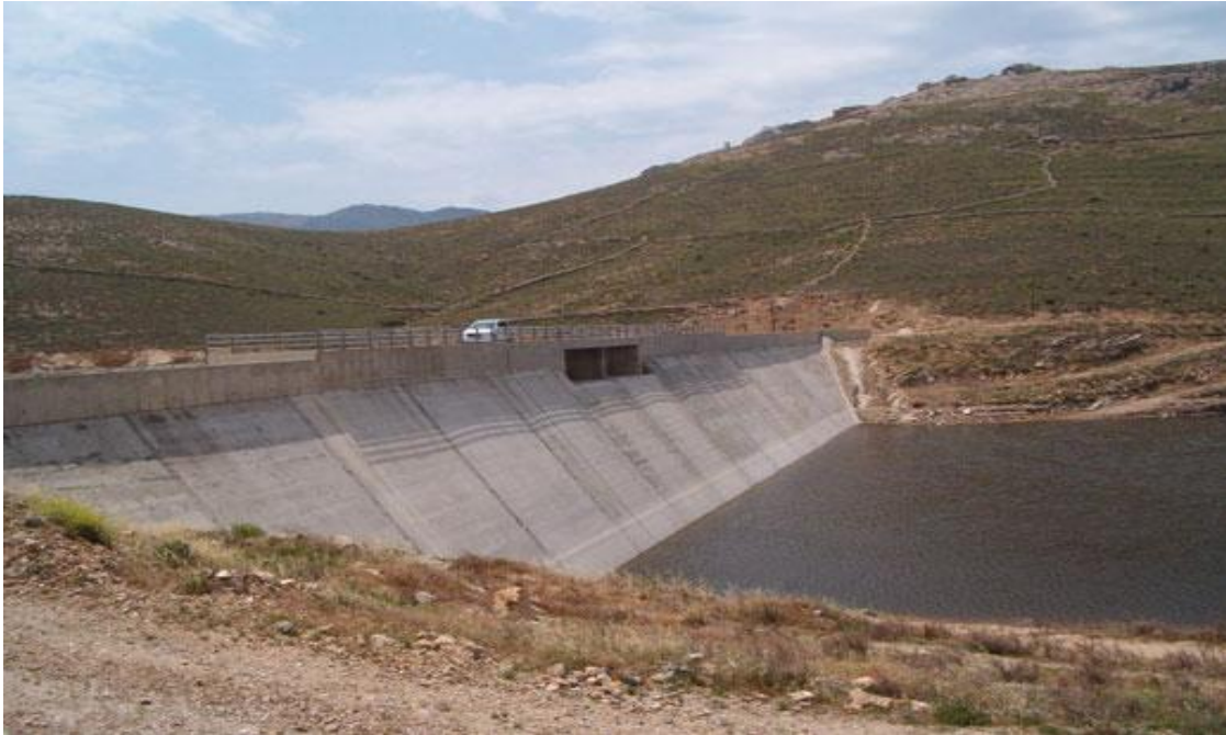
Σχήμα 2.1 Φράγμα στο Στενό Σερίφου
